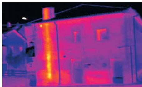
Muro de ladrillo enfoscado sin aislamiento. Se puede observar claramente el recorrido de la chimenea.
