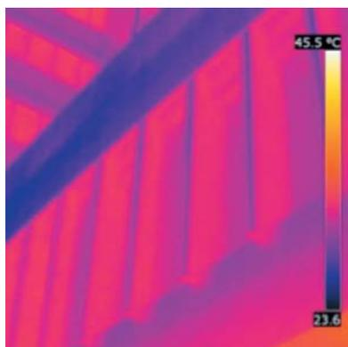
La imagen muestra un termograma del exterior del edificio, fachada noroeste. Al igual que en la imagen anterior se observa la diferencia térmica entre el cerramiento y huecos, siendo en este caso menor la evidencia debido al completo sombreado de la fachada durante la mayor parte del día.
