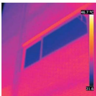
En la imagen se identifican otros puentes térmicos del edificio, para eliminar totalmente los mismos sería necesaria una obra de rehabilitación de gran envergadura.
