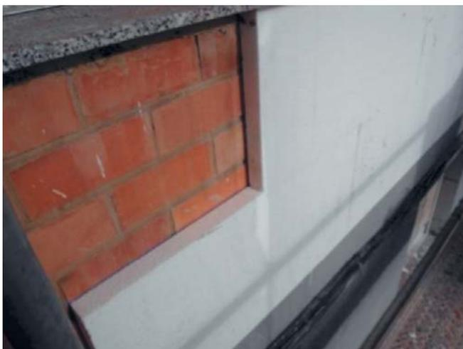
**Fotografía 4.** Placas de poliestireno expandido colocadas sobre la fachada original.
