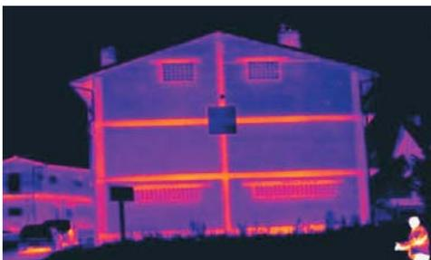
Fachada Sur. El muro de ladrillo dispone de menor densidad, y una conductividad e inercia térmica intermedias. El aislamiento del muro no alcanza a los forjados ni dinteles. La temperatura de los frentes de forjados varía, en correspondencia con la situación de los radiadores.
