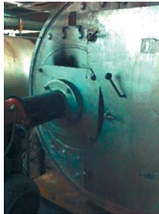
Figura 2. Caldera con junta deteriorada.
