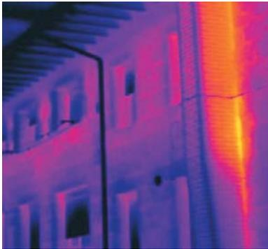
Defecto constructivo en la chimenea que origina pérdidas localizadas de calor.
