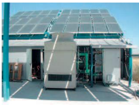
Foto 2. Torre de refrigeración y a la derecha las unidades Yazaki de refrigeración por absorción. Fuente: Absorsistem.
