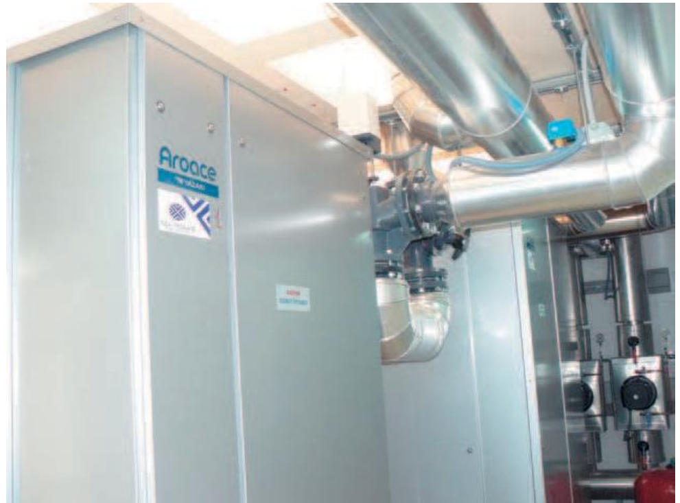
Foto 2. Las dos plantas enfriadoras Yazaki situadas en la sala de máquinas. Fuente: Absorsistem
