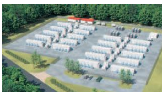
Foto 7. Planta reguladora de frecuencia utilizando SAEBVIs [Beacon, 10].
