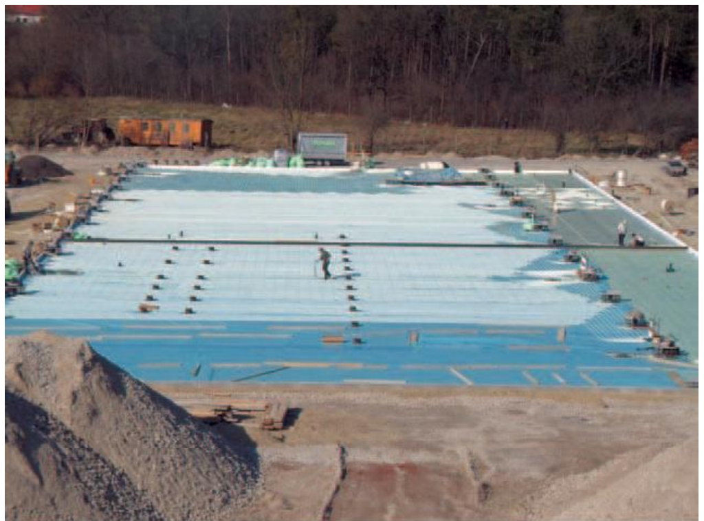
Foto 1. Suelo radiante en construcción (Foto: Citrin Solar).
