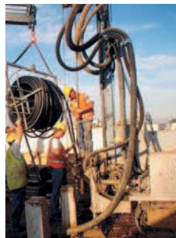
Foto 2. Perforación de los sondeos geotérmicos (izquierda) e introducción de la sonda (U-tube) en la perforación (derecha).
