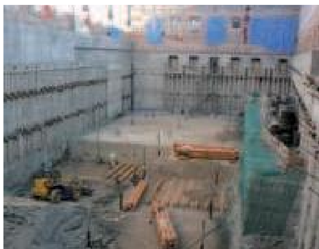
Ejecución de los intercambiadores geotérmicos verticales del sistema de climatización y los intercambiadores geotérmicos horizontales del sistema de pretratamiento del aire de renovación. Fuente: Eneres
