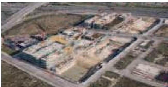
Vista general de las obras en ejecución. Fuente: BBVA
