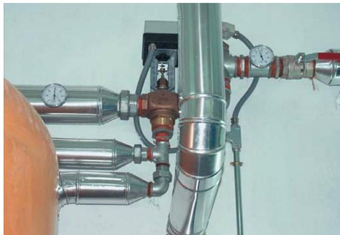
Figura 2.1. Termómetros bimetálicos.
