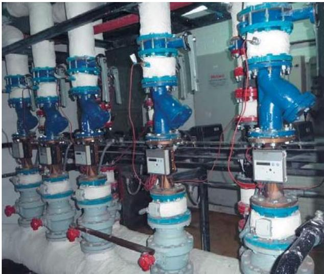
**Figura 7.10.** Fotografía de contadores de calorías instalados en 5 circuitos.
