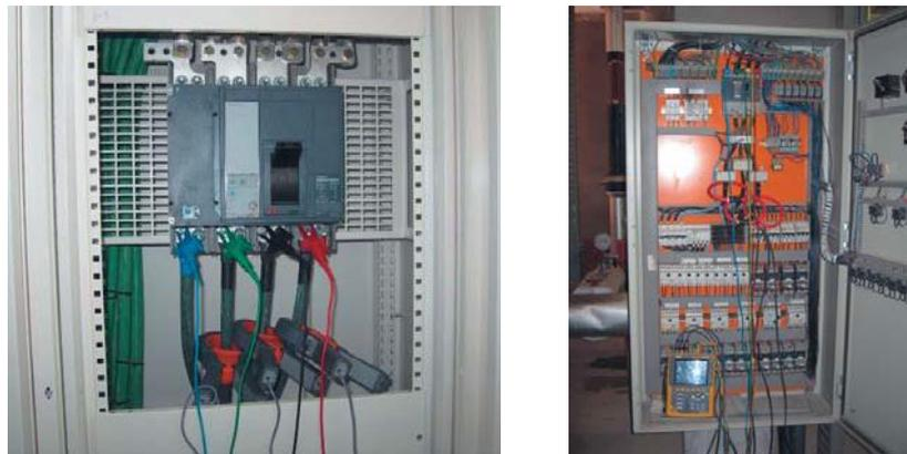
**Figura 7.5.** Conexión de analizador de redes eléctricas a interruptor general del cuadro.
