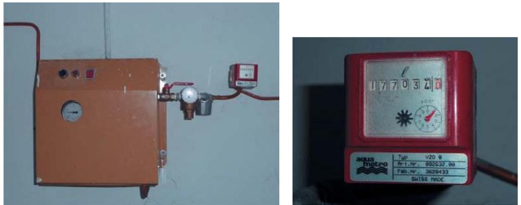
Figura 7.9. Fotografía de contador de gasóleo C.
