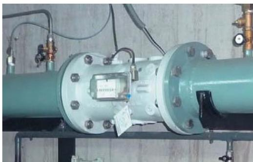
**Figura 7.8.** Fotografía de contador de gas de la compañía.
