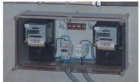
**Figura 7.7.** Fotografía de vatímetro fijo para cuadro (izquierda) y contador eléctrico (derecha).
