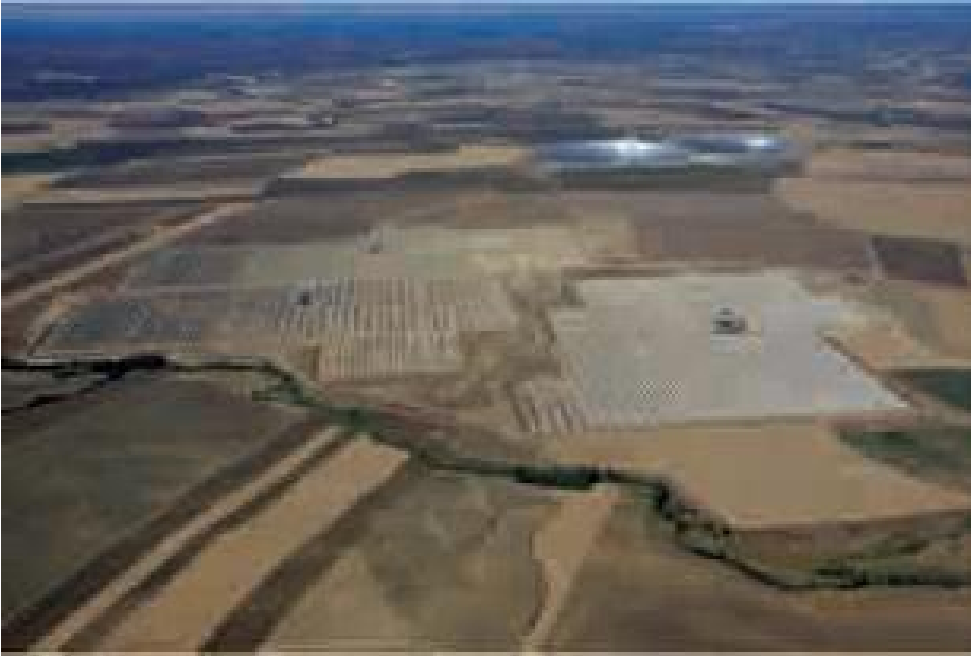
Foto 33. Vista aérea de la plataforma Solúcar en verano de 2010 con PS10 y PS20 al fondo.
