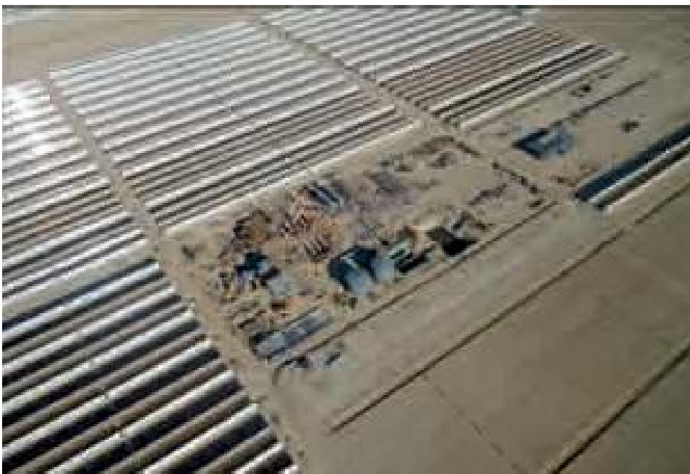
Foto 5. Instalación de Equipos Principales Aste 1A. Julio 2011.
