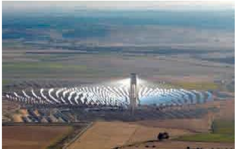
Foto 23. Vista aérea de PS10 en operación solar.
