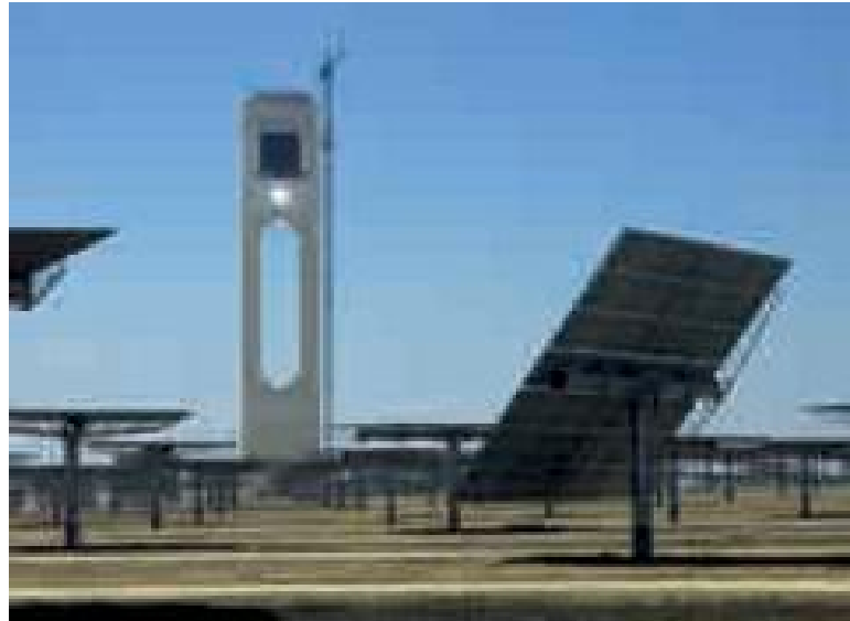
Foto 18. Pruebas de apunte de heliostatos sobre la diana calibración.
