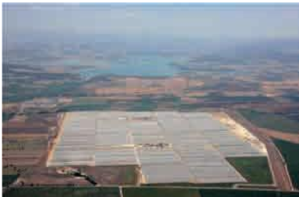
Foto 16. Vista aérea de las plantas Valle 1 y Valle 2 de Torresol Energy.
