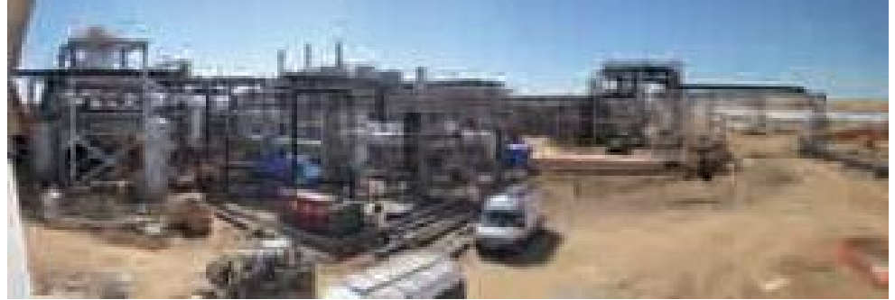
Foto 6. Montaje Tuberías Bloque de Potencia Astexol 2. Agosto 2011.
