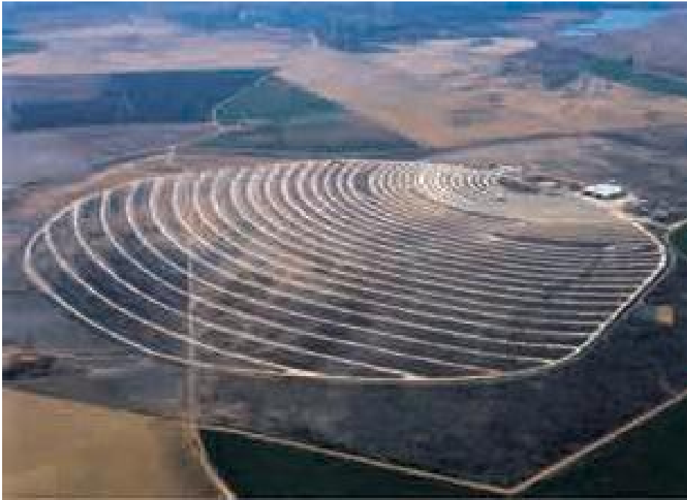
Foto 12. Vista aérea de la construcción de PS10 por junio de 2005.
