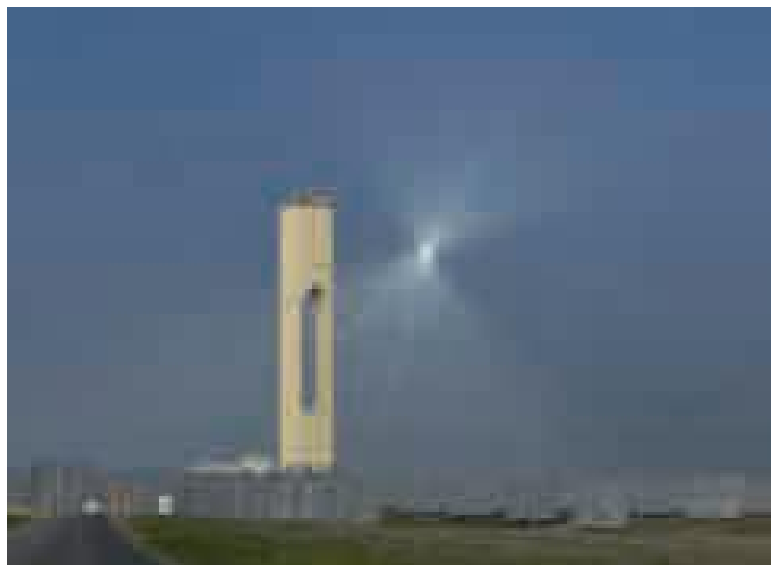
Foto 19. Heliostatos a foco de stand-by durante la realización de las pruebas de «Desenfoco de emergencia».
