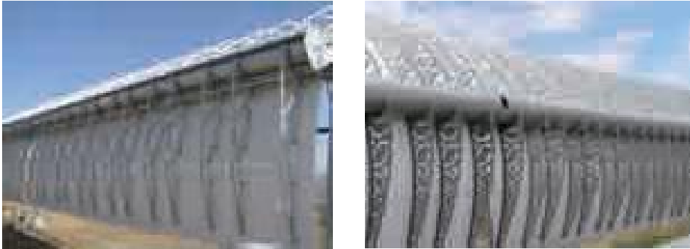
Foto 1. Algunos ejemplos de nuevas estructuras para captadores cilindroparabólicos.
