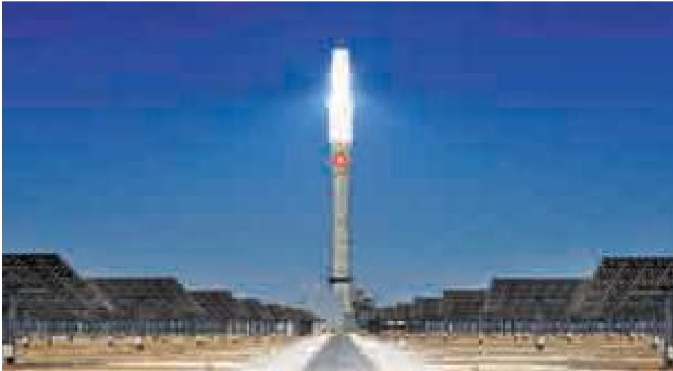
Foto 5. Vista del receptor central en operación.
