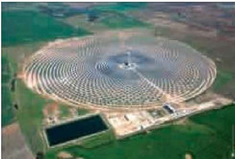
Foto 14. Vista aérea de la planta Gemasolar en diciembre de 2010.
