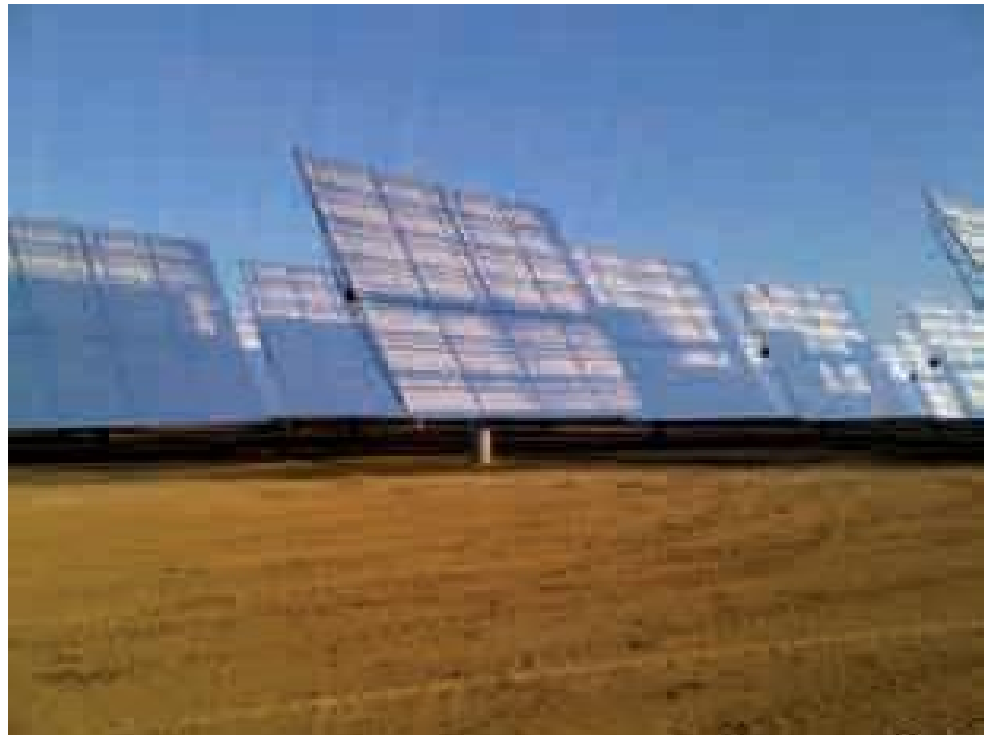
Foto 27. Vista de los heliostatos de PS10 helados en el arranque de una mañana de invierno de 2009.
