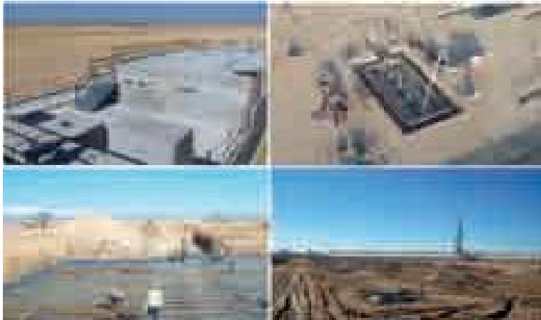
Foto 4. Cimentaciones CCP. De izquierda a derecha: cimentaciones turbina, edificio eléctrico, tanques HTF y pilotes campo solar.
