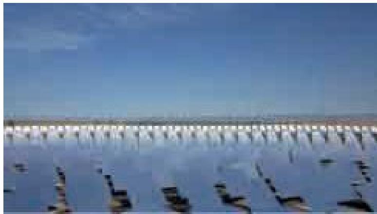
Foto 3. Campo de heliostatos en operación.
