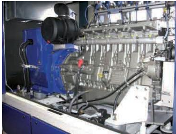
Foto 4. Generador (en azul) refrigerado por aire del equipo Senergino S5 (Altare).
