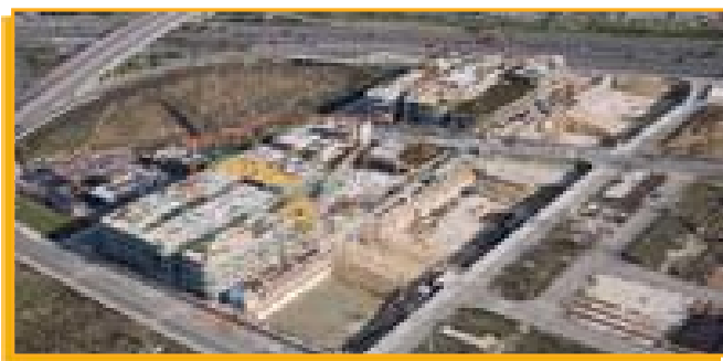
Vista general de las obras en ejecución. Fuente: BBVA
