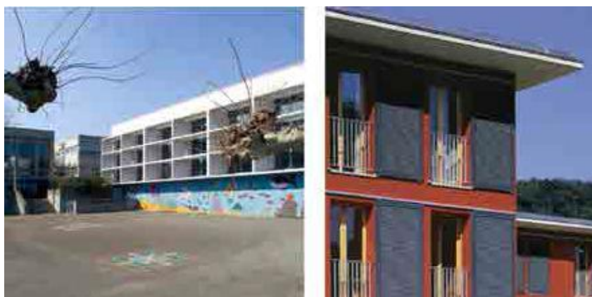
Figura 24. Escuela Spiegelfeld en Binningen climatizada con energía de las aguas residuales. Fuente: ENERES/KASAG.
