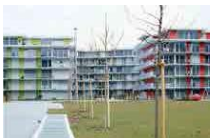
Figura 29. En el distrito de Wässerwiesen en Winterthur, 400 apartamentos están calefactados energía de intercambio con aguas residuales. Fuente: ENERES/KASAG.
