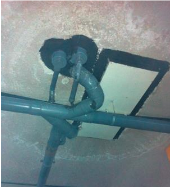
Imagen 1. Imagen visible de una bajante.
