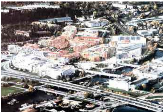
Figura 25. El centro de Sandvika, climatizado con la energía de las aguas residuales. Fuenet: ENERES/KASAG.
