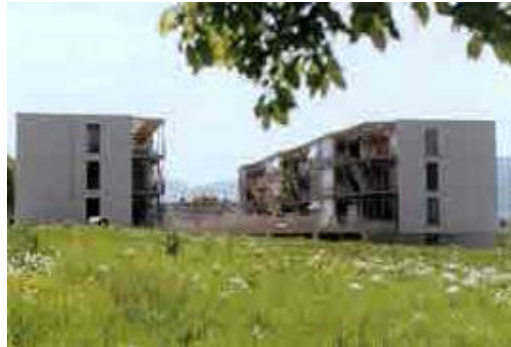
Figura 17. Zurich-Wollishofen, un conjunto de 200 apartamentos se benefician de la recuperación de calor de la red general de aguas residuales. Fuente: ENERES/KASAG.
