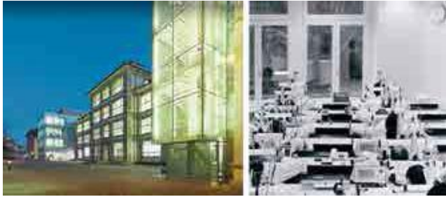
Figura 31. Sede central de la relojera IWC. Schaffhausen. Puestos de trabajo climatizados con la energía recuperada de las aguas residuales. Fuente: ENERES/KASAG.
