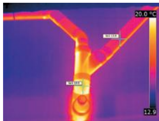
Imagen 15. Inspección de toda la red de aguas fecales, en PVC, para hallar posibles sedimentos en las tuberías y fugas.
