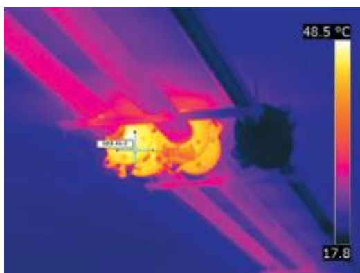
Imagen 12. En la distribución de agua a las viviendas llama la atención que se hayan colocado también dilatadores.
