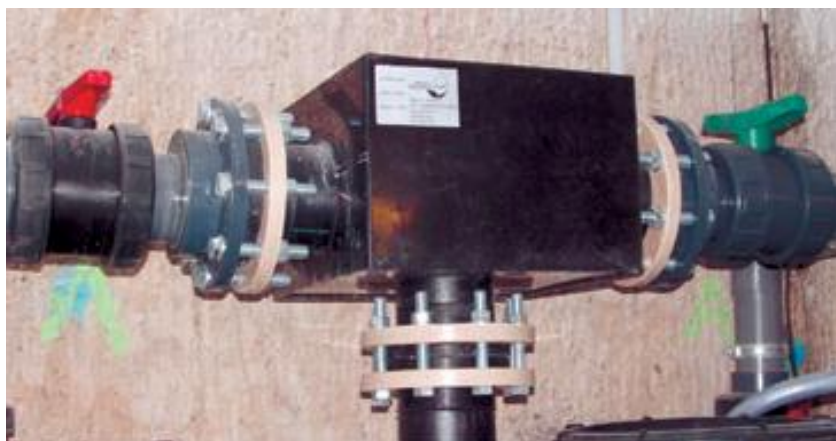
Foto 4. Filtro de rejilla embridado para un sistema de reutilización de aguas grises.
