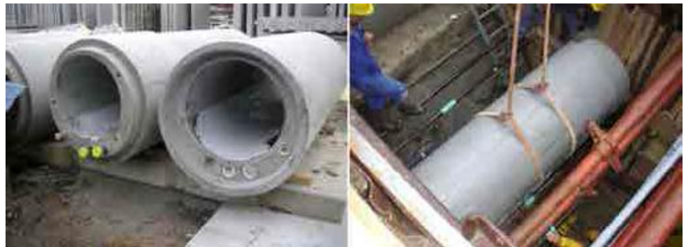
Figura 19. Las instalaciones de recuperación de calor de las aguas residuales están formadas por componentes cuya vida útil puede llegar a los 50 años, como por ejemplo un intercambiador de calor. Fuente: ENERES/KASAG.
