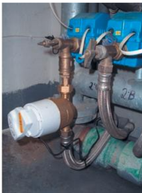
Figura 5. Contador volumétrico con emisor de pulsos.
