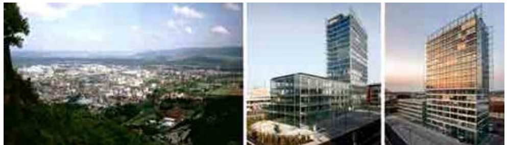
Figura 32. Singen. Viviendas urbanas. Torre Hegau 2009. Fuente: ENERES/KASAG.
