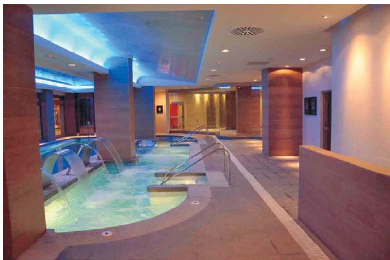
Fotografía 2. Control de energía en agua y ambiente. Fuente: Alter Technica.
