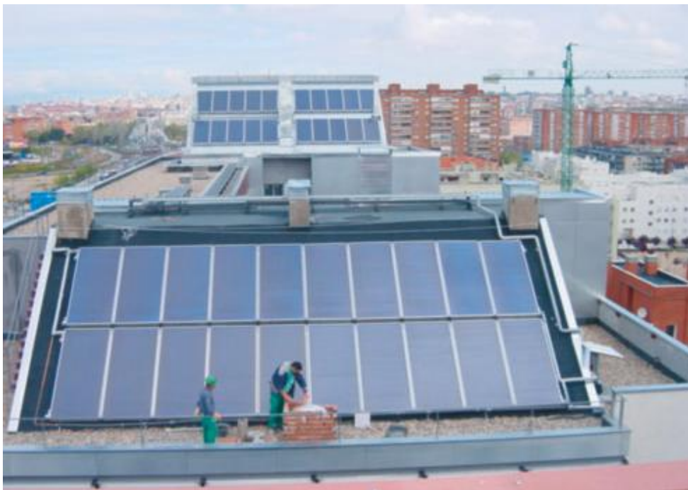
Figura 11. Ejemplos de integración solar con colector plano.
