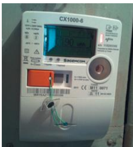
Figura 6. Contador electrónico monofásico para telemedida y telegestión.
