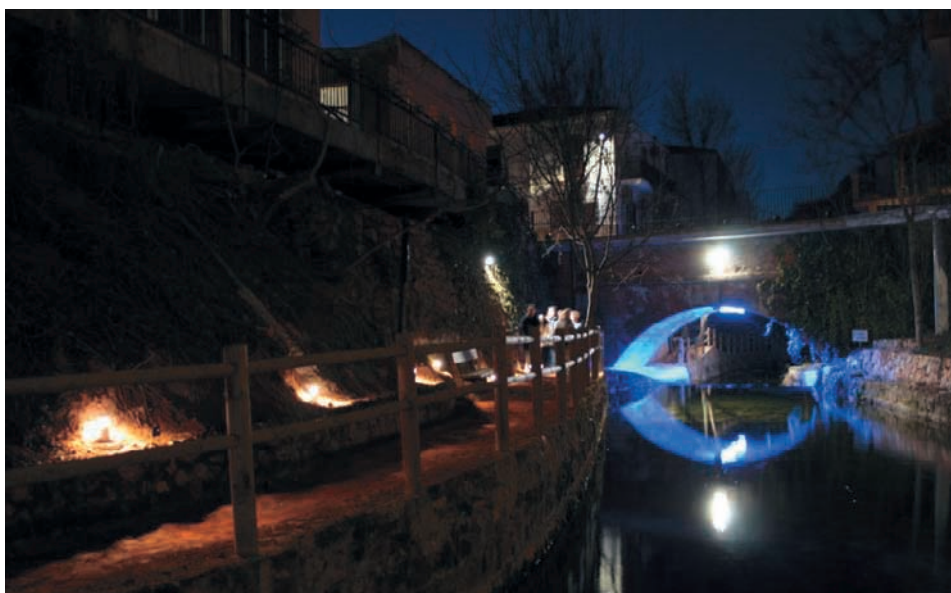
Figura 13. Nueva iluminación en los puentes
