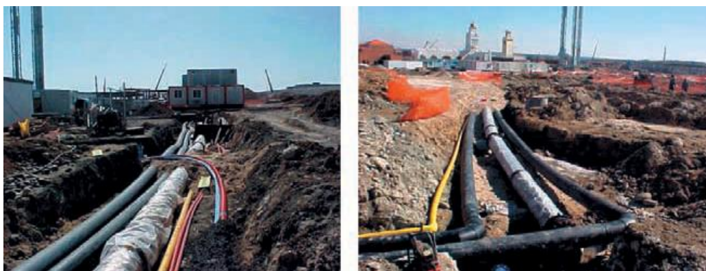
Foto 1. Instalación de red primaria de riego en parque temático. Fuente: Marcos Pérez
