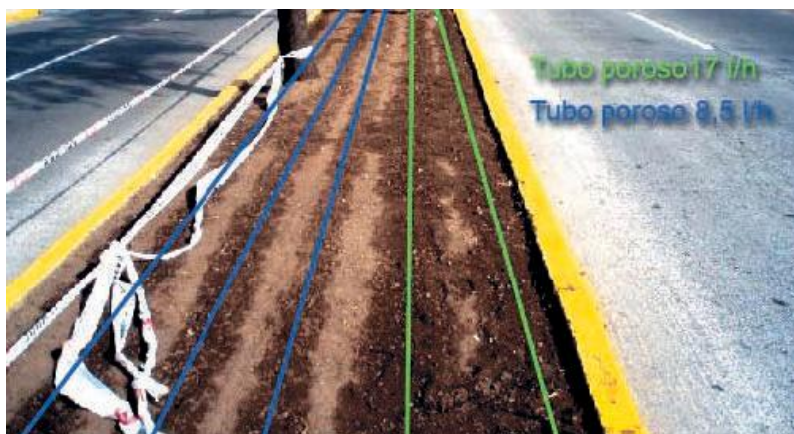
Figura 10. Distribución de riego no uniforme por empleo de goteros de distinto caudal. Fuente: Audit Irrigation
