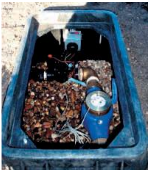
Foto 2. Equipo Terminal Remoto -función caudal- y -función programador-, ambos alimentados con pila de 9V. Fuente: Samcla
