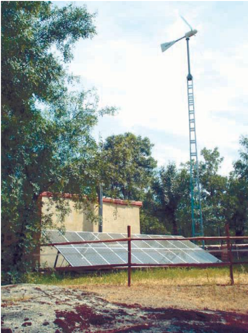
Foto 2. Ejemplo de sistema híbrido: energía solar + energía fotovoltaica. Fuente: Abaco Ambiental
