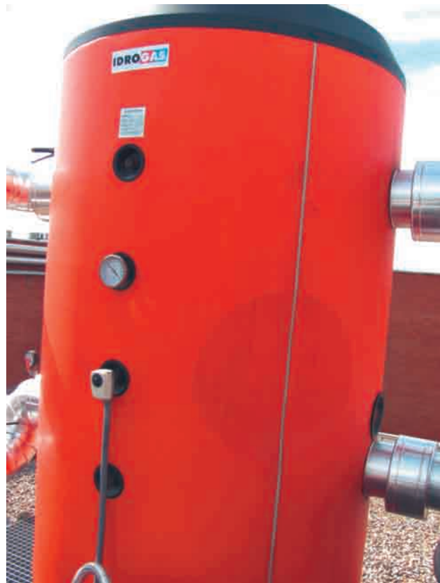
Foto 4.5. Depósito de inercia para centro logístico de la Comunidad de Madrid. Fuente: Geoter.
