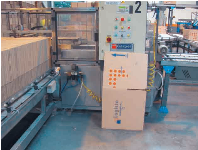
Foto A1.3. Zona de almacenamiento y producción en centro logístico de la Comunidad de Madrid. Fuente: Geoter.
