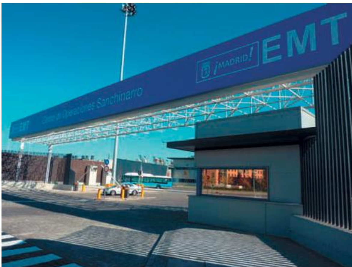
Figura 3.17. Acceso a las instalaciones de Sanchinarro. Fuente: EMT, 2013.
