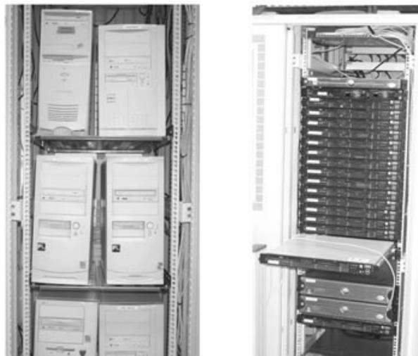
**Ilustración.** Equipos en alojamiento tradicional frente a equipos “*enracables*” de alta densidad.
