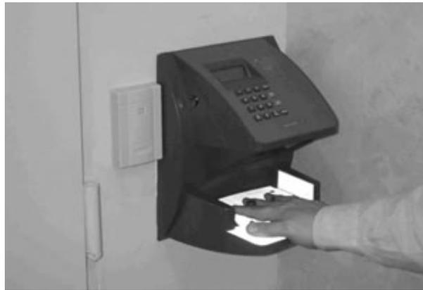
**Ilustración.** Control de acceso tarjeta de presencia + lector biométrico.
