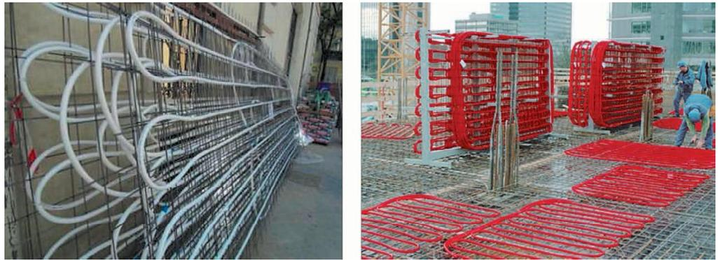
**Figura 5.18.** Suministro de circuitos de intercambio premontados sobre un entramado de acero que queda embebido en la losa termoactiva. Es importante señalar que el diseño de los intercambiadores permite adecuar el flujo de energía en las losas a las necesidades de equilibrio térmico de distintas partes del edificio. Fuente: UPONOR/REHAU.
