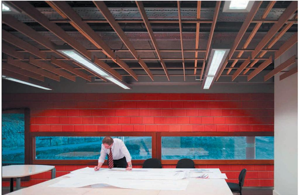
**Foto 3.13.** Diseño interior de los espacios de la sede de IDOM en Madrid. Tampoco se reviste el acabado de la fachada para poder aprovechar toda su inercia térmica.
