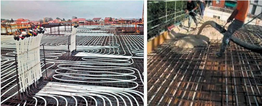
**Figura 5.17.** Instalación de intercambiadores y colectores de una losa termoactiva, en la fotografía se pueden apreciar los extremos cerrados con llave y manómetro de los circuitos que durante la ejecución se mantienen presurizados. Proceso de hormigonado de una losa termoactiva.
