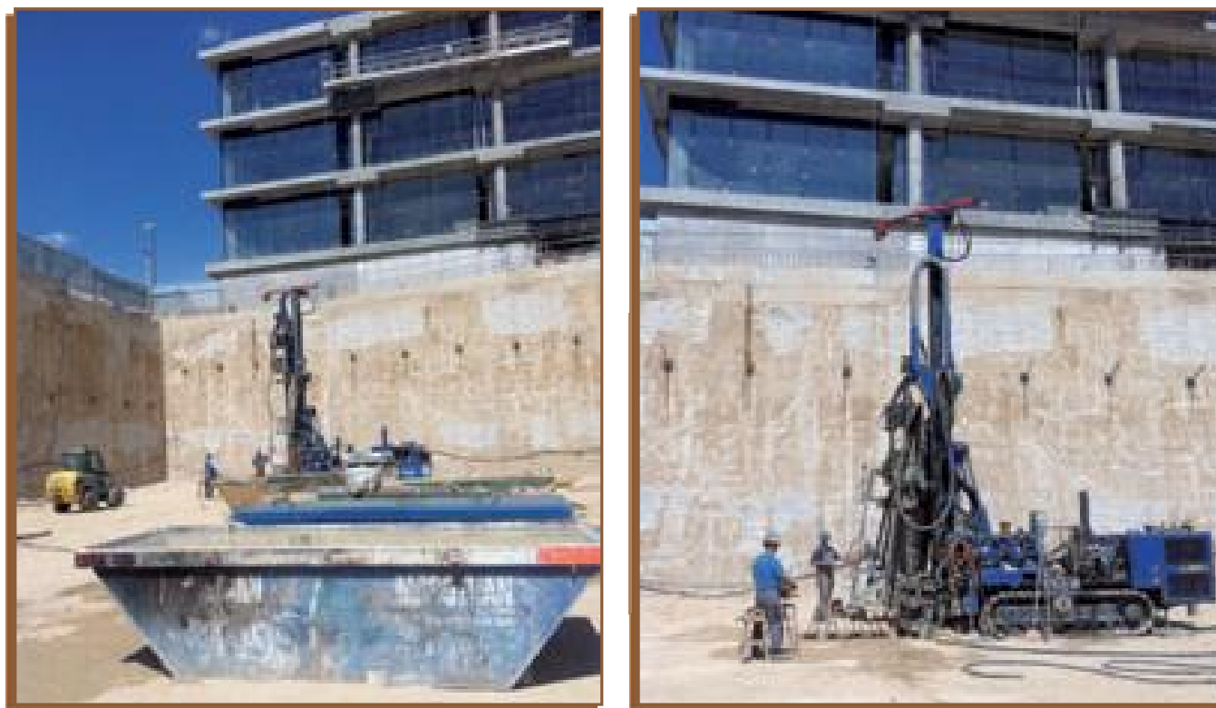
Figura 3. Labores de perforación de los sondeos geotérmicos
