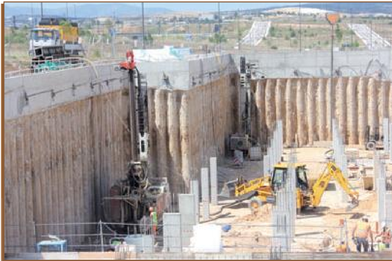
Detalle de ejecución de las perforaciones geotérmicas
