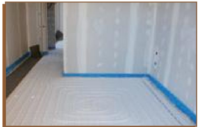
Instalación de suelo radiante
