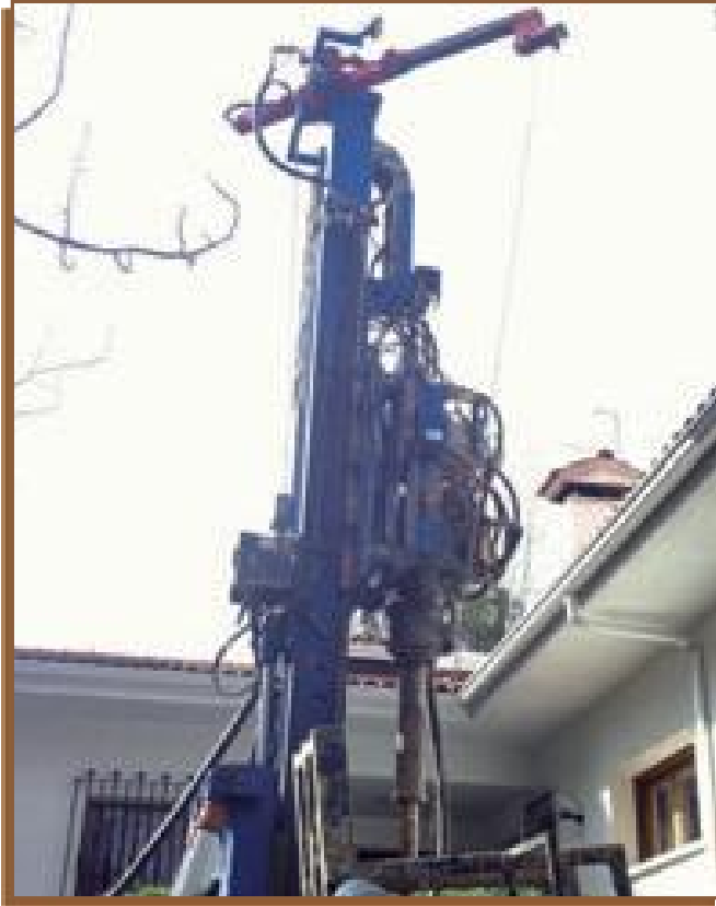
Figura 1. Labores de perforación de los sondeos geotérmicos
