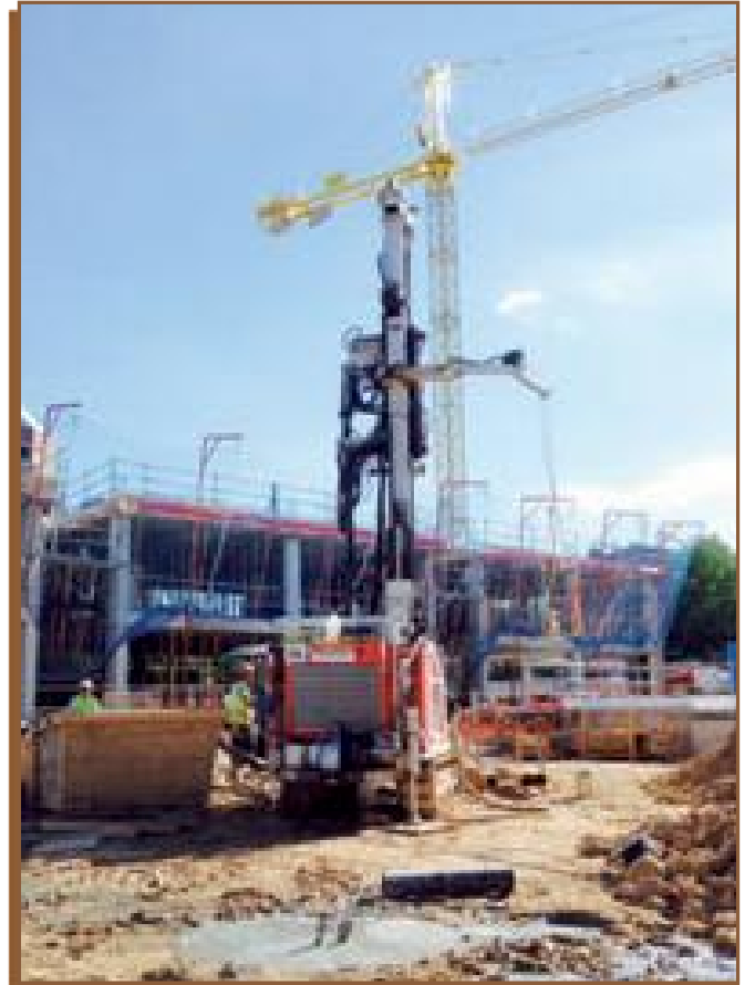
Figura 2. Labores de perforación de los sondeos geotérmicos
