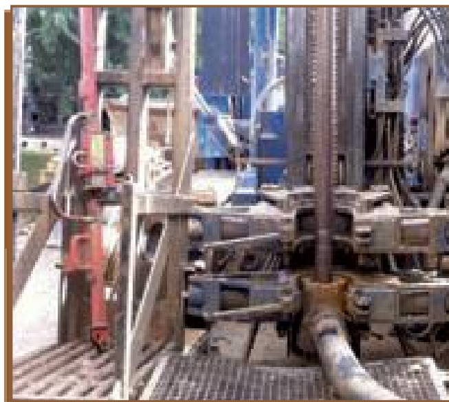
Figura 3. Labores de perforación de los sondeos geotérmicos II
