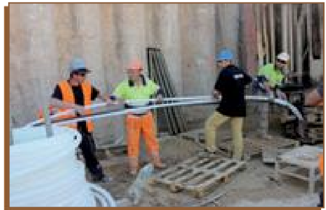
Detalle de la instalación de la sonda Geo Uponor PEX
