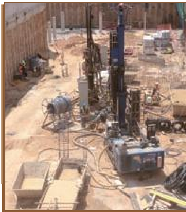
Figura 3. Labores de perforación de los sondeos geotérmicos
