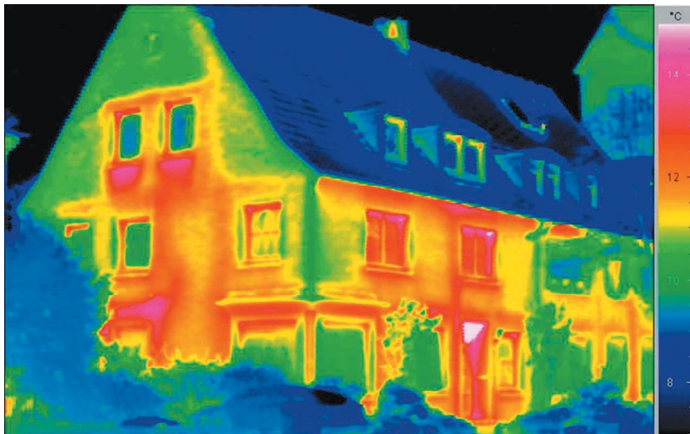
Figura 1. Pérdidas térmicas en un edificio residencial con un sistema deficiente de aislamiento.
