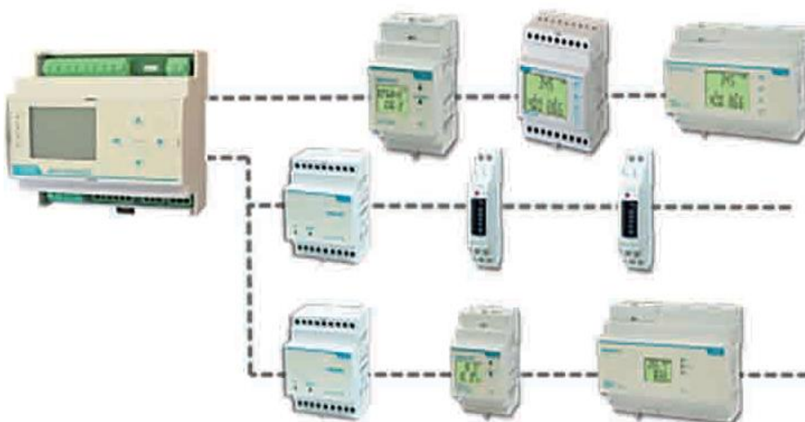
Figura 9. Contadores y analizadores de red conectados a una única plataforma de gestión energética.
