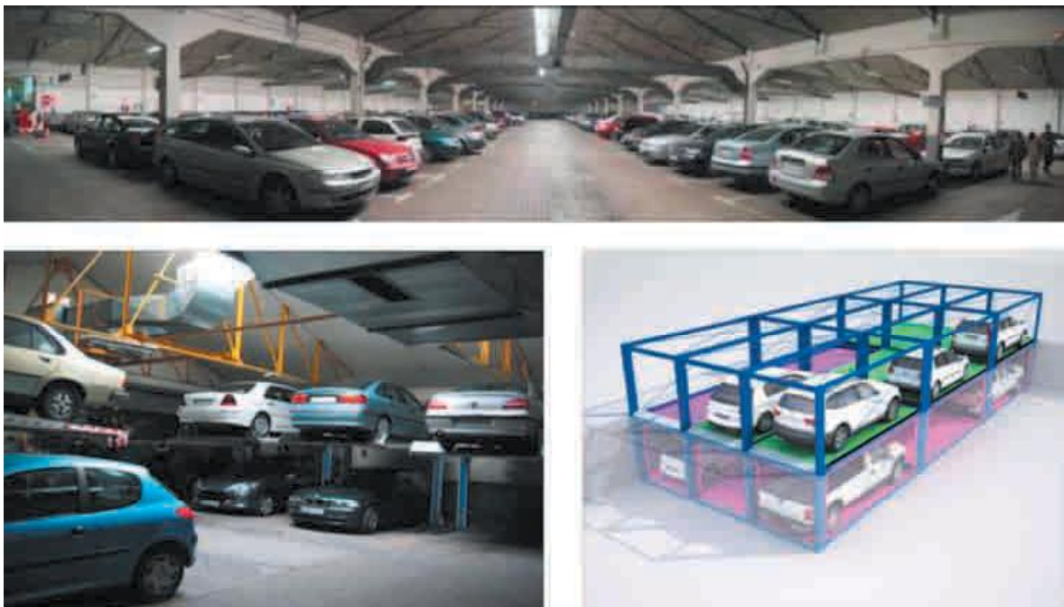
Figura 8.15. Los edificios industriales de muchos concesionarios son susceptibles de ser aprovechados en todo su volumen y optimizados en cuanto al espacio de circulación y acceso para obtener con sistemas semiautomáticos de varias filas, columnas y niveles de apilamiento, un aprovechamiento muy superior al original. Imágenes de la optimización con sistemas de apilamiento dobles de un estacionamiento en nave industrial en Madrid.
