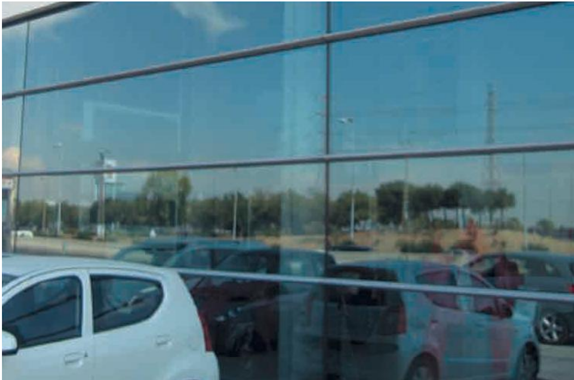
Foto 7.3. Concesionario con doble acristalamiento de control solar oscuro. Juntas verticales a hueso. Fuente: propiedad del autor.
