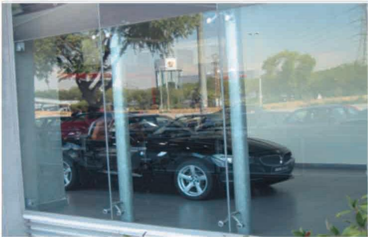
Foto 7.4. Acristalamiento abotonado en sus cuatro esquinas.
