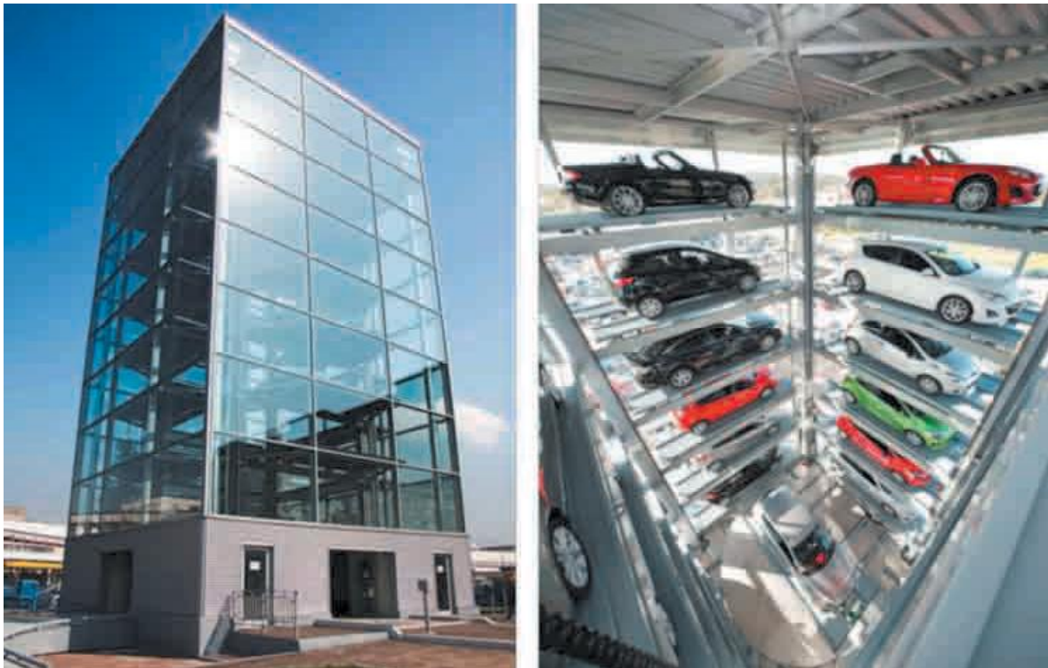
Figura 8.17. Vista general exterior y varias vistas interiores de una sencilla torre de 8 niveles y 32 vehículos.
