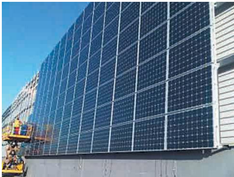
Foto 6.1. Instalación de los módulos fotovoltaicos.
