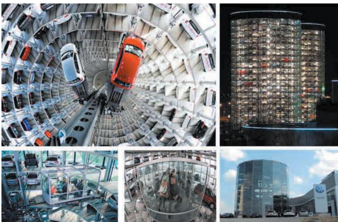
Figura 8.11. Autostadt. Silos de estacionamiento robotizado en el centro de exhibición, junto a la fábrica de Volkswagen en Wolfsburg (Alemania). El estacionamiento es en sí mismo un show room y una atracción que incluso se visita en movimiento dentro de una cabina de vidrio. La potencia de estas imágenes han hecho que se reproduzcan sin cesar en todos los medios, trascendiendo su propia utilidad que, sin embargo, existe a todos los niveles.
