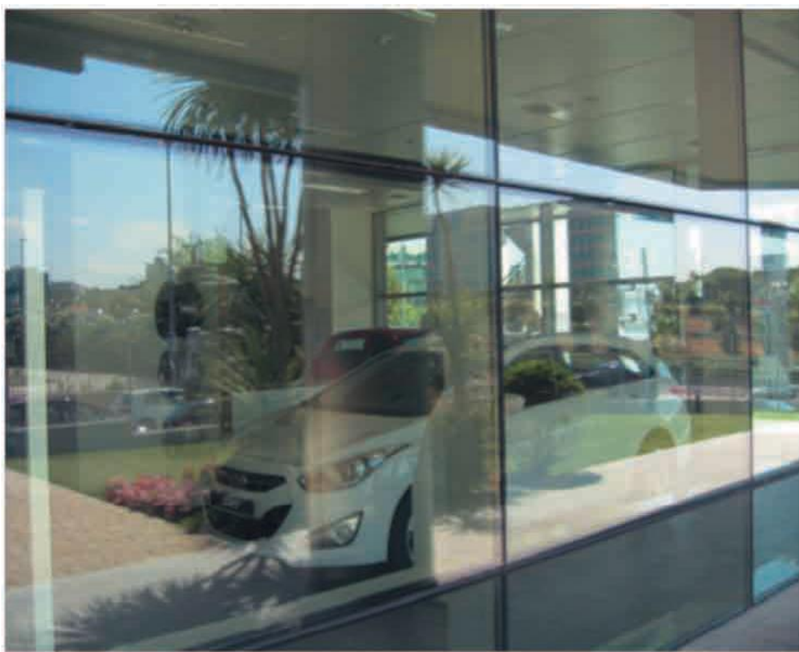
Foto 7.23. Concesionario acristalado con UVA de altas prestaciones con vidrio bajo emisivo y control solar con reflexión similar a la solución tradicional. Interior visible en condiciones de iluminación. Fuente: propiedad del autor.
