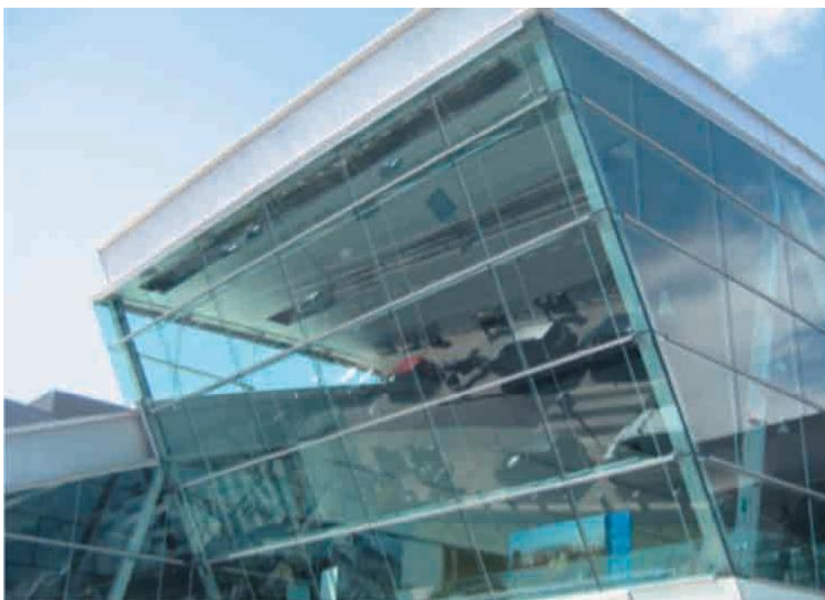
Foto 7.5. Concesionario concebido como fachada acristalada dotado de vidrios laminados y lámina exterior de control solar. Fuente: propiedad del autor.
