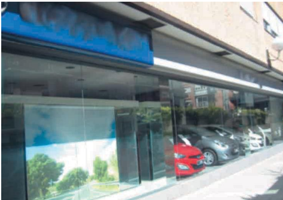
Foto 7.16. Exposición muy soleada (orientación O, (16:16 h). Acristalamiento laminar tradicional con grandes entradas de calor.
