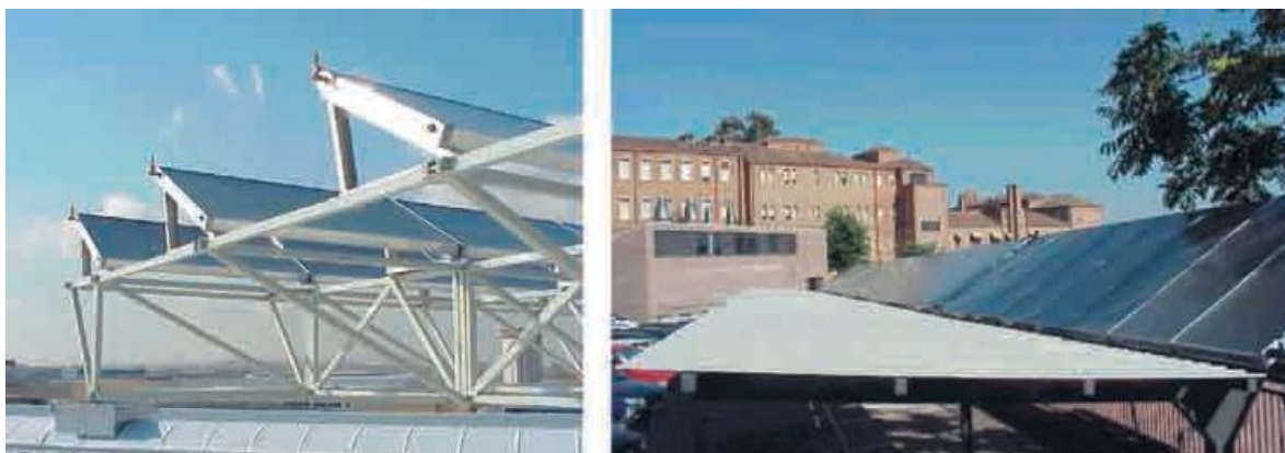
Foto 5.2. Posibilidades de montaje. Colectores planos.
