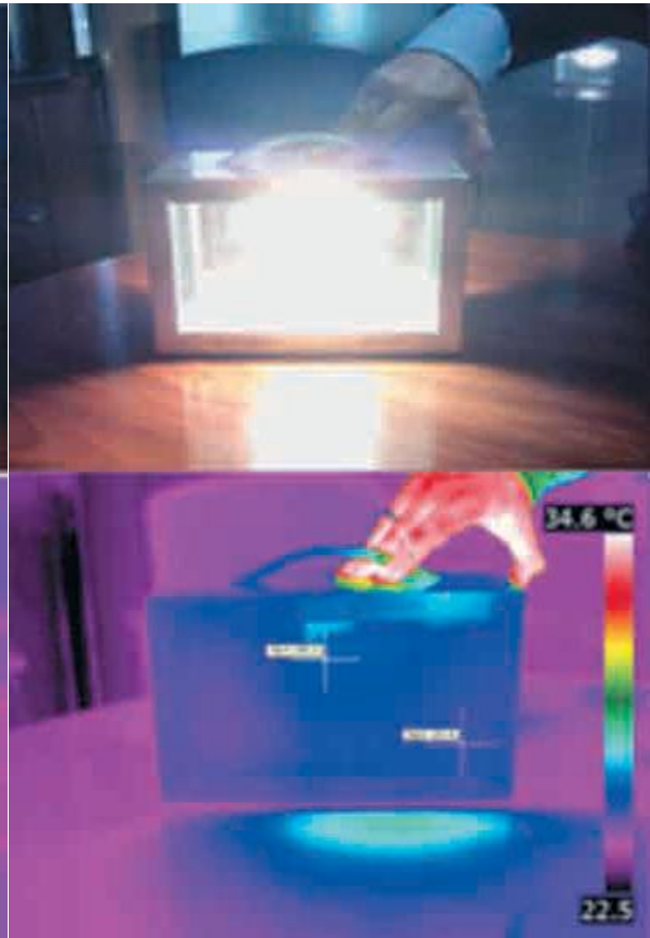
Figura 7.20. Termografía de un doble acristalamiento de ATR SGG CLIMALIT PLUS 4/16/4 neutro de alta selectividad ( U = 1,4 \text{ W/m}^2\text{K} y g = 0,41 ) frente a un foco de calor interno simulado por una lámpara halógena.
