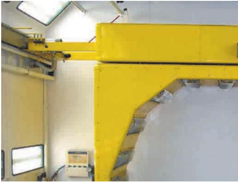
Foto 1.2. Iluminación de cabina de pintura.
