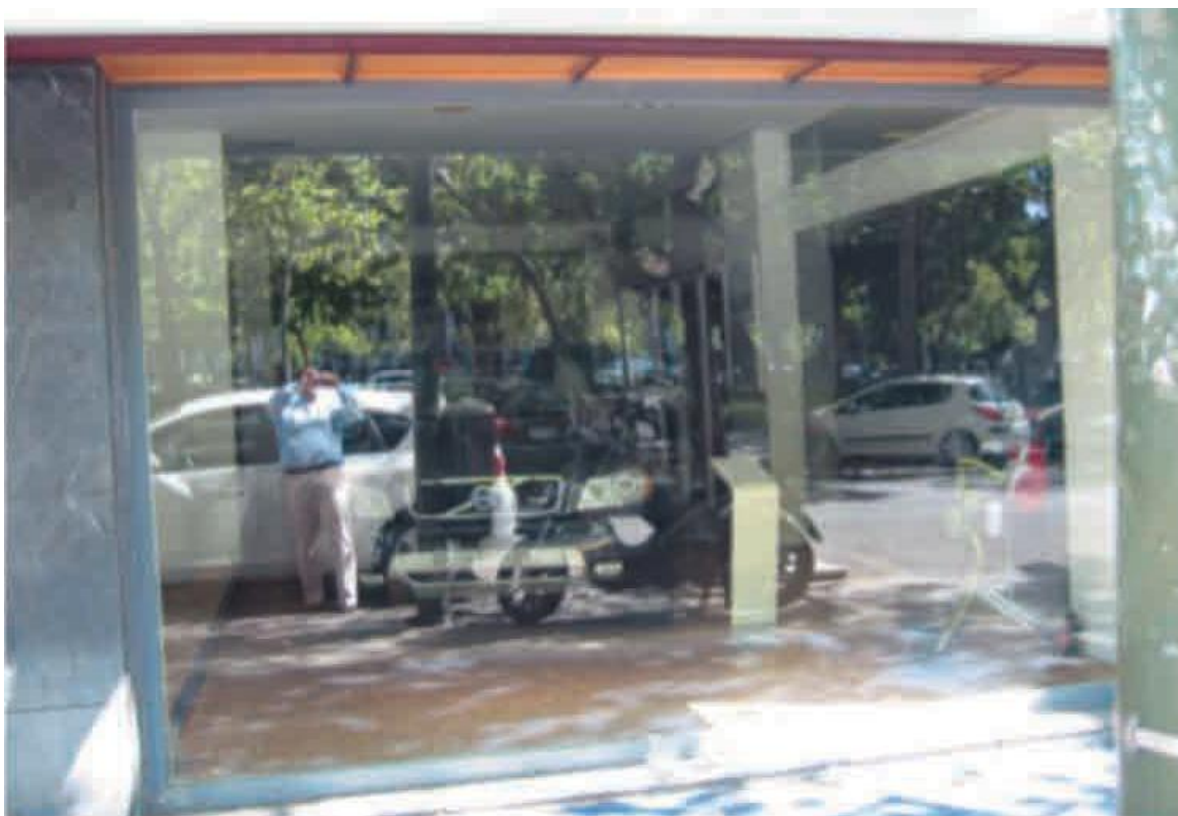
Foto 7.2. Acristalamiento tradicional orientado al oeste reflejando una gran cantidad de luz que impide la visión del interior. Fuente: propiedad del autor.
