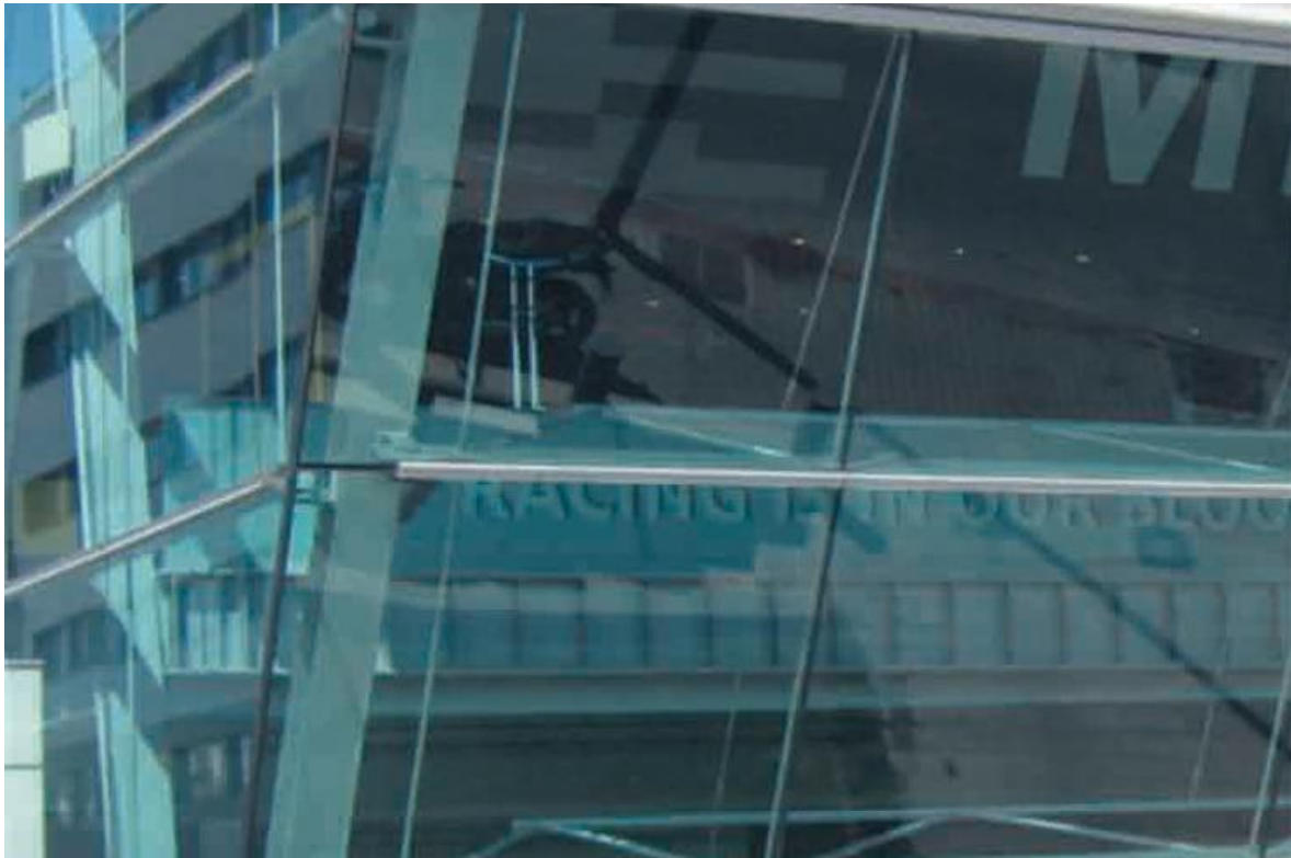
Foto 7.17. Fachada de concesionario (orientación E, 14:10 h) con vidrios laminares de control solar permitiendo ver el interior del mismo. Fuente: propiedad del autor.
