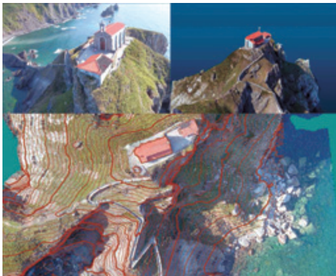
Figura 12.1. Imagen oblicua, modelo 3D y mapa topográfico superpuesto sobre ortofotografía de la Ermita de San Juan de Gaztelugatxe en Bermeo (Vizcaya).
