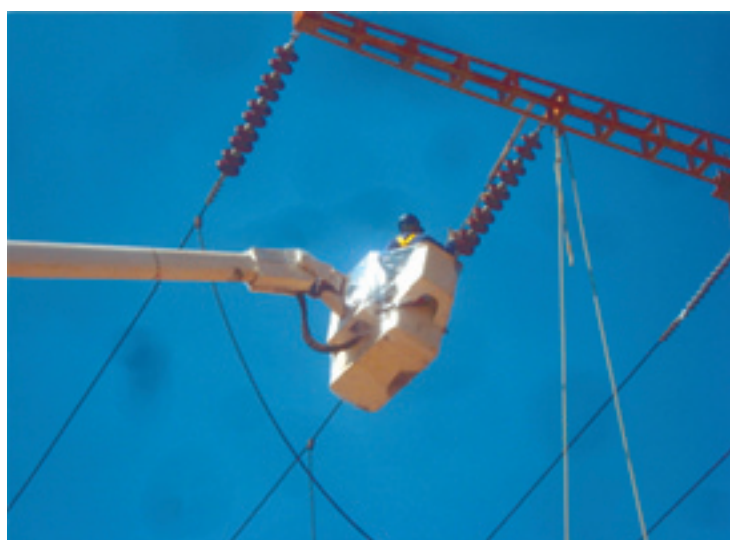
Figura 20.2. Inspección exhaustiva en una posición sin tensión.
