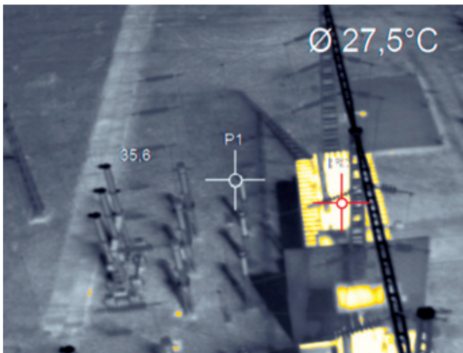
Figura 20.7. Imagen termográfica aérea en una subestación.
