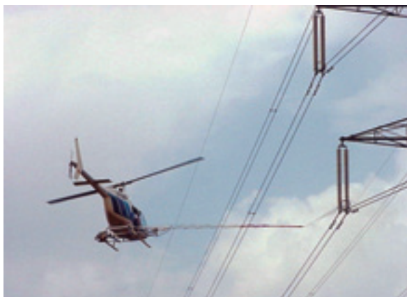
Figura 14.6. Limpieza de aisladores desde helicóptero.
