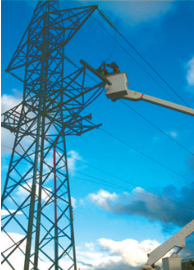
Figura 20.8. Inspección exhaustiva de un apoyo de 132 kV.
