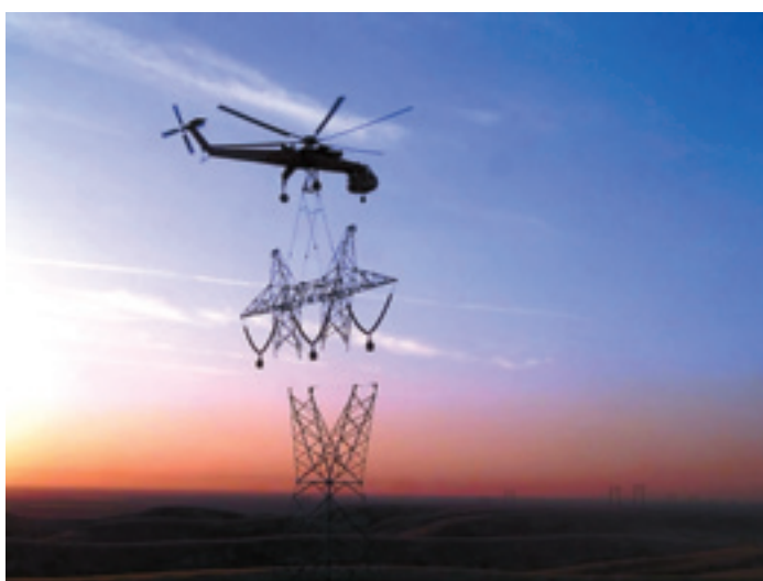
Figura 14.4. Izado de un apoyo por partes utilizando un helicóptero.
