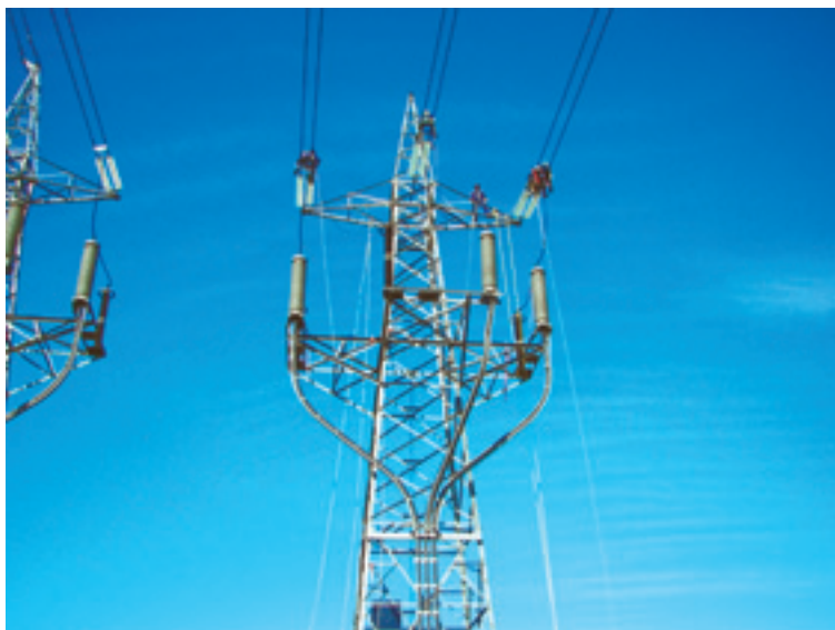
Figura 20.9. Trabajos de inspección en apoyo de 132 kV.
