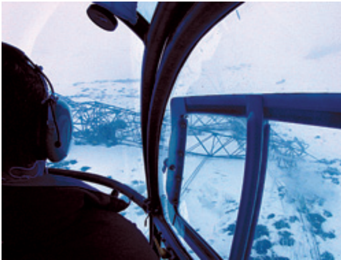
Figura 14.2. Vista desde un helicóptero de un apoyo caído en el suelo.
