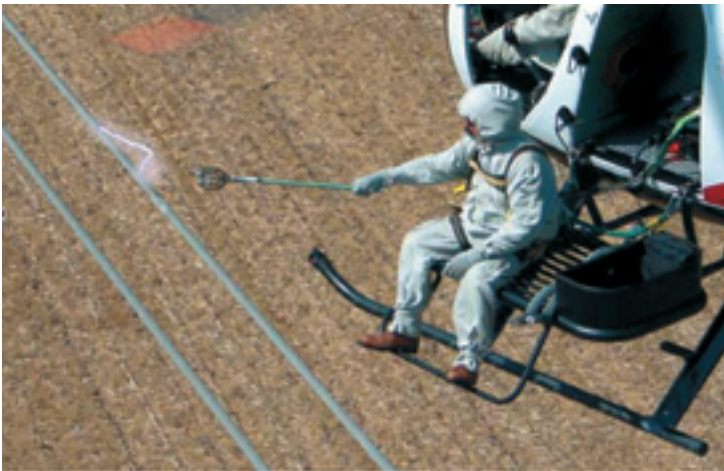
Figura 14.5. Trabajos en tensión desde helicóptero.
