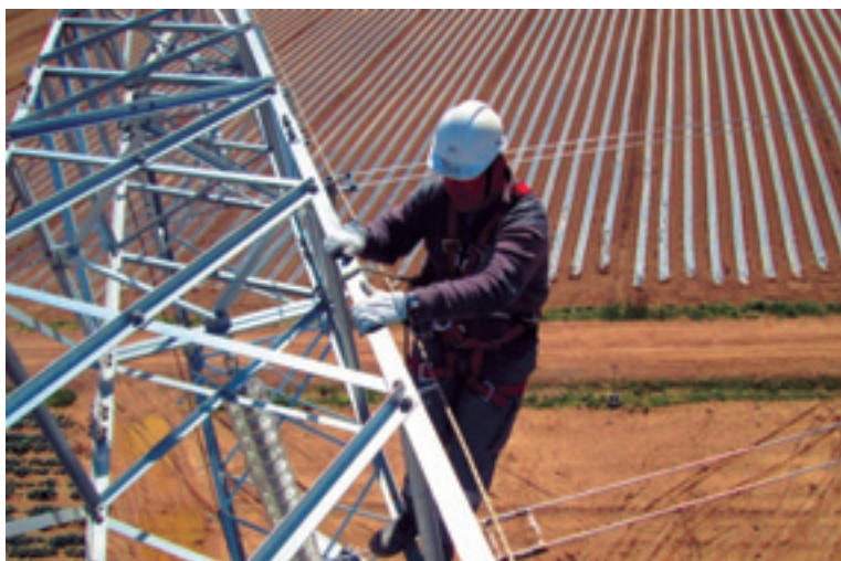
Figura 14.8. Trabajador subido a un apoyo.
