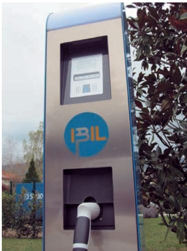
Figura 1. Terminal de carga en modo 3.
