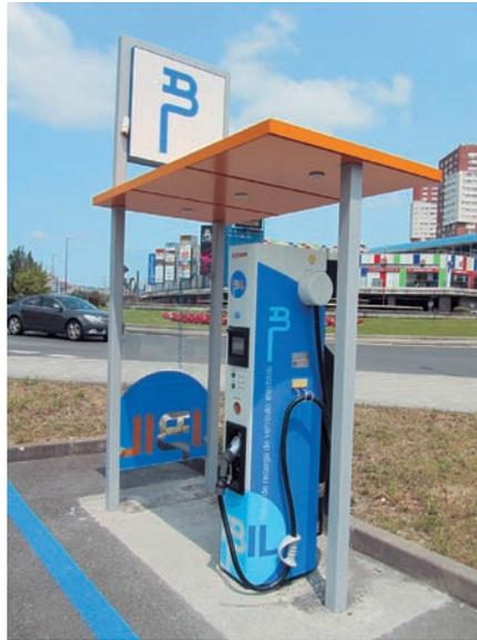
Figura 2. Instalación de carga rápida (modo 4).
