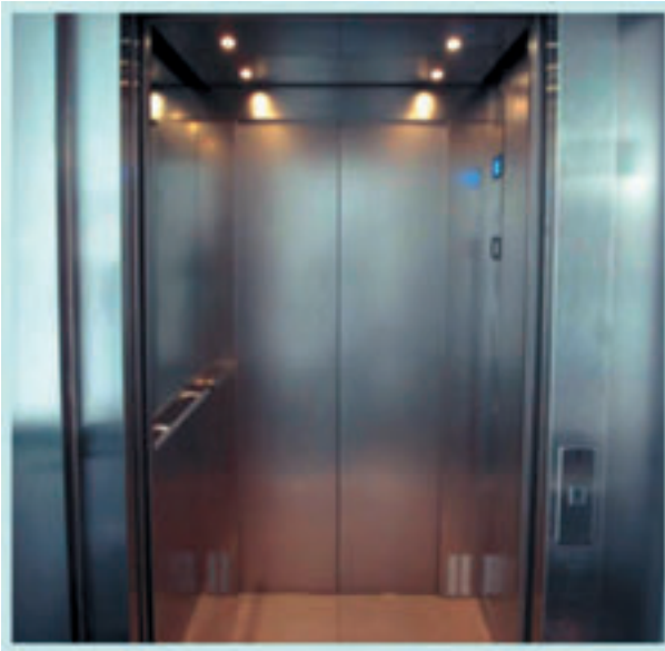
Foto 1: Cabina Iluminada con 6 Lámparas Led de 3 W.
