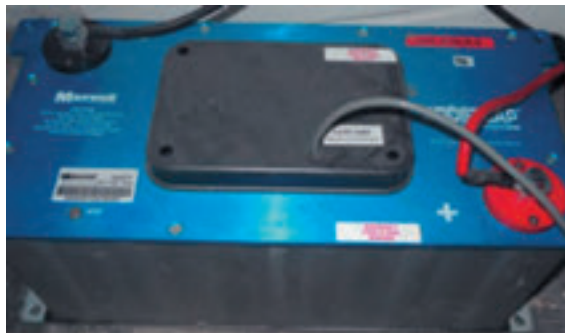
Foto 7. Detalle de la instalación del módulo de ultracapacidades. Fuente: Dúplex Elevación.
