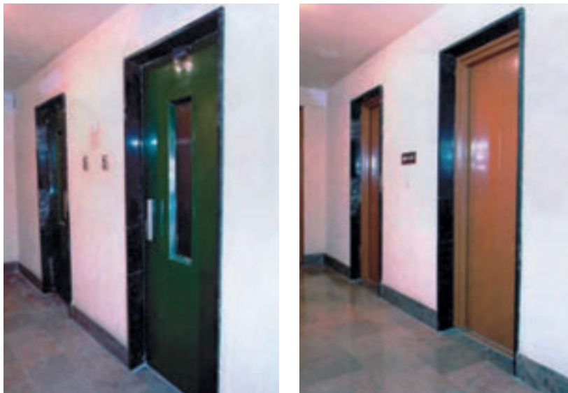
Foto 10. Ejemplo de Modernización de puertas batientes por automáticas. Fuente: ThyssenKrupp Elevadores.
