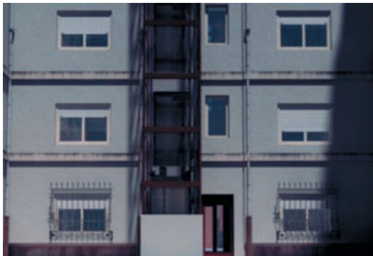
Foto 3. Obra de rehabilitación. Instalación de ascensor por fachada o patio. Fuente: ThyssenKrupp Elevadores.
