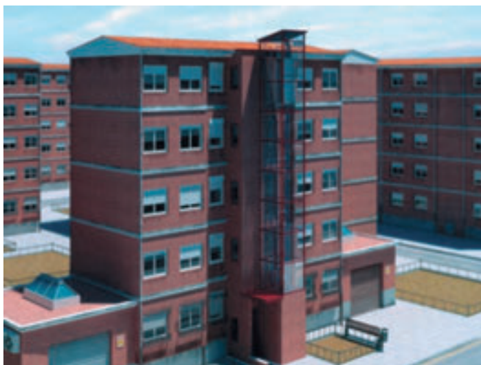
Foto 4. Obra de rehabilitación. Instalación de ascensor por fachada o patio con parada en planta. Fuente: ThyssenKrupp Elevadores.
