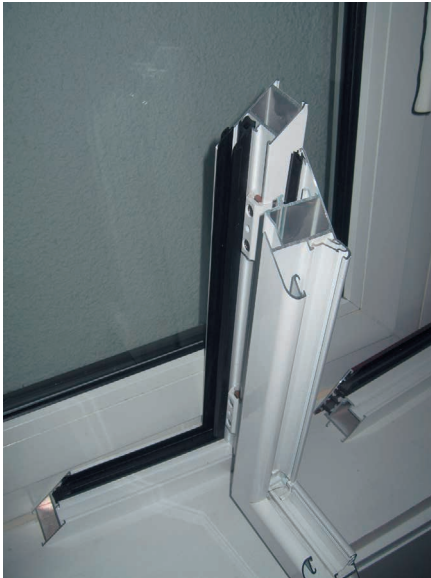
Foto 12.2. Marco metálico sin rotura de puente térmico. Fuente: Propiedad del autor.
