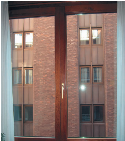
Foto 2.3. Ventana de altas prestaciones energéticas con reducidos valores de U y g, y alta transmisión luminosa con acrisolamiento:
