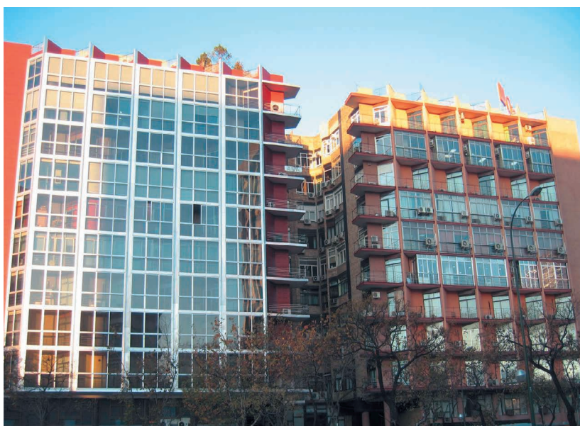
Foto 2.4. Acristalamiento de protección solar. Reducción de aportes energéticos sin reducción de visibilidad.
