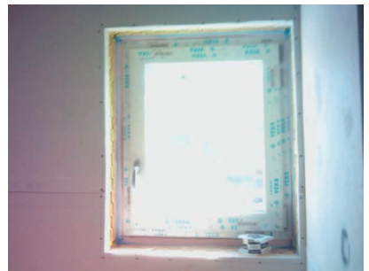
Fotos 11.3 y 11.4. Vivienda pasiva en ejecución en Rivas Vaciamadrid. Las exigencias de estanqueidad son máximas para este tipo de viviendas que no deben superar el valor n50 de 0,6 \text{ren}/\text{h} .
