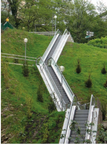
Foto 2.5. Escaleras en Larratxo (S. Sebastian). Fuente: ThyssenKrupp.
