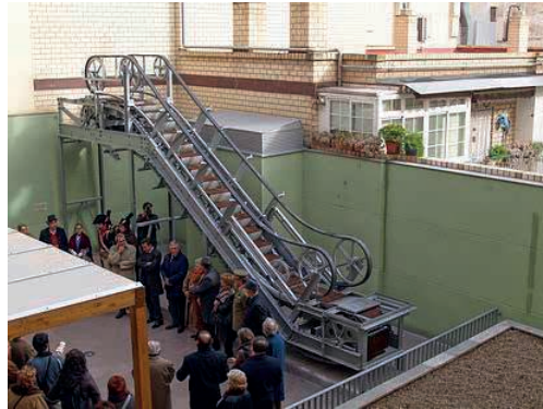
Foto 1.7. Primera escalera mecánica instalada en España.
