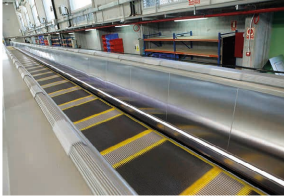
Foto 2.7. ACCEL en ThyssenKrupp Innovation Center de Gijón. Fuente: ThyssenKrupp.
