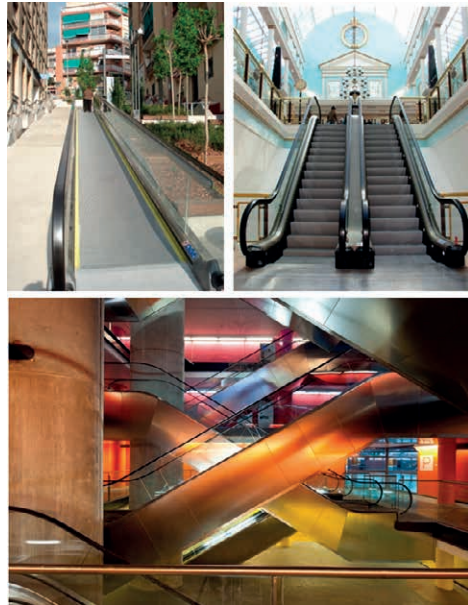
Foto 2.2. Disposición escaleras mecánicas. Disposición Simple arriba a la izquierda, Juntas y Paralelas arriba a la derecha, Cruzadas abajo.
