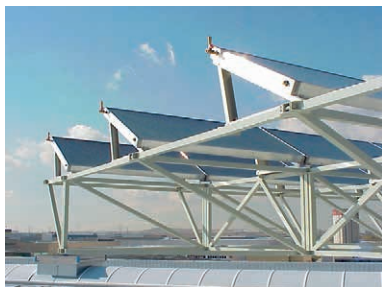
Foto 10.1. Posibilidades de montaje. Colectores planos.
