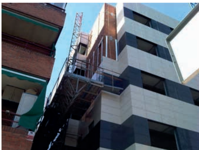
Foto 6.1. Instalación realizada (I).
