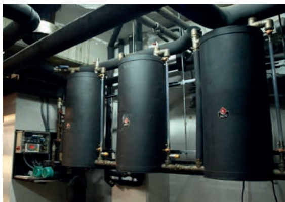
Figura 3. Kit Drain Back instalado (doble bomba y 3 vasos de drenaje de 85 litros).
