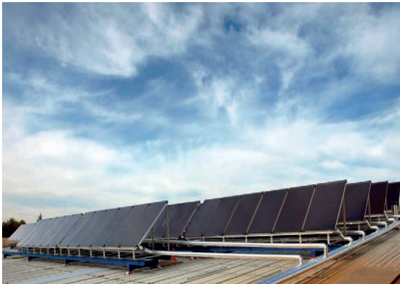
Figura 2. Instalación deportiva en Móstoles resuelta con sistemas Drain Back (340 m² de superficie de captación).
