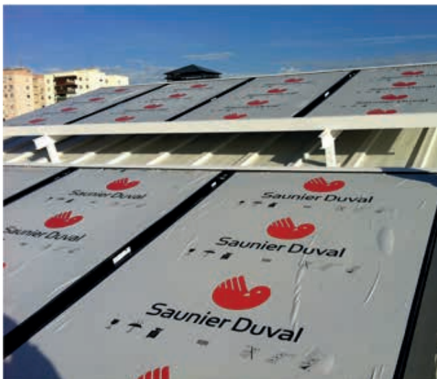
Foto 6.2. Instalación realizada (II).
