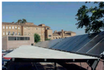
Foto 10.1. Posibilidades de montaje. Colectores planos.
