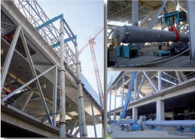
Infraestructura auxiliar construida para la elevación e instalación de los diferentes elementos del sistema de apertura de la cubierta de la Caja Mágica.
