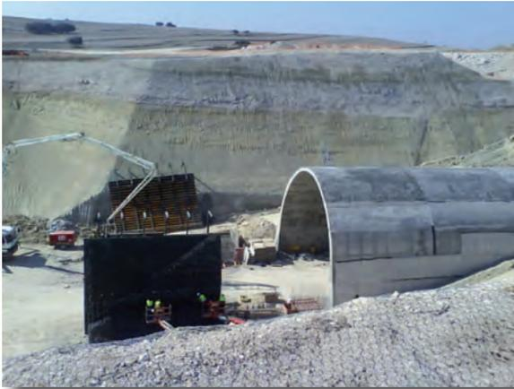
Taluzado de trinchera y malla metálica colocada para el control de pequeños desprendimientos del terreno. Construcción del túnel de naves Altas del acceso ferroviario línea de alta velocidad Madrid - Levante.
