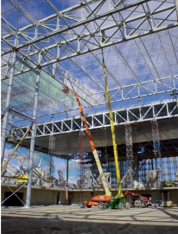
Utilización de P.E.M.P. de gran alcance para la ejecución de la estructura metálica. Obra de construcción de la Caja Mágica
