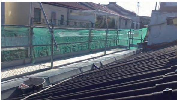
Instalación de un andamio tubular de fachada como medio de protección colectiva frente a riesgos de caída a distinto nivel durante la ejecución de la cubierta.
