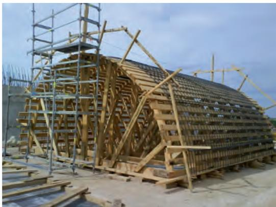
Encofrado para la construcción de la clave de un paso de fauna.
