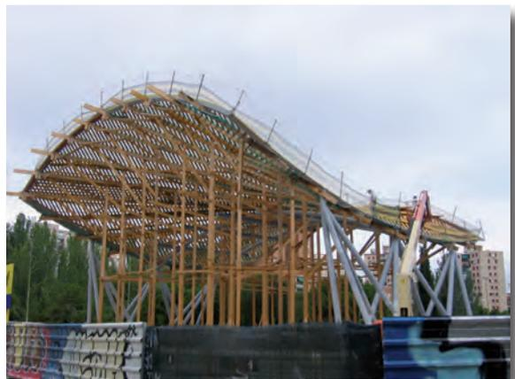
Estructura de apeo temporal para la ejecución de la cubierta de una estructura singular. Construcción de templete en el parque Arias Navarro de Madrid.
