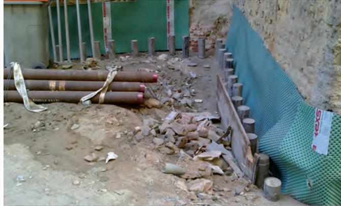
Pantalla de micropilotes para la resolución de una cimentación comprometida.
