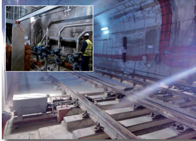
Trabajos de remodelación de una sala de bombas que requieren la ocupación parcial de vía en un fondo de saco
