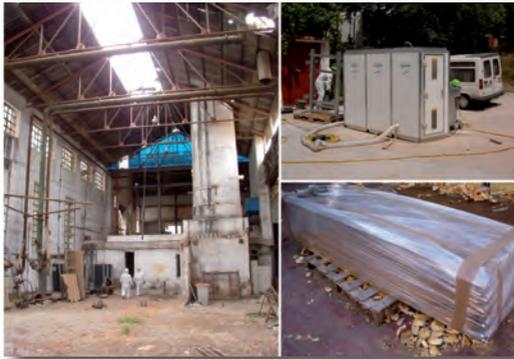
La presencia del amianto es uno de los condicionantes más importantes, ya que requiere la implantación de una infraestructura previa y la adopción de técnicas de trabajo muy concretas, así como la aprobación previa del correspondiente plan de trabajo.
