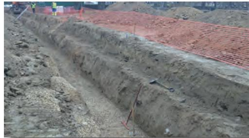
Construcción de bermas en zanjas para reducir el ángulo de talud.
