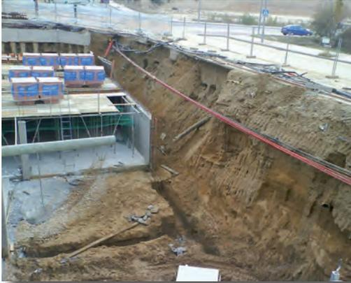
Hundimiento del terreno por una caracterización inadecuada que no solo afecta a la obra, como tal, sino a los servicios aledaños.
