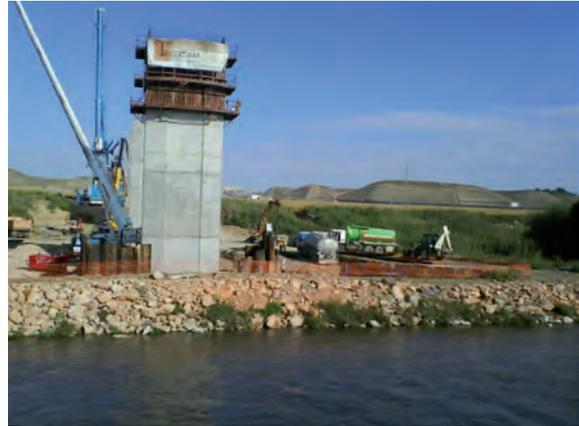
Construcción de una pila del viaducto sobre el río Tajo del acceso ferroviario línea de alta velocidad Madrid - Levante. La ubicación de la pila conllevó la creación de una plataforma sobre el cauce del río para la ejecución de la estructura.
