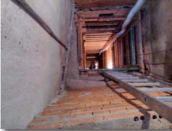
Puesta en obra de un sistema de entibación cuajada para la ejecución de un pozo.
