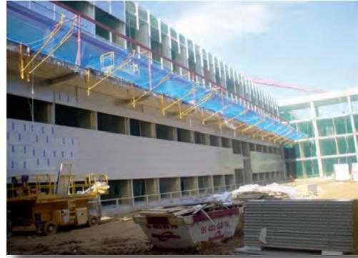
Colocación de un sistema de Redes de Seguridad tipo "T". Construcción del Hospital Universitario Puerta de Hierro.
