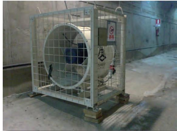
Ventilador auxiliar para impulsar el aire en las zonas centrales del túnel. Ampliación línea 9 de Metro de Madrid.
