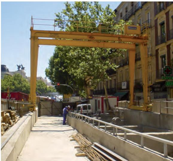
Puente grúa instalado para la construcción del pozo de una salida de emergencia. Conexión subterránea entre la estaciones de Atocha y Chamartín.
