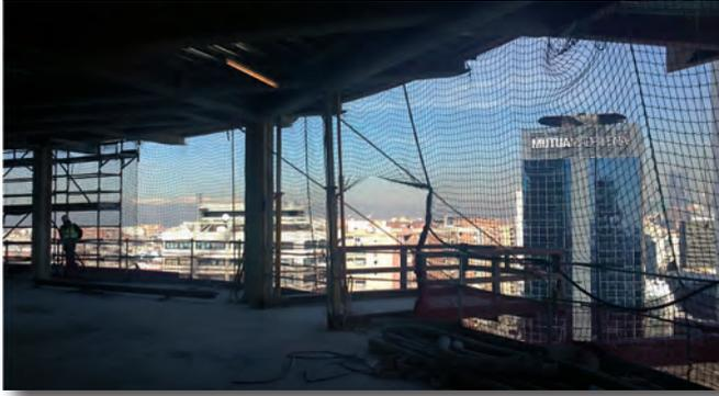
Colocación de un sistema de redes para el cierre perimetral de la obra.
