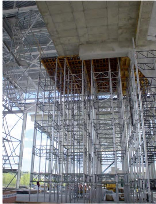
Sistema de cimbra para la ejecución de la estructura del graderío en fábrica de hormigón. Obra de construcción de la Caja Mágica.
