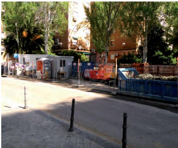
Implantación de servicios de higiene y bienestar para la ejecución de trabajos de construcción en el interior de una red de alcantarillado. En este tipo de actuaciones existe riesgo de exposición a agentes biológicos.
