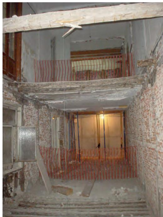
Conservación de parte de la estructura de madera en una obra de rehabilitación.
