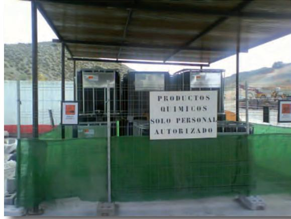
Zona habilitada para el acopio de productos químicos; en este caso resinas de impermeabilización. Construcción del túnel de El Regajal del acceso ferroviario línea de alta velocidad Madrid - Levante.
