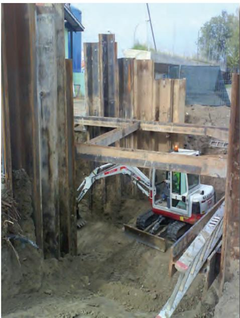
Ejemplo de un sistema de contención de tierras mediante tablestacas. Obra de remodelación calle 30.
