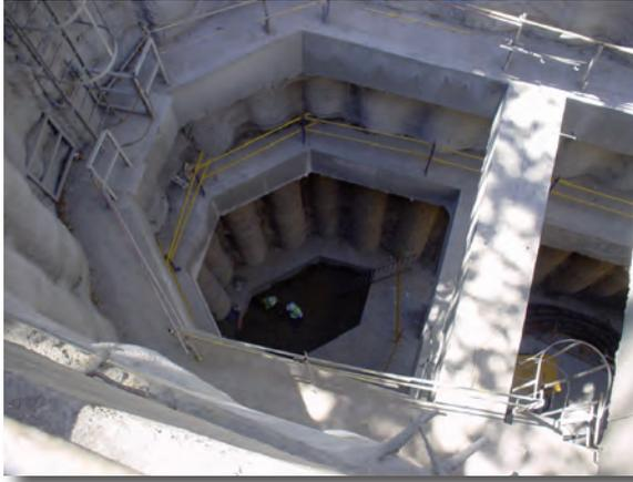
Vías de tránsito y medios de acceso al interior del pozo de una salida de emergencia. Conexión subterránea entre la estaciones de Atocha y Chamartín.
