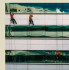
LIMPIEZA DE INSTALACIONES
