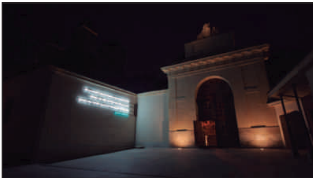
Casa de la Moneda, Segovia. Un rótulo de neón con una frase de Juan de Herrera es el iluminante general del espacio. Intervento.
