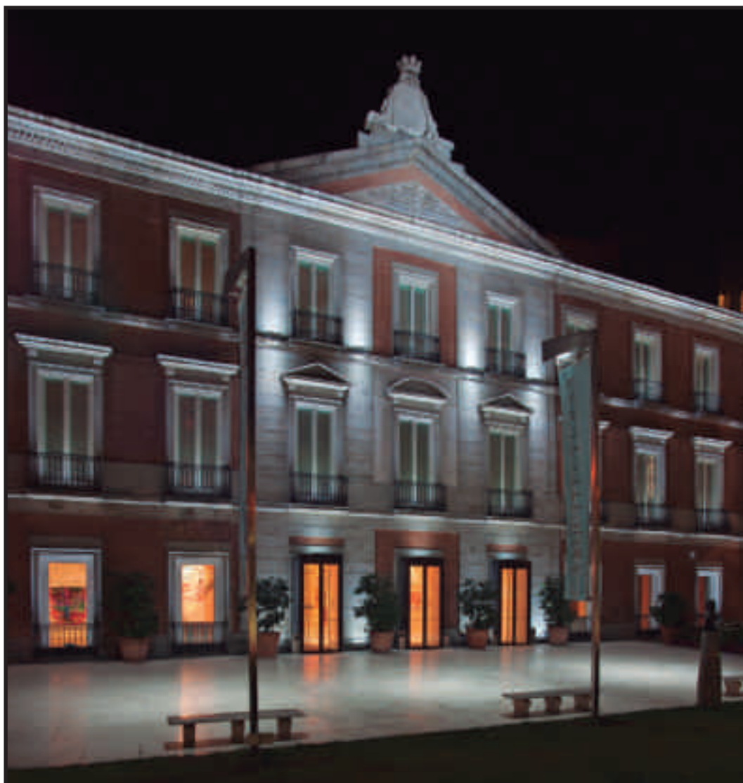
Iluminación fachada del Palacio Villa Hermosa, actual Museo Thyssen Bornemisza. Intervento.
