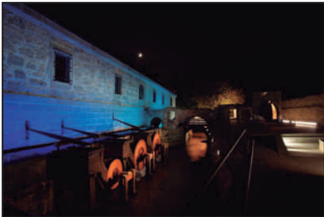
Ingenio de la Casa de la Moneda. La iluminación de la fachada procede del agua del canal. La escena se ilumina con la suma de detalles luminosos. Intervento.
