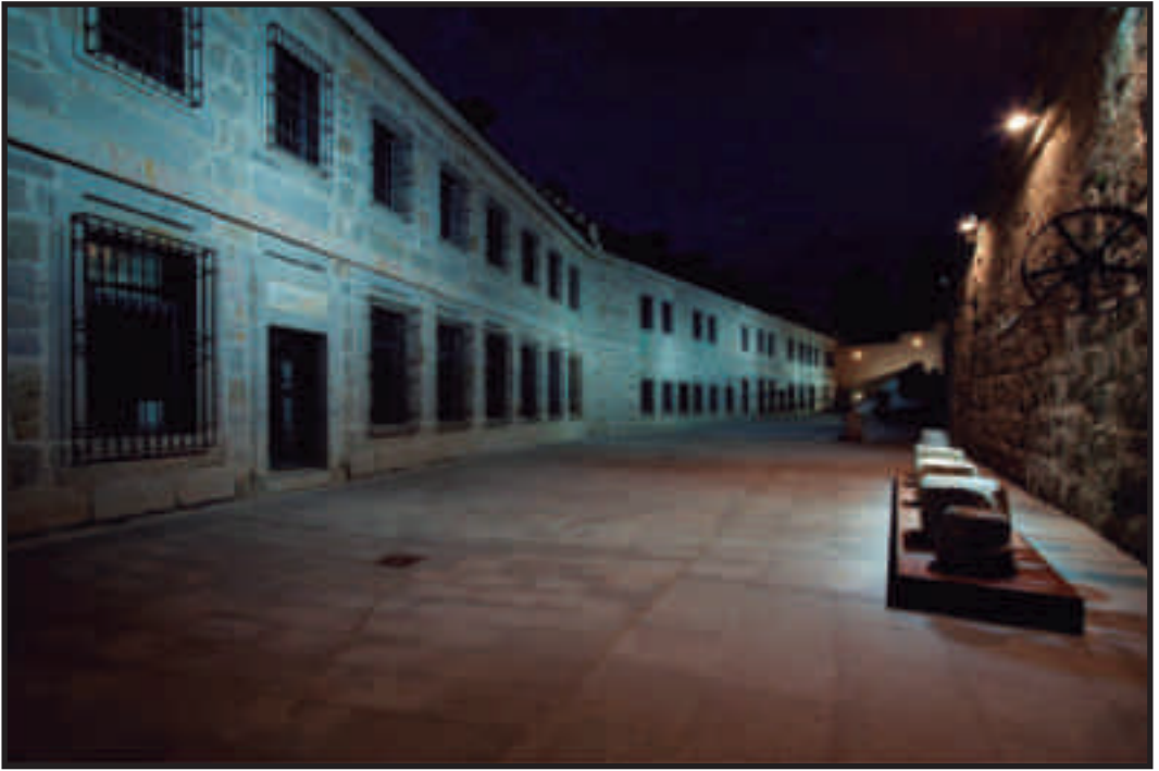
Iluminación patio inferior de la Casa de la Moneda. Intervento.
