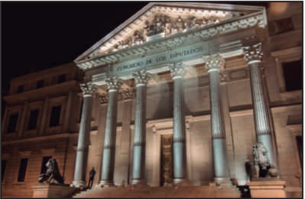
Imágenes finales de la iluminación del edificio.
