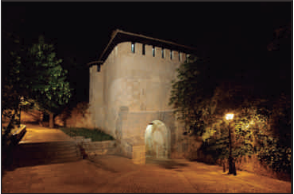
Iluminación de la Puerta de Santiago de Segovia. Intervento.
