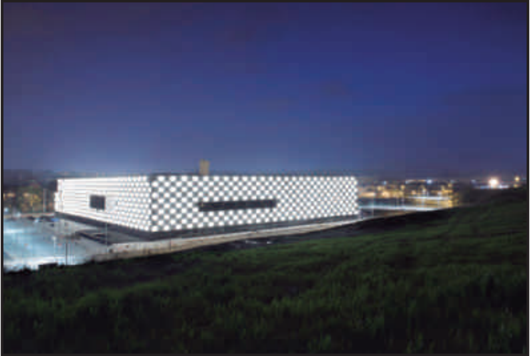
Imágenes finales de la iluminación del edificio.
