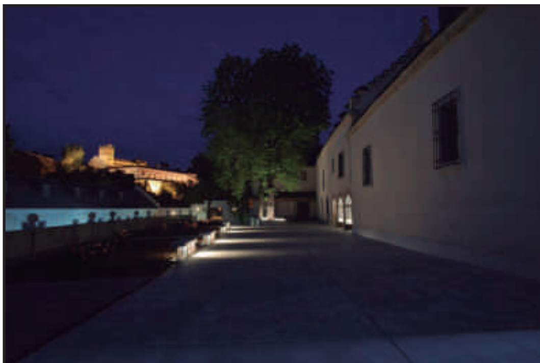
Contrasta la intervención discreta del primer plano en la Casa de la Moneda con la iluminación tradicional del monasterio del Parral al fondo. Intervento.
