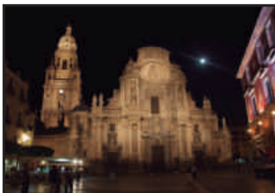
Imagen de la iluminación de la Plaza del Cardenal Belluga de Murcia y de su Catedral y Torre, después de la renovación de la iluminación realizada el año 2014. Intervento.
