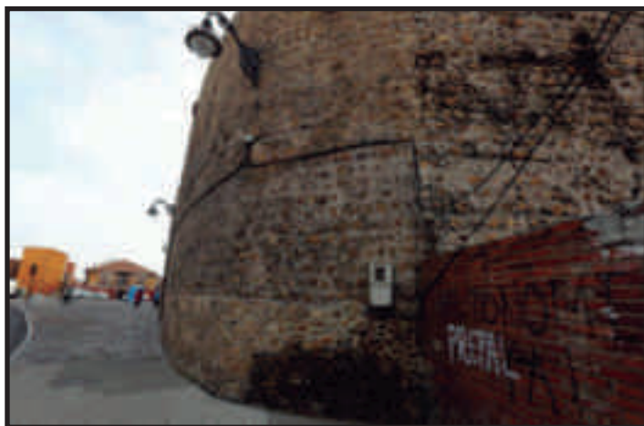
Instalación de cableado e iluminación existente en los lienzos de la Muralla Romana de León. Fuente: Diario de León.
