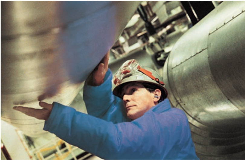
Figura 2.5. Inspección y Mantenimiento en Instalación Industrial Aislada.
