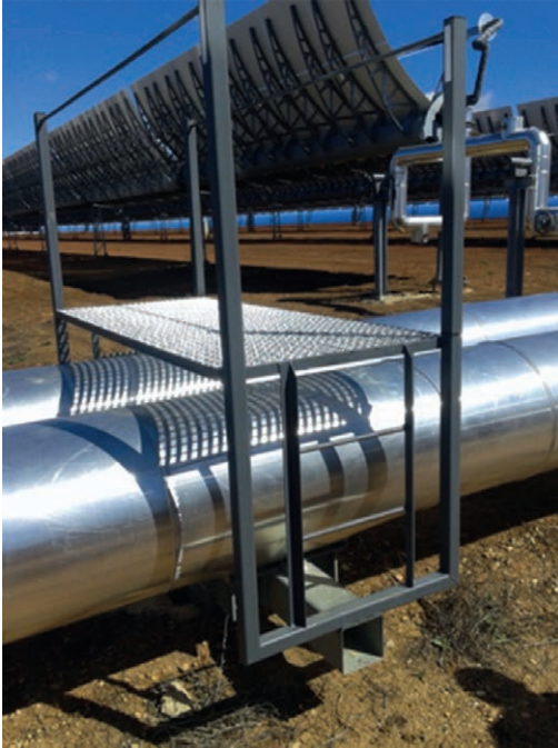
Figura 4.11.12. Ejemplo de plataforma de paso.
