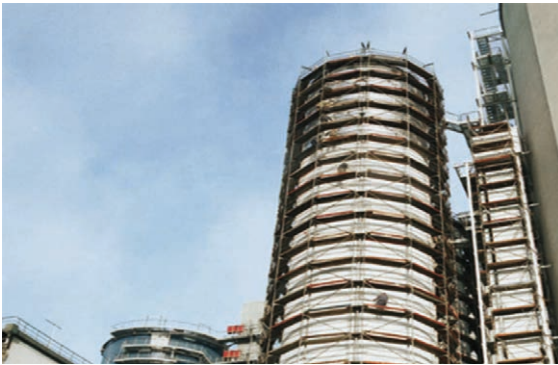
Figura 5.4. Depósito de amonio.
