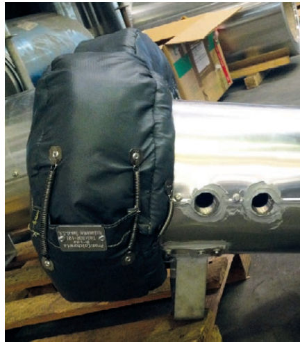
Figura 4.8.1. Ejemplo instalación de colchoneta en brida ciega.
