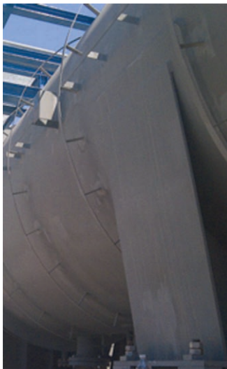
Figura 4.4.1.B. Ejemplo de distanciador en equipo.
