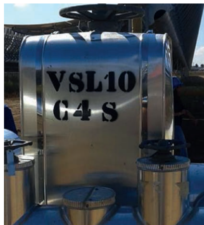
Figura 4.3.2.E. Ejemplo de cajeadado metálico desmontable.
