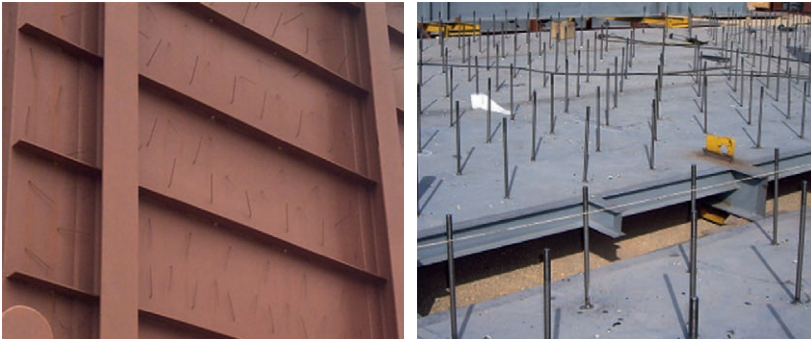
Figura 4.4.1.A. Ejemplo de colocación de pinchos y pernos.
