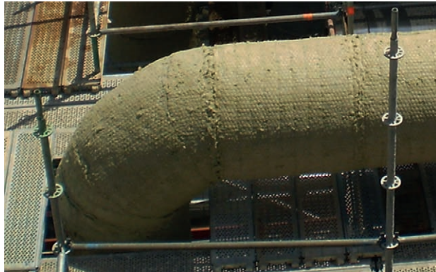
Figura 4.3.2.D. Ejemplo de cosido de manta armada.
