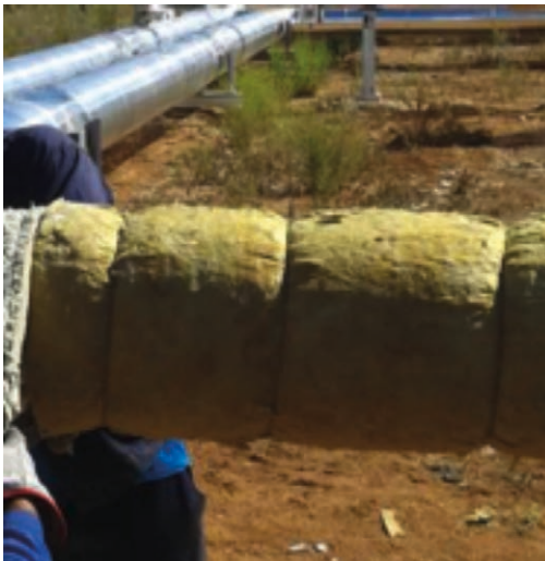
Figura 4.3.2.C. Ejemplo de atado de coquilla con alambre.
