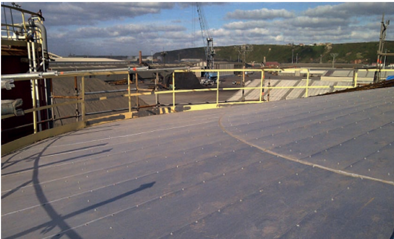
Figura 4.11.9. Ejemplo de aislamiento de techo.
