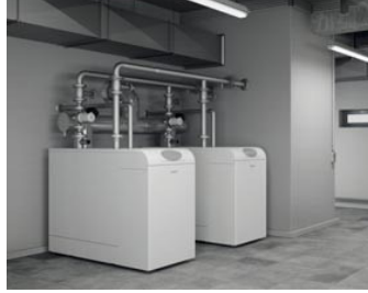
Ejemplo de instalación con calderas de pie
