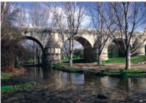
Puente del Retamar , entre Las Rozas y Galapagar (Madrid). Cuenta con siete arcos de medio punto y seis pares de tajamares (elemento constructivo añadido a la pila de los puentes).
