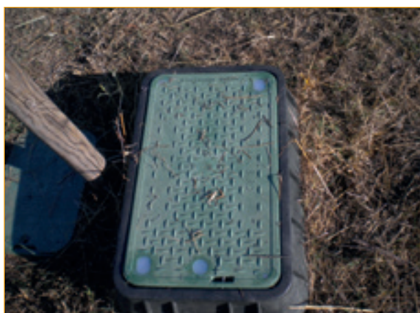
Figuras 22 y 23. Reparación de las tapas de arquetas en la red de riego en Bosque Sur.
