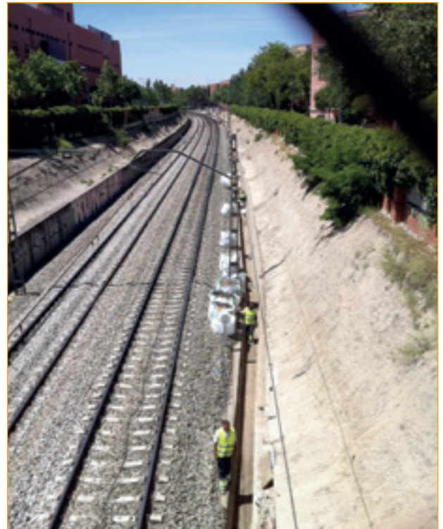
Figura 11. Actuaciones medioambientales. Limpieza en vías del tren de cercanías en Leganés. Línea C-5.
