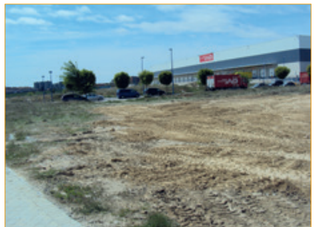
Figuras 18 y 19. Retirada de escombrera junto a Bosque Sur (antes y después).
