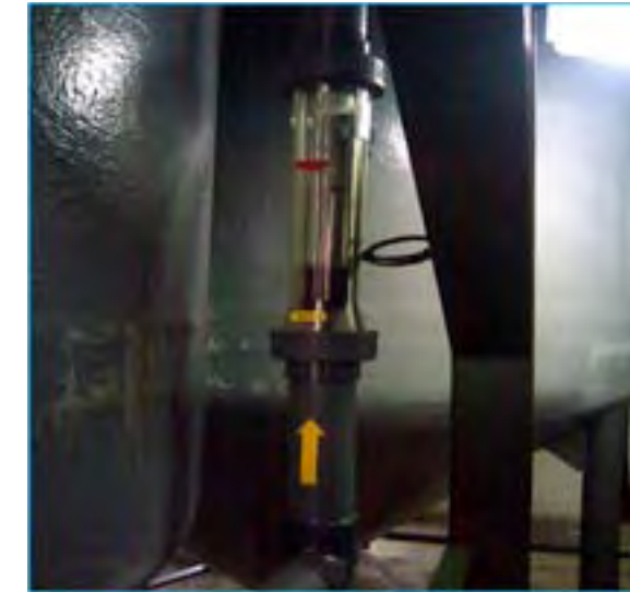
Figura 33. Rotámetro en operación durante las pruebas de preparación de reactivo
