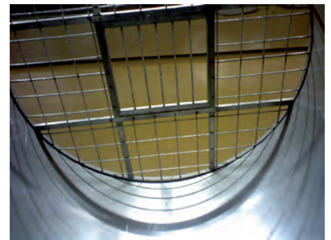
Protección de la boca de los depósitos con trampilla central para facilitar los trabajos. Bodega Valquejigoso (Villamanta).
