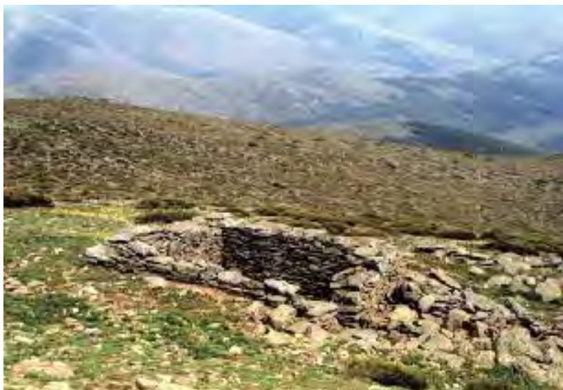
Fig. 7.- Construcción de piedra seca parcialmente excavada en el terreno (Foto: Javier Pastor).
