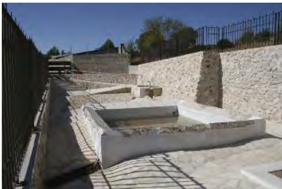
Fig. 6.- Fuente del Cañuelo tras la intervención.
