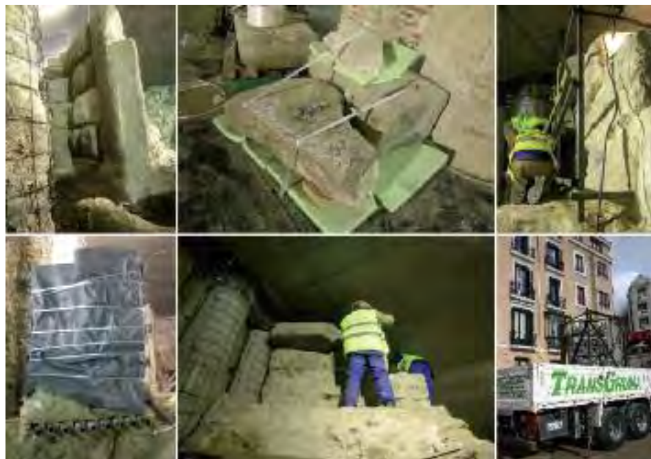
Fig. 4. Fuente de los Caños del Peral. Traslado y protección de las piezas.
