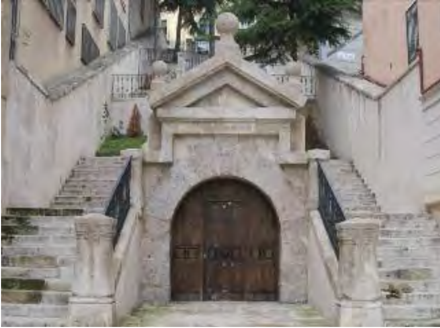
Fig. 1.- Entrada monumental del refugio que discurre bajo el Hospital de Santiago. Foto: Michel Muñoz.
