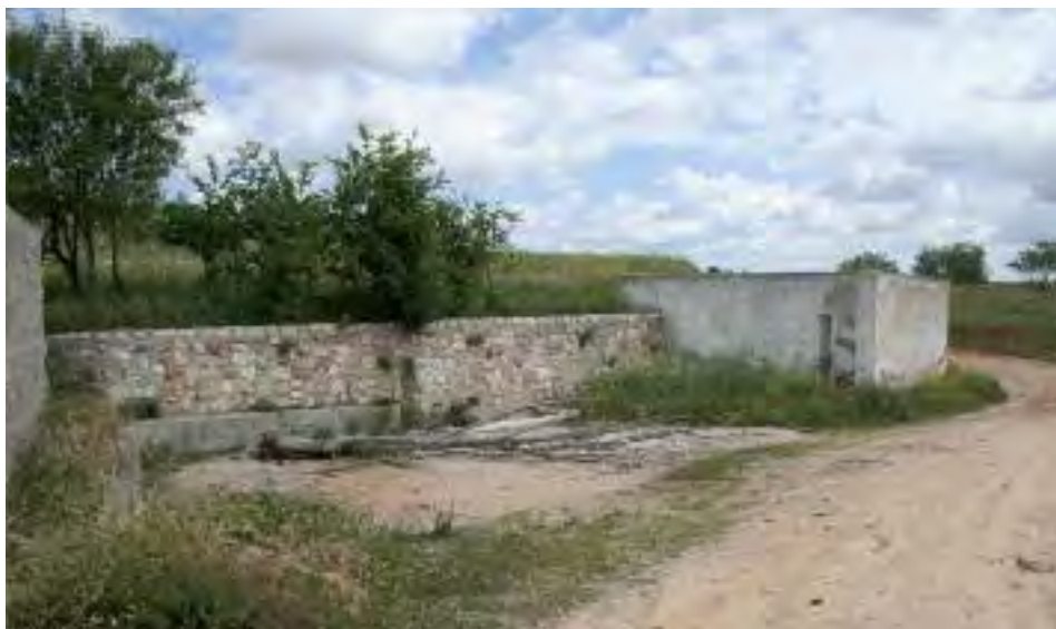
Fig. 1.- Fuente del Cañuelo antes de la intervención.
