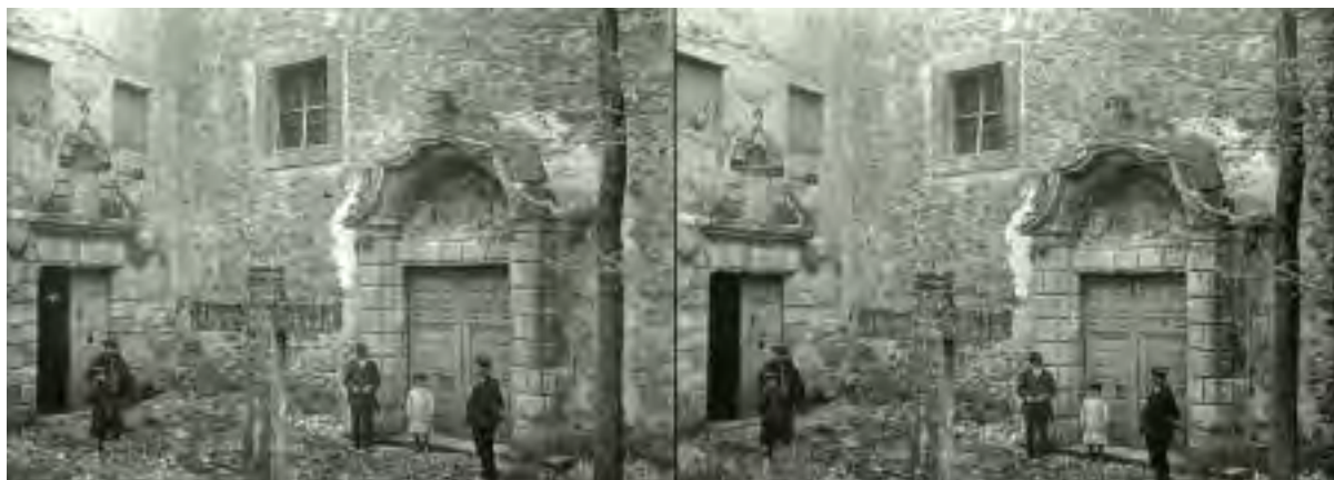
Fig. 2.- Fotografía estereoscópica de 1912 con la puerta del convento a la derecha y la portada de la iglesia a la izquierda. En primer plano la cruz de los descalzos
