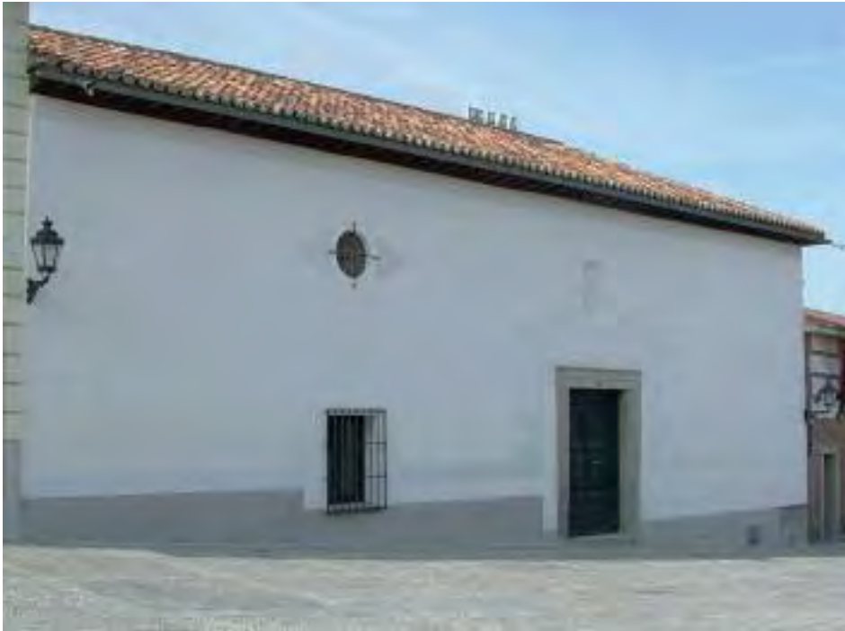
Fig. 2.- Alzado de la ermita después de la restauración. Estado posterior a la restauración.
