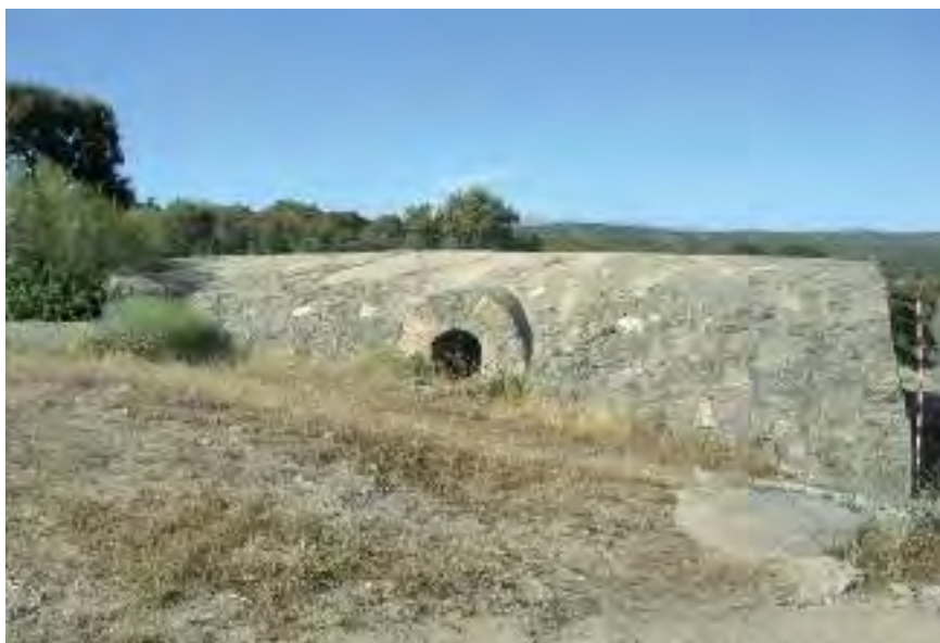
Fig. 2.- Construcción tipo blockhaus. Posición Calvario. Febrero de 1939.
