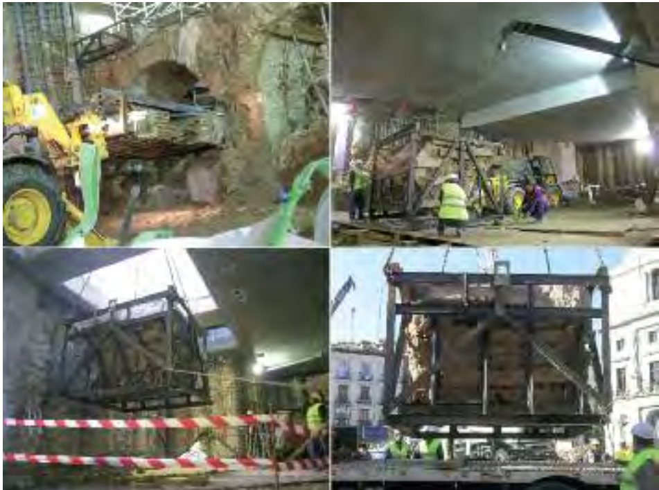
Fig. 3. Acueducto de Amaniell. Elevación y traslado de las piezas.
