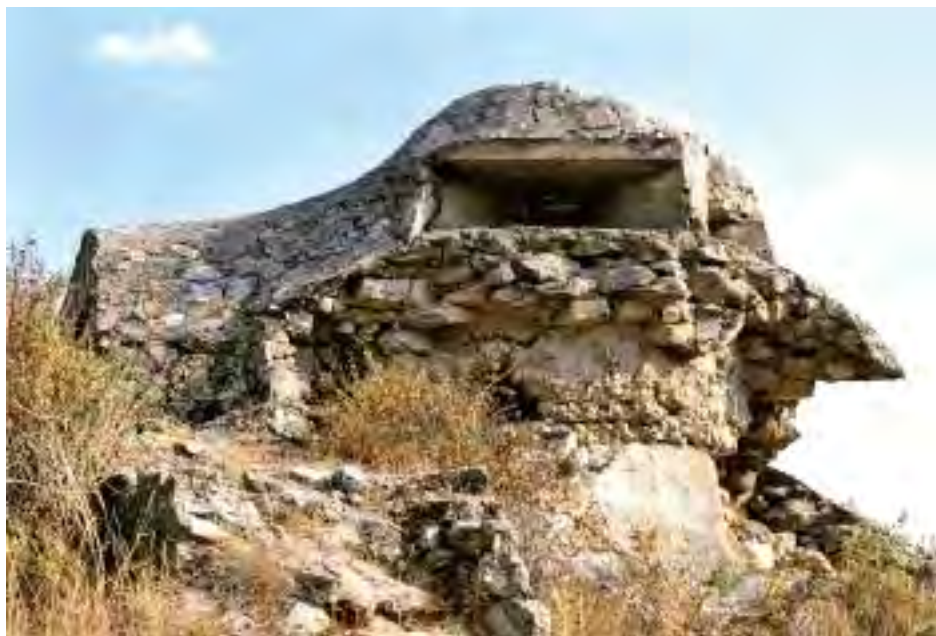
Fig. 15.- Nido de ametralladora de piedra y cemento en Fresnedillas de la Oliva. Fotografía de autor.
