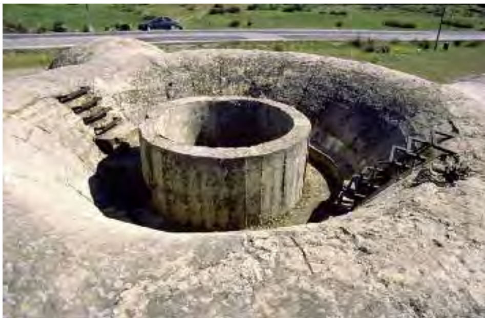
Fig. 3.- Detalle del muro de protección para combatientes en cubierta del Blockhaus 13 (nacional), Colmenar de Arroyo. Marzo 1939.
