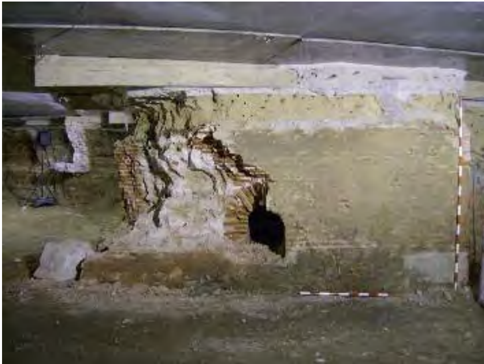
Fig. 3. Cimentación de la estatua de Isabel II.
