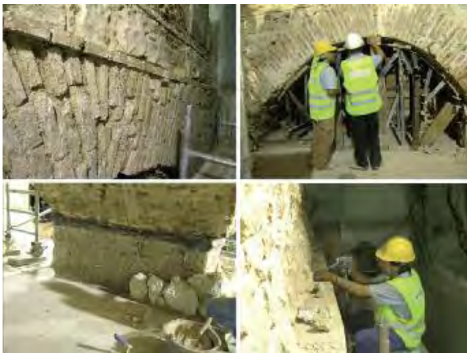
Fig. 6. Acueducto del viaje de agua de Amanuel. Restauración y montaje.
