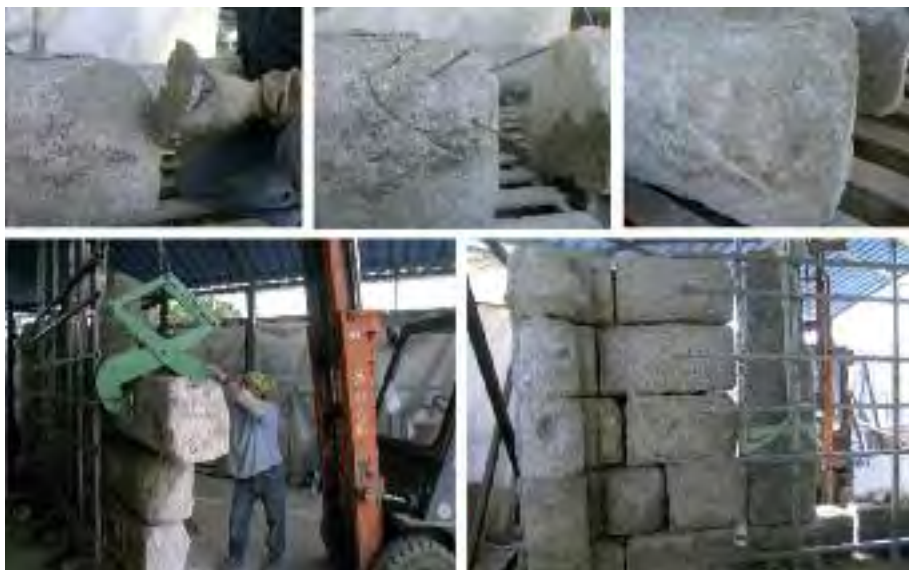
Fig. 5. Fuente de los Caños del Peral. Restauración y premontaje en almacén.
