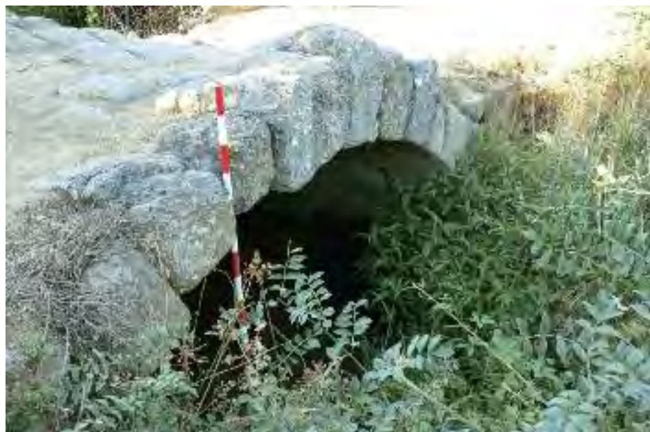
Fig. 4.- Posible puente romano.
