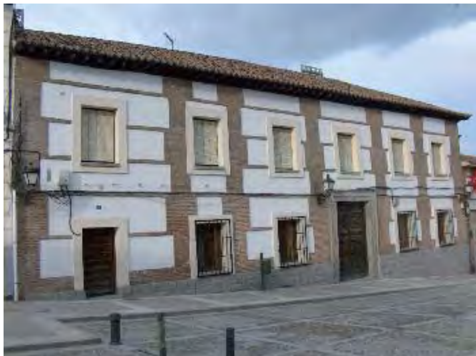
Fig. 1.- Alzado de la ermita antes de la restauración. Estado previo a la restauración.
