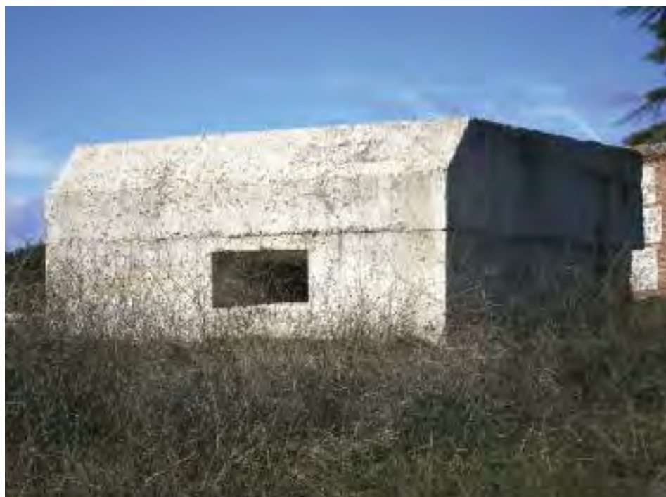
Fig. 5.- Vista del bunker tras la intervención.
