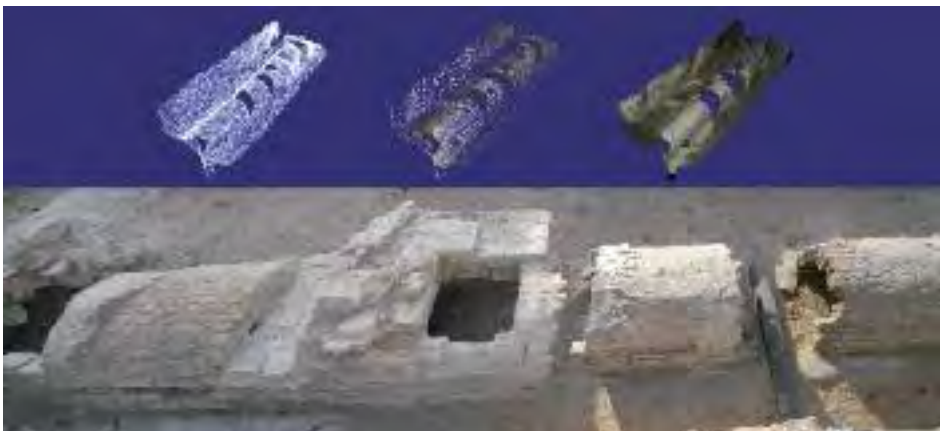
Fig. 4.- Fotografía y fotogrametría de una galería de evacuación de aguas.
