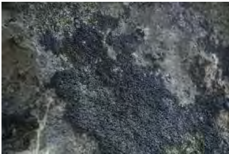
Fig. 5.- Patologías. Pátinas biogénicas – biodeterioro.
