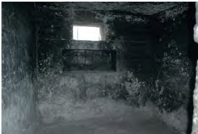
Fig. 4.- Vista del interior del bunker.
