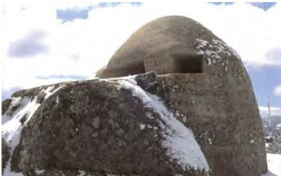
Fig. 11.- Observatorio de hormigón en el cerro de la Sevillana. Fotografía del autor.
