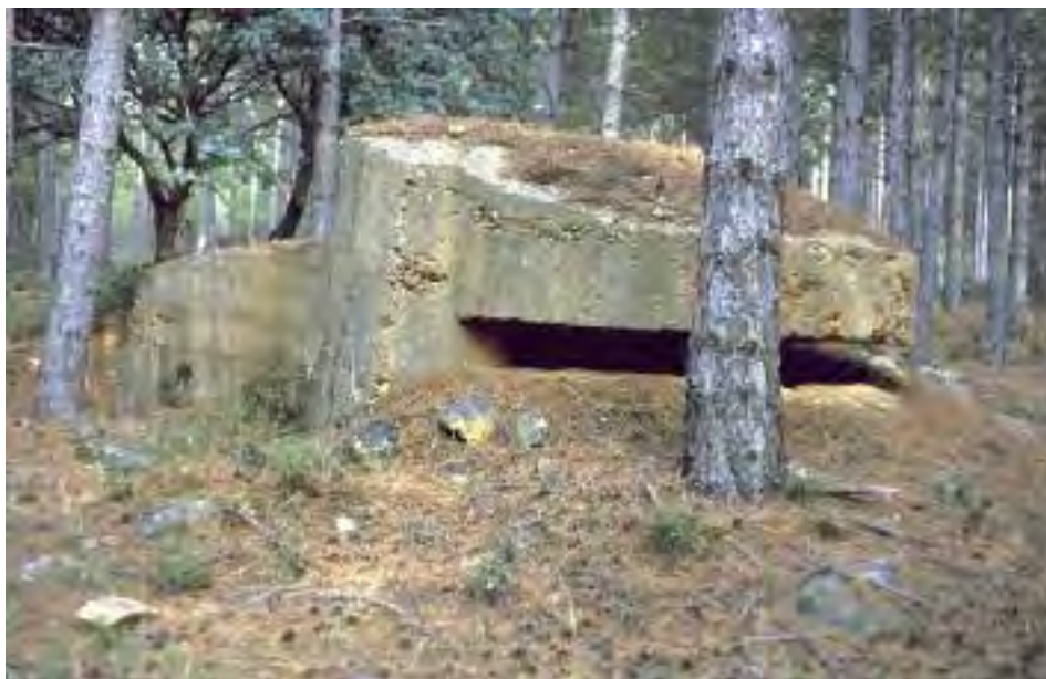
Fig. 10.- Nido de ametralladoras situado en el pinar que se extiende al oeste de Paredes de Buitrago. Fotografía del autor.
