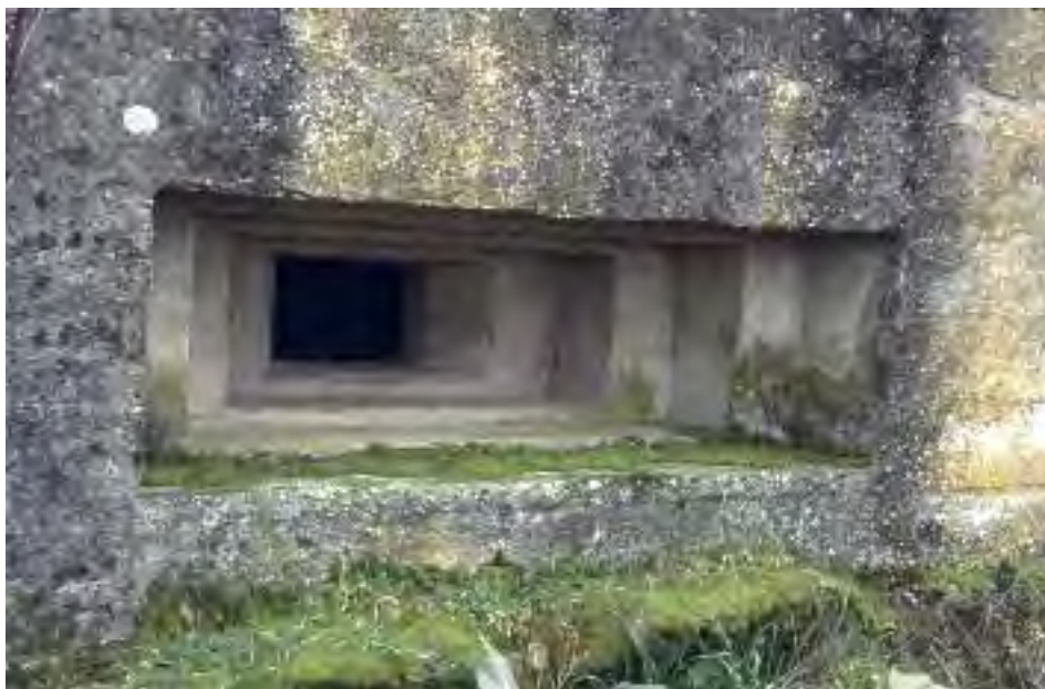
Fig. 3.- Detalle de la aspillera escalonada de uno de los fortines situados en la vega del río Jarama (Ciempozuelos). Fotografía del autor.
