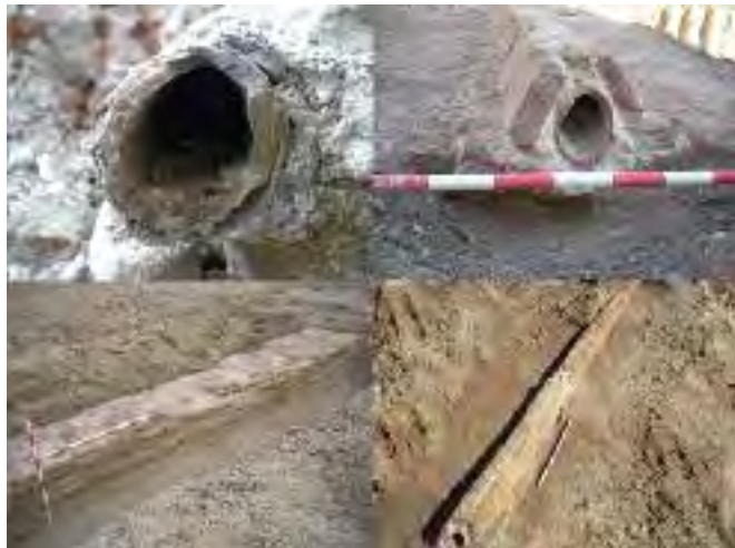
Fig. 1.- Conducciones hidráulicas: tubería de plomo colmatada por sales y tubería de barro cocido vidriado al interior.
