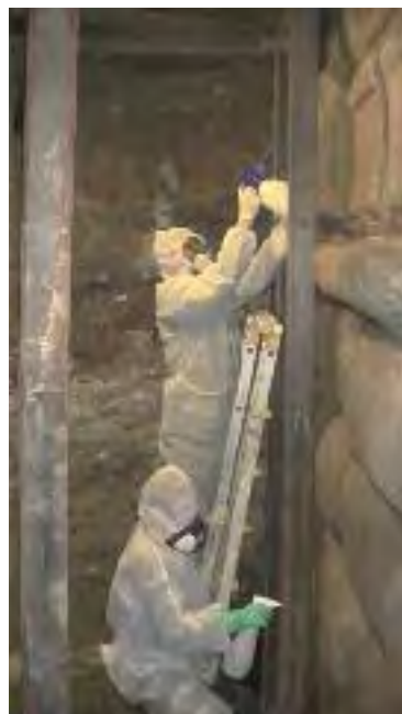
Fig. 3.- Aplicación de biocida.
