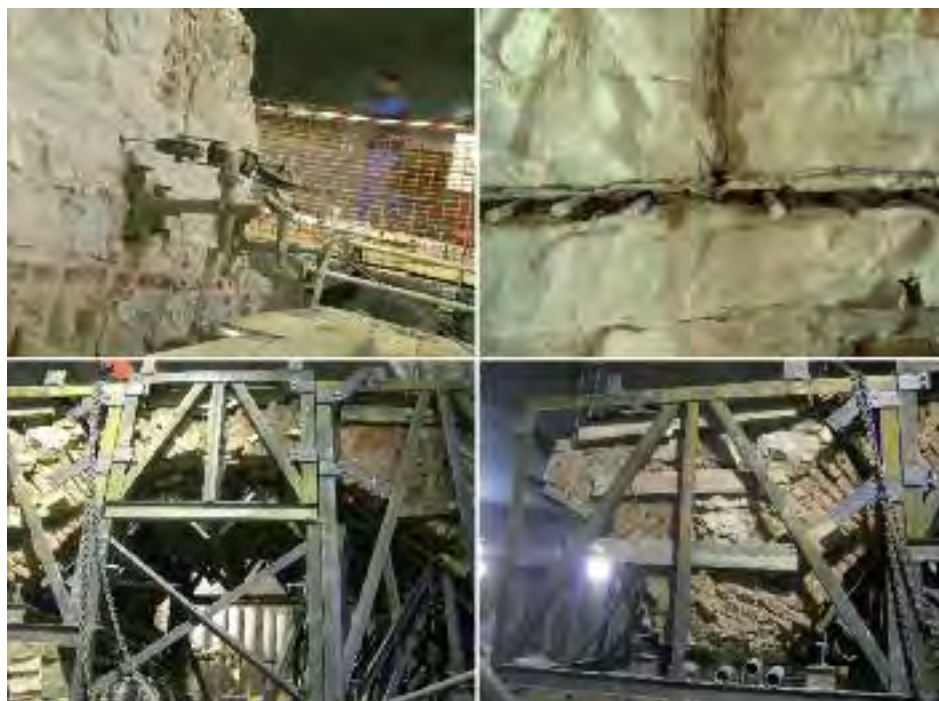
Fig. 2. Acueducto de Amanuel. Corte con hilo de diamante y estructuras portantes.
