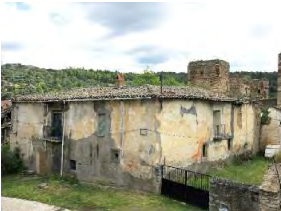
Fig. 1.- Vista general del edificio y del patio con las paredes objeto del estudio.
