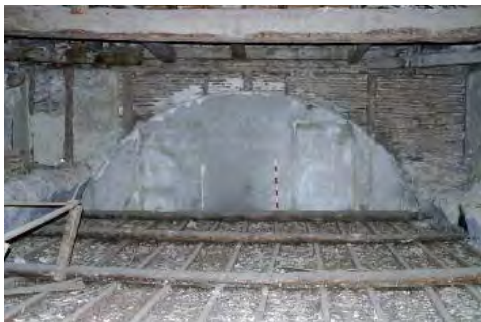
Fig. 6.- Cuerpo de fábrica 16 en el espacio bajo cubierto, donde se aprecia la sección que tenía la antigua bóveda en yeso que cubría la iglesia de los Franciscanos Descalzos.
