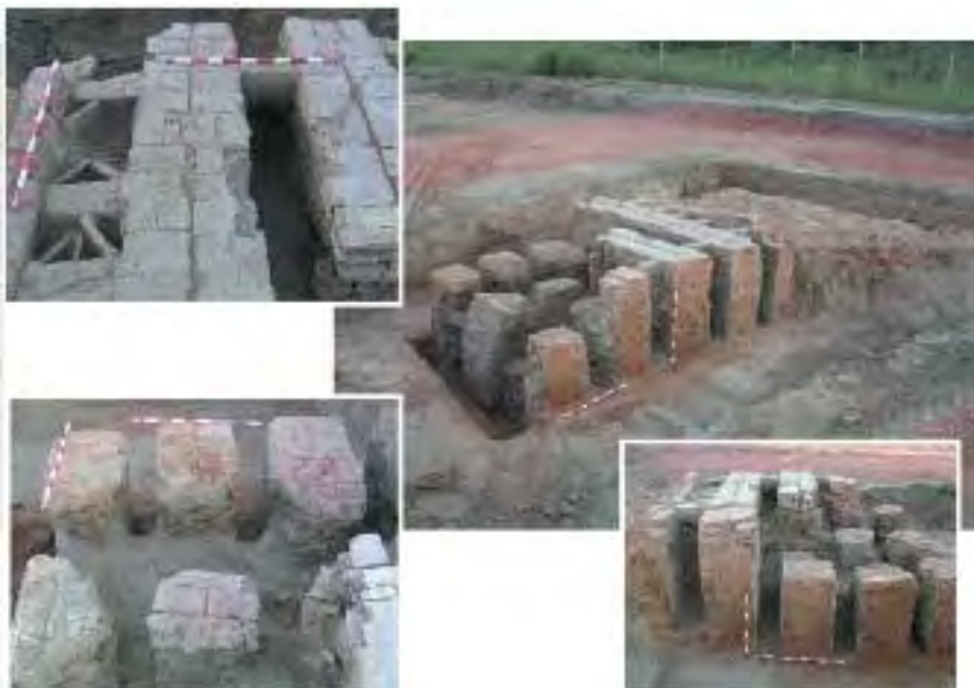
Fig. 1.- Vista de la intervención.
