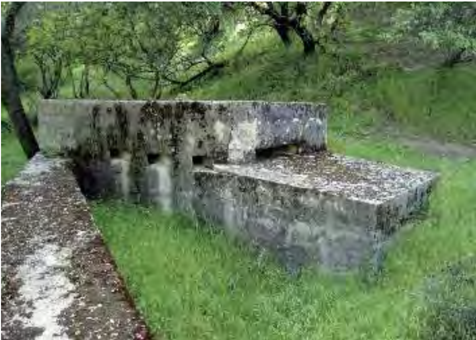
Fig. 1.- Primera construcción de hormigón nacional documentada en el teatro de operaciones del centro. Elemento de Resistencia del río Perales, posición Loma de San Pablo, Quijorna. Agosto 1937.
