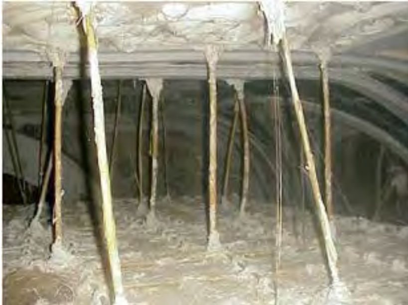
Fig. 3.- Detalle de la bóveda encamonada. Bóveda encamonada descubierta bajo el falso techo.
