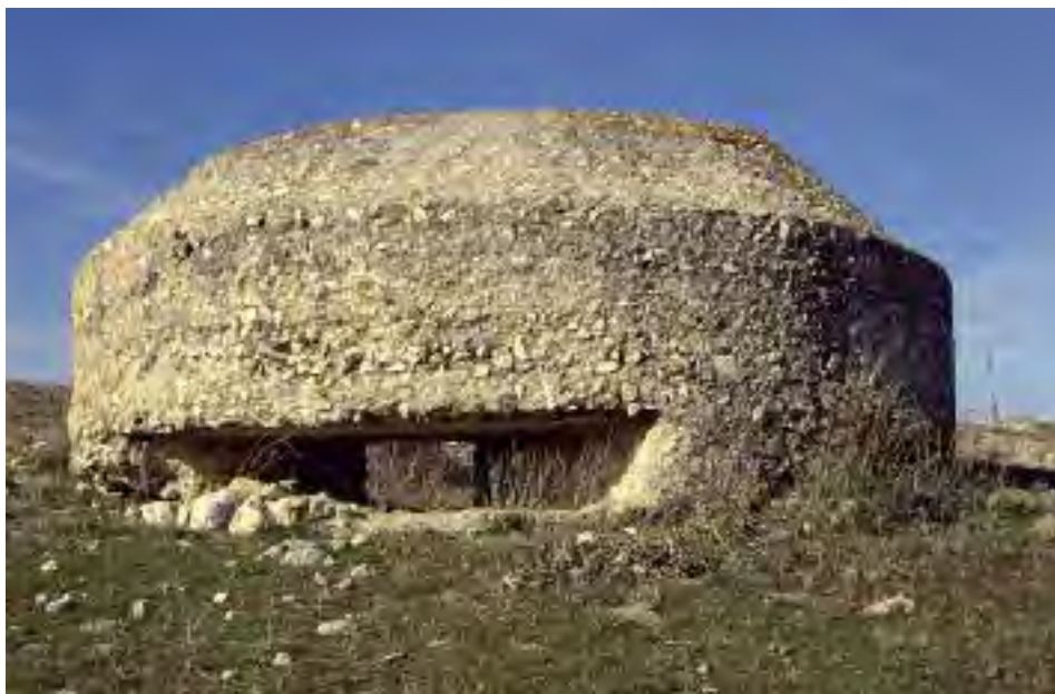
Fig. 7.- Uno de los al menos 16 ejemplares de nido de revolución para arma automática (Plan 69-B) levantados por la República en las alturas que dominan la llanada donde se desarrolló la batalla de Brunete. Cubren la extensión entre el cerro de El Castillejo y el río Guadarrama, de Valdemorillo a Villanueva del Pardillo. 1938.
