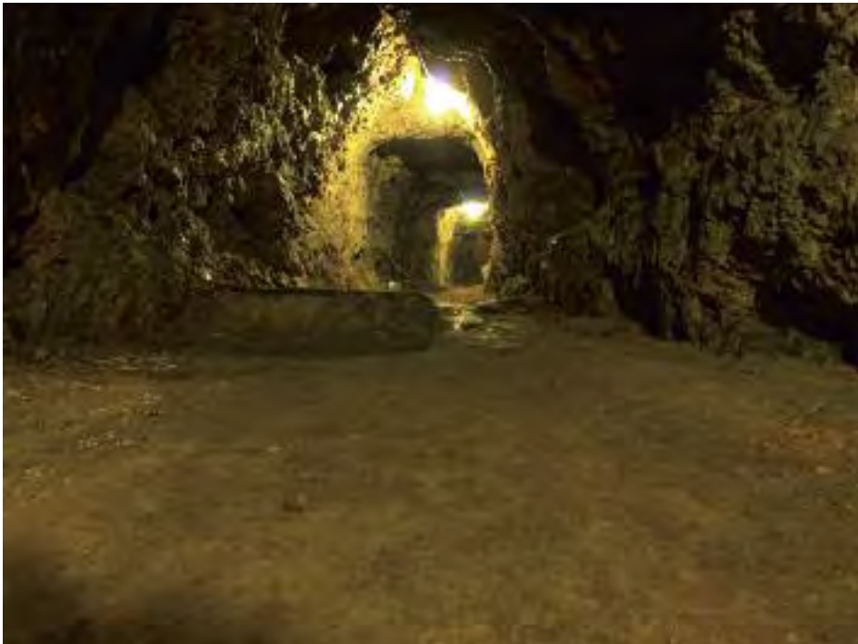
Fig. 8.- Galería sin revestir en el Refugio de la Calle Alfonso VIII. Foto: Santiago David Domínguez-Solera.
