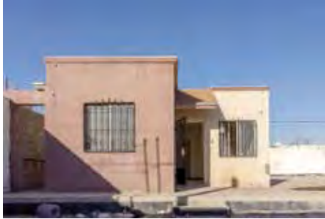
Fachada principal con pasillo de servicio lateral izquierdo.
