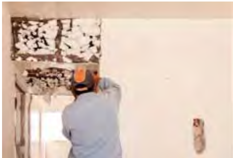
Fachada principal en proceso de desmantelamiento de ventanas.
