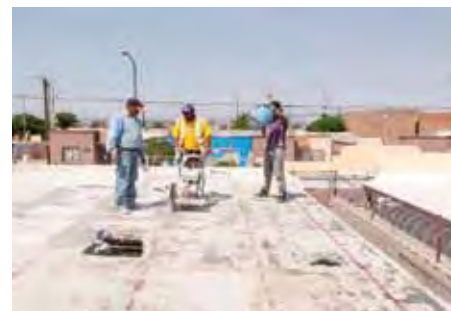
Vista de trabajos en azotea. Se remarcan las calles y casetones. View of works on the flat roof. Squares are cut out on the roof.
