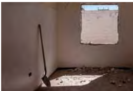
Vista interior de desmantelamiento de la ventana de la cocina, al fondo se observa bardeado perimetral en block .
