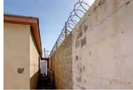
Pasillo lateral de servicio con muro de block y protección de púas.
