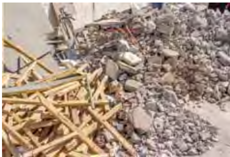
Vista interior del desmantelamiento de la ventana de la cocina, al fondo se observa bordeado perimetral en block .
