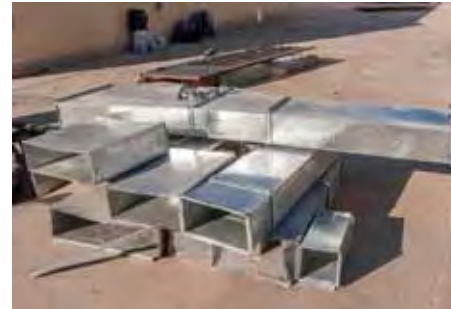
Acumulado de material de retiro de conductos.
