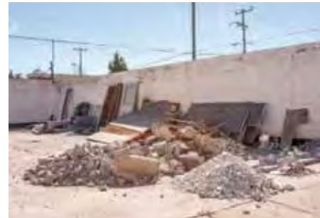
Acumulación de material de desmantelamiento y recuperación. Accumulation of dismantled material, some of which will be re-used.
