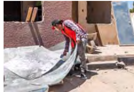
Clasificación de material de recuperación acumulado en la fachada principal.
