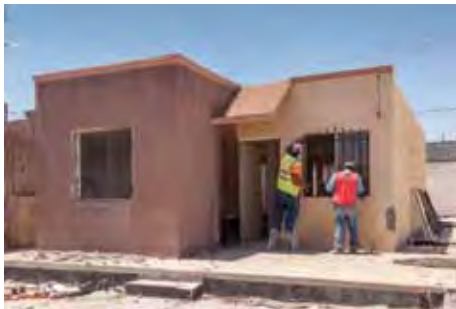
Fachada principal en proceso de desmantelamiento de las ventanas.
