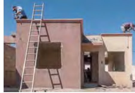
Trabajadores demoliendo cornisas en la fachada principal.
