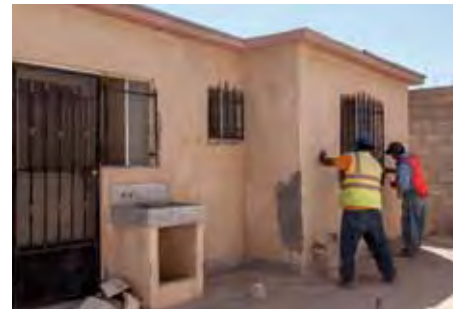
Fachada posterior en proceso de desmantelamiento de las ventanas.
