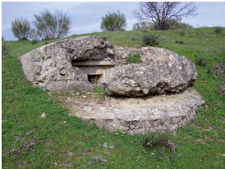
Fig. 3.- El techo partido de esta obra del arroyo de la Puentecilla permite apreciar el negativo de los raíles de ferrocarril.
