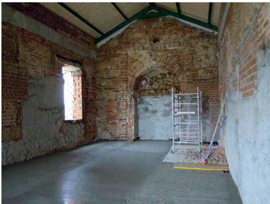
Fig. 4.- Vista de la portada mudejar tras la retirada de los enfoscados.
