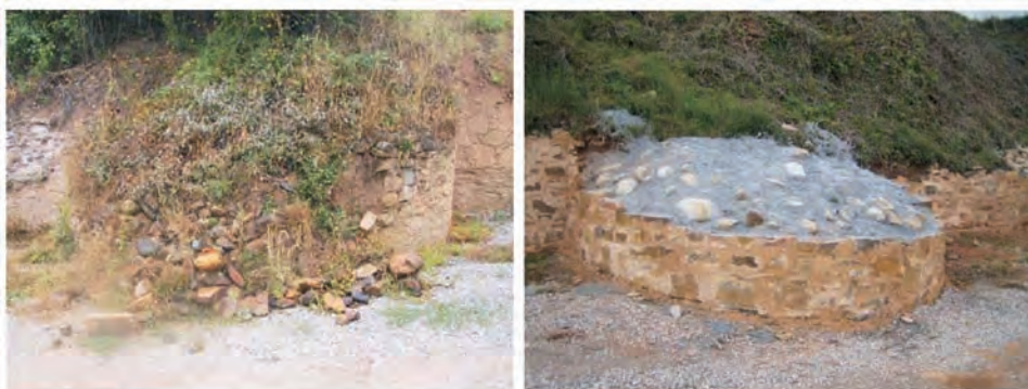
Fig. 4.- En el yacimiento de Bergidum Flavium, un intento de anastilosis sin la participación de equipos interdisciplinarios desemboca en la ejecución de una partida en teoría correcta que pedía la ejecución de fábrica de mampuesto recibido con mortero de cal. Es necesaria la interpretación arqueológica y la ejecución de la obra por restauradores y personal cualificado. El resultado es el cambio total del paramento original, anulando la construcción romana.
