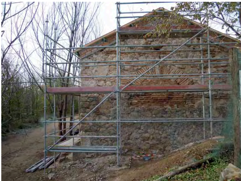
Fig. 2.- Localización del sondeo y vista exterior del muro Este tras la retirada del enfoscado de cemento.
