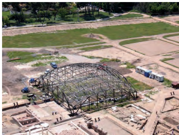
Fig. 4.- Estructura metálica de la cubierta de la Casa de los Grifos. Proceso de ejecución.
