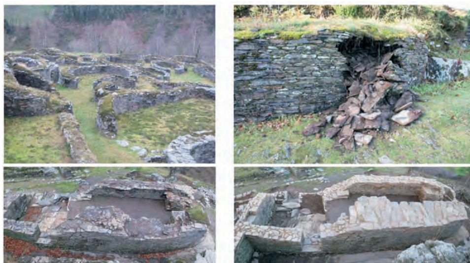
Fig. 1.- En algunos yacimientos prerromanos y romanos del norte peninsular se mantiene la creencia de que la cobertura vegetal en la coronación de los muros es ideal desde un punto de vista de la conservación del yacimiento. En este tipo de actuaciones se llega incluso a “plantar” el musgo en las cabeceras, obteniendo un resultado quizás agradable a la mirada romántica del visitante nostálgico. La intervención ruskiniana está basada en el desconocimiento al suponer que los biofitos no sacan los nutrientes de la tierra y si no la hay, arenizan y meteorizan al piedra húmeda, clavando y extendiendo sus raíces en el muro que sujetan. En este caso del castro de Coaña, las recientes intervenciones han erradicado esta práctica, coronando los muros con morteros hidrofugados.
