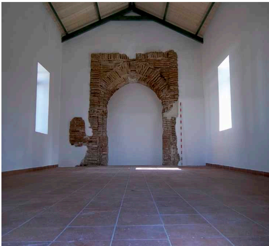
Fig. 6.- Estado final del interior de la ermita tras su rehabilitación.
