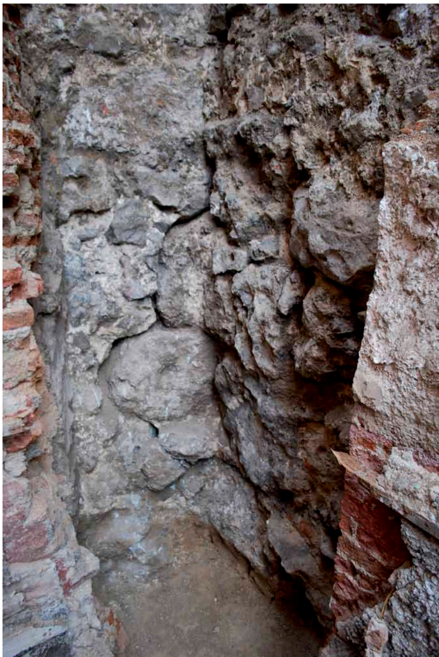
Fig. 6.- Detalle de la cimentación de la torre y muralla en Puerta Cerrada 4.
