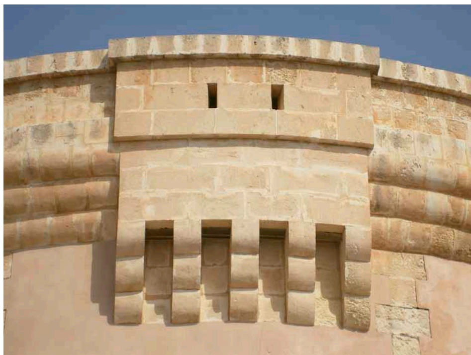
Fig. 6.- Vista del matacán de la torre, después de la restauración.
