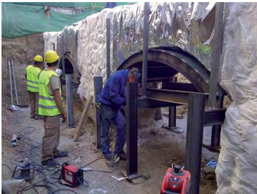
Fig. 3.- Colocación de los camones.
