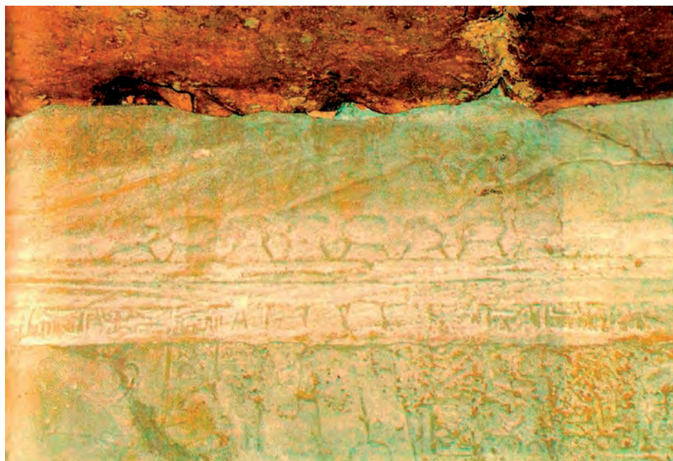
Fig. 1.- Capilla de Adjilamani. Eflorescencias salinas sobre los relieves.
