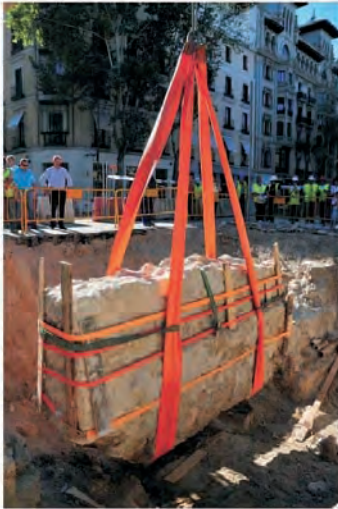
Fig. 10.- En la cerca de Felipe IV (siglo XVII) de la calle Serrano de Madrid, la decisión del traslado de un tramo obligó a la consolidación y reintegración del muro para garantizar su estabilidad posterior en la extracción en bloque.
