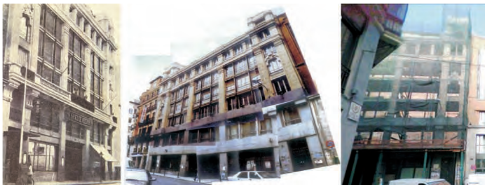
Fig. 1.- Comparación de los diferentes estados de proyecto en la Fachada del Edificio de la Calle Cedaceros 6 de Madrid. De izquierda a derecha: Estado original, reforma de 1987 y estado actual.
