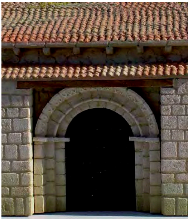
Fig. 7.- Reconstrucción a escala del pórtico con los elementos hoy desaparecidos (impostas, contrafuertes y tejadillo).
