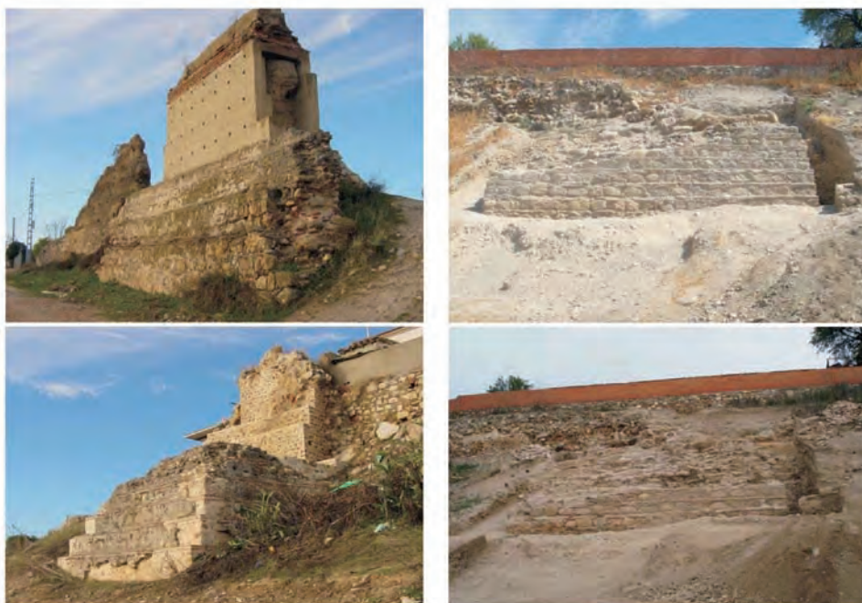
Fig. 5.- En la muralla de Talamanca del Jarama, la falta de criterios provoca el recalce interior de una torre presentando fachada, utilizando el mismo material, sin separadores, confundiendo al visitante, al igual que el enzunchado de hormigón del tramo de tapial, provocado por el desconocimiento de las técnicas de restauración de este material y la falta de información de técnicos especializados. A la derecha, intervención correcta, que respeta el original y utiliza separadores, en una torre tras su excavación.
