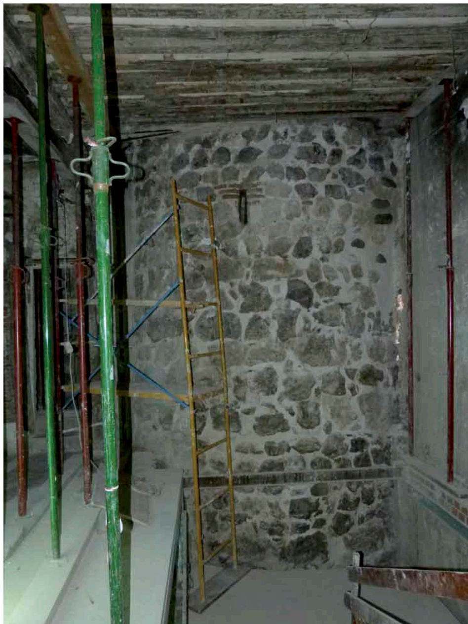
Fig. 4.- Vista del torreón durante los trabajos de limpieza y consolidación en Cava Baja 4.
