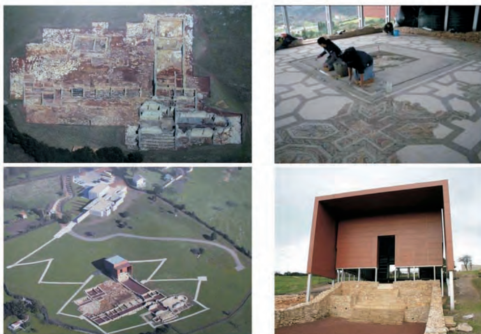
Fig. 2.- En la villa romana de Veranes (Asturias) se aprovechó la necesidad de conservar un gran mosaico para reconstruir el volumen de la construcción original a partir de los datos arqueológicos y cubicajes extraídos de la excavación. El resto de la consolidación de paramentos se hace con separadores, recreciendo lo mínimo para proteger la fábrica original.
