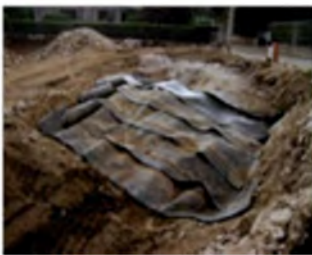
Lona caucho en zona voladura
