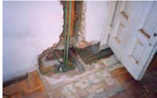
Ejecución de prótesis en pie derecho deteriorado
