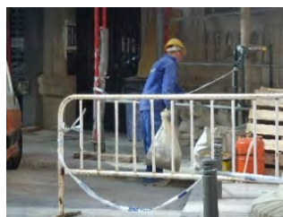
Manipulación de escombros en sacos.
