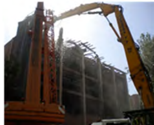
Lona neopreno (lona de caucho) suspendida de unas eslingas que son portadas desde el brazo de la grúa
