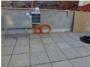
Cubierta con losa filtrante
