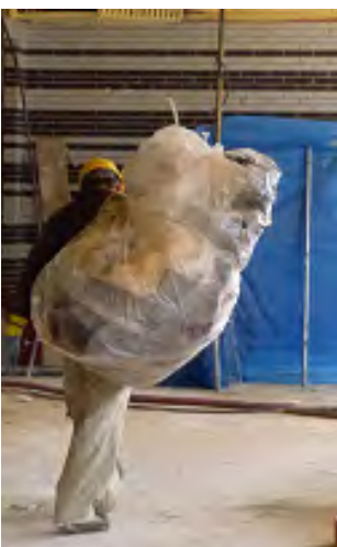
Manipulación de escombros en sacos (restos de embalajes)
