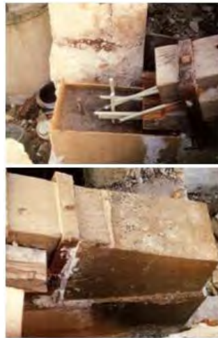
Prótesis en viga deteriorada
