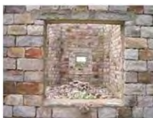
Construcción con piedra
