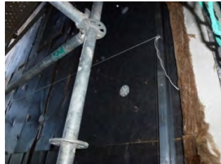
Panel de lana de roca y perfil vertical
