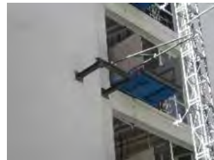
Plataforma de descarga de montacargas eléctrico
