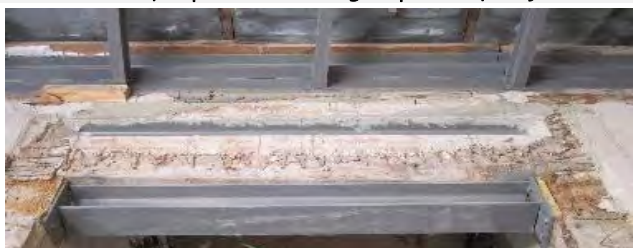
Cargadero metálico en refuerzo del existente de madera
