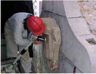
Limpieza con técnica láser
