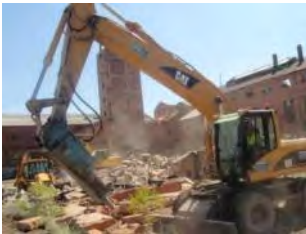
Martillo compresor en retroexcavadora
