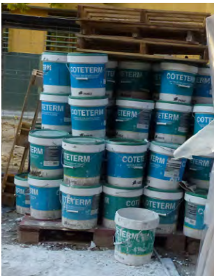
Revestimiento acrílico (acopio)
