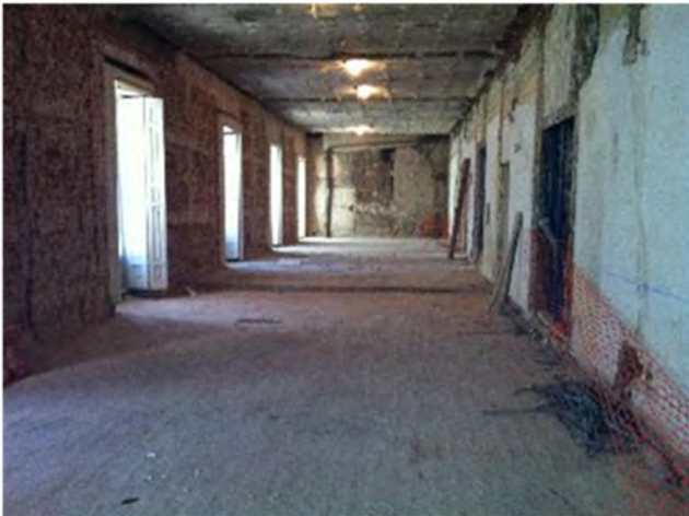
Forjado a demoler
