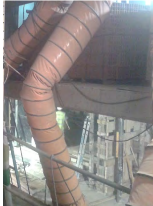
Instalación ventilación forzada
