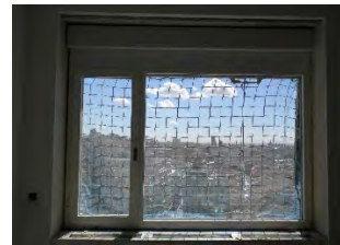
Red vertical ventana sobre soportes Especiales telescópicos
