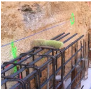
Armadura en reclace
