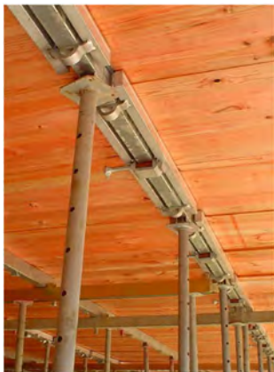
Entablado bajo forjado previo
