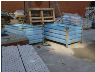
Contenedores de material (grúas)
