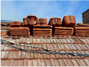
Cubrición con teja (acopio)
