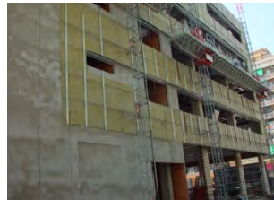
Lana de roca en fachada ventilada
