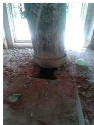
Boca de trompa de vertido en andamio tubular.
