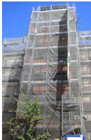
Andamio prefabricado de fachada
