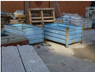
Contenedores de material (grúas)
