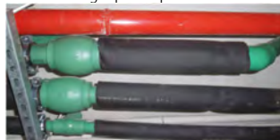
Tuberías aisladas
