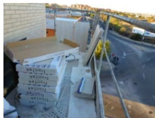
Acopio de baldosas en monomástil
