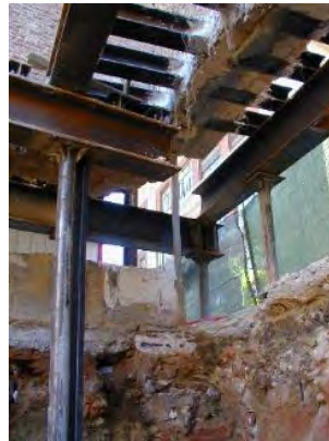
Perfiles metálicos de refuerzo
