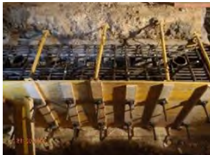
Encofrado "in situ" cimentación
