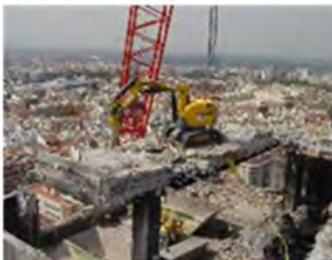
Robot trabajando: Demolición de forjado desde plano superior, sin intervención humana.
