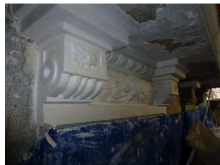
Restauración acabados en molduras
