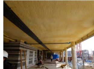
Poliuretano proyectado en techo
