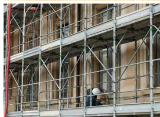
Restauración de fachadas
