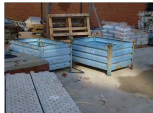
Contenedores de material (grúas)
