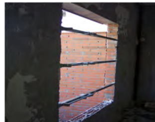
Barandillas en ventanas.
