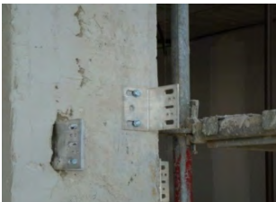
Anclajes para estructura soporte fachada ventilada
