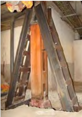
Apeo interior de pilar
