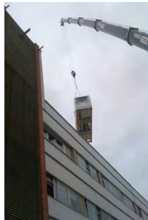
Elevación de equipos de climatización a cubierta mediante grúas
