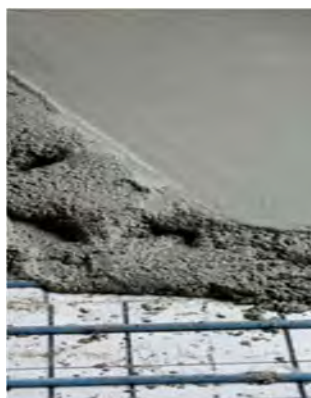
Extendido de morteros
