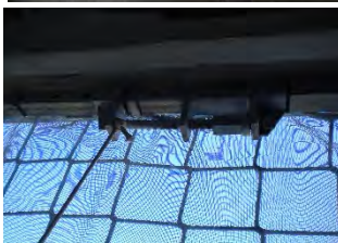
Soporte especial: Montante superior red ventana
