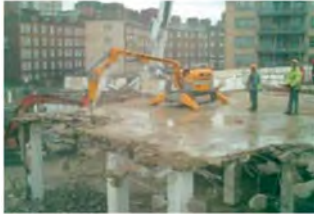
Robot trabajando: Demolición de forjado desde plano superior, sin intervención humana.
