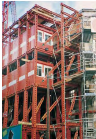
Fachadas apuntaladas. Fachadas cáscara
