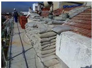
Sacos de arena (acopio)
