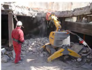
Robot trabajando: Demolición de forjado desde plano inferior, sin intervención humana.
