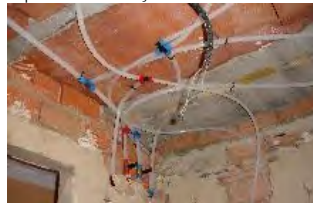
Rehabilitación integral de vivienda. Fontanería
