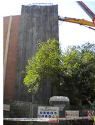
Lona neopreno (lona de caucho) suspendida de unas eslingas que son portadas desde el brazo de la grúa
