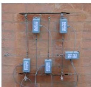
Ensayo del estado de tensión con gato plano
