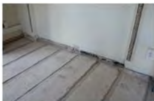
Superficie de forjado antes de ser reforzado: retirada de solado
