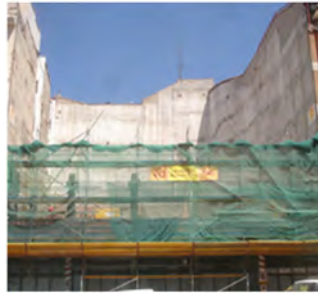
Andamio en fachada para demolición secuenciada del edificio
