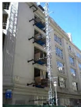
Plataforma de descarga de montacargas eléctrico
