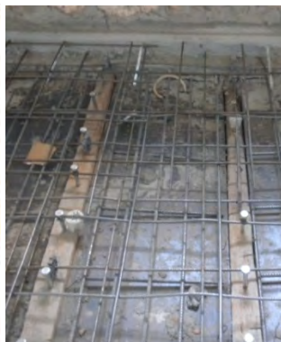
Superficie de forjado antes de ser reforzado: retirada de solado
