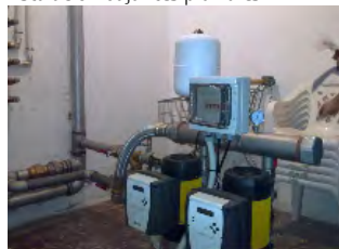
Sustitución grupo de presión
