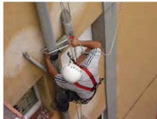
Reparación de bajantes
