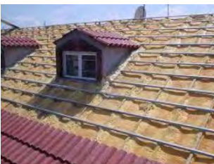
Aislamiento bajo teja con espuma de poliuretano
