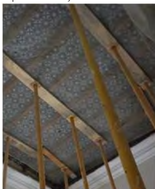
Superficie de forjado antes de ser reforzado: retirada de solado
