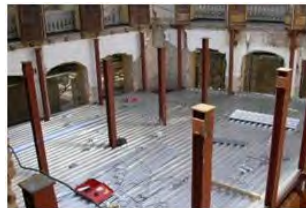
Forjado con chapa colaborante
