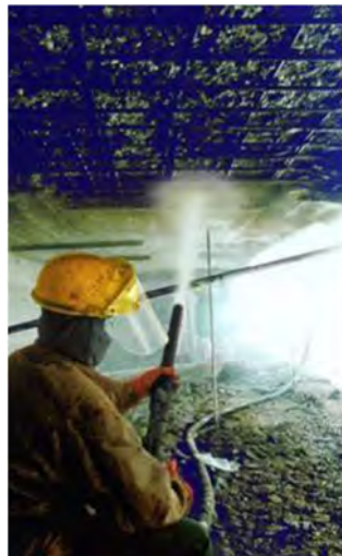
Extendido manual del mortero de reparación
