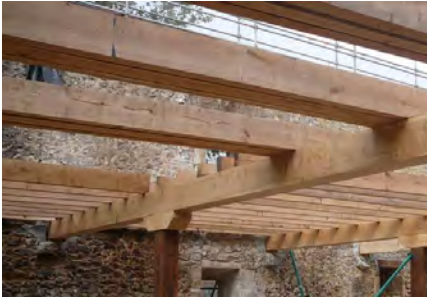
Estructura de cubierta
