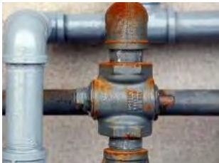
Tubería de plomo
