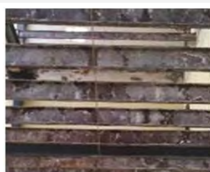
Refuerzo de viga jácena mediante incorporación de pletina en su ala inferior
