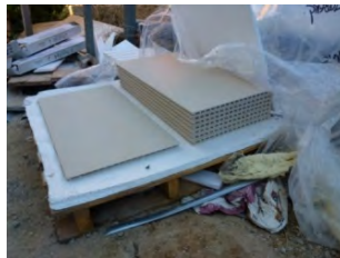
Despaletización de las cargas
