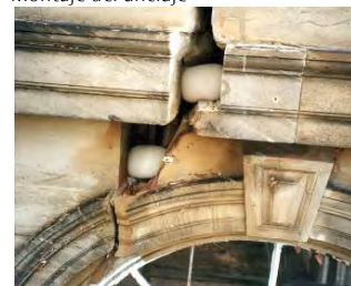
Sistema de anclaje finalizado
