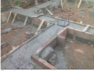
Encofrado cimentación
