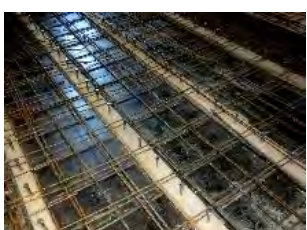
Refuerzo de forjado mediante hormigonado del entrevigado
