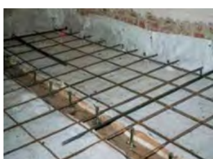
Refuerzo de forjado capa de compresión
