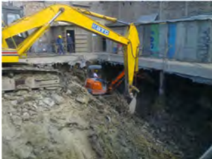
Excavación bajo losa de transición con maquinaria especial.
