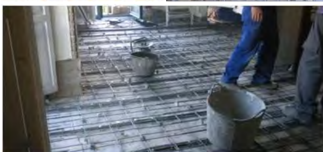
Trabajos previos a la operación de recrecido: retirada del solado, apeo, colocación de conectores en vigas y montaje del mallazo de reparto.
