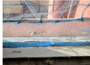
Fijación inferior de mosquitera en ventana
