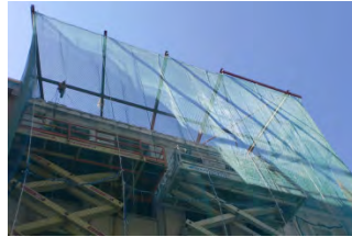
Estructura soporte volada
