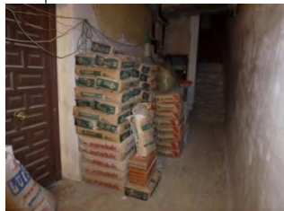
Acopio de sacos dejando amplitud de paso
