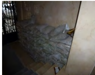
Acopio de sacos de arena de río de 15kg, adosado a pared
