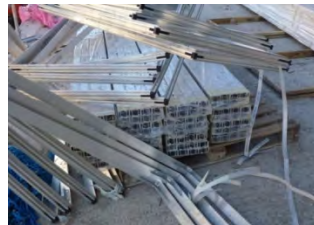
Acopio de perfiles metálicos
