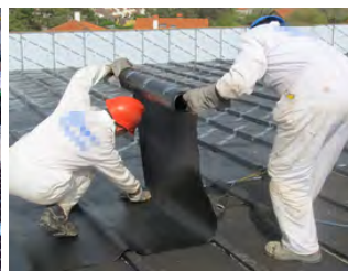
Extendido de tela asfáltica
