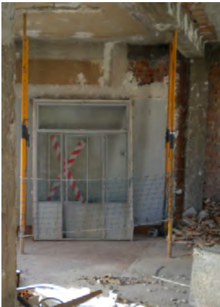
Balizamiento y señalización
