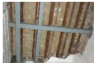
Refuerzo de forjado mediante parteluces metálicos
