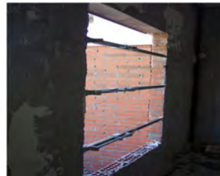
Barandillas en ventanas.
