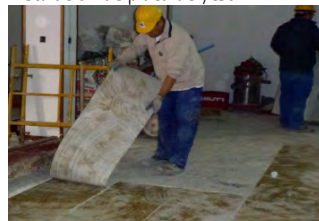
Retirada de suelo existente
