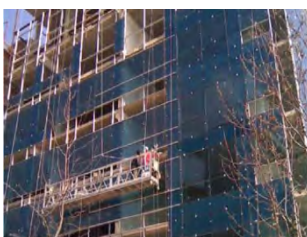
Muro cortina acristalado
