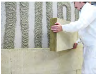
Montaje paneles SATE
