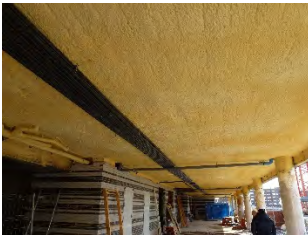
Poliuretano proyectado por exterior de suelo
