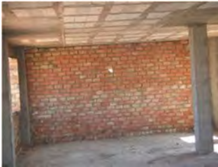
Tabique de ladrillo
