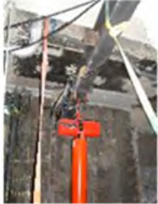
Maquinillo adaptado a andamio
