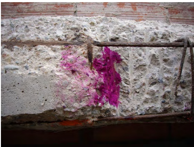
Solución fenolftaleína en estructura de hormigón
