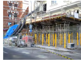
Plataforma de embarque en fachada principal
