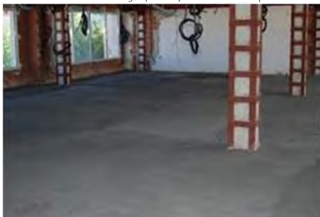
Trabajos previos a la operación de recrecido: retirada del solado, apeo, colocación de conectores en vigas y montaje del mallazo de reparto.
