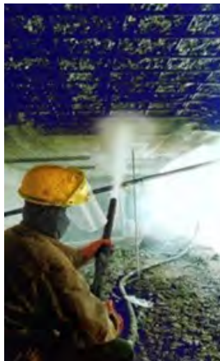
Extendido manual del mortero de reparación
