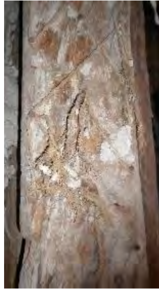
Pilar de madera en fase de reparación
