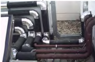
Tuberías aisladas
