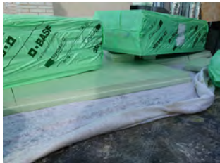
Geotextil y paneles rígidos XPS
