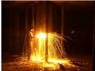
Corte de los micropilotes provisionales en sótano, disponiendo de la estructura vertical definitiva.
