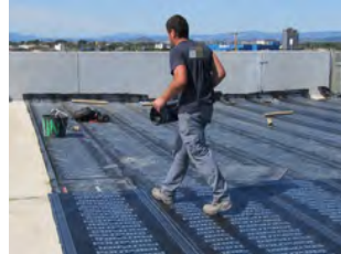
Transporte de tela asfáltica
