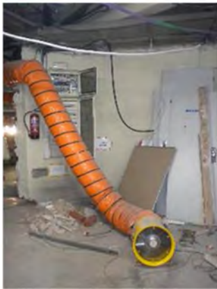
Ramificación ventilación forzada
