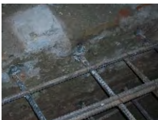
Detalle de anclaje con armadura y resina epoxi de fijación.
