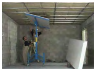
Instalación de placa de yeso
