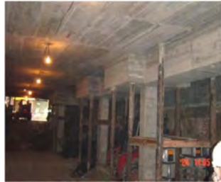
Micropilotaje exterior e interior provisional de sustentación y ejecución de losa de transición mediante conectores y hormigón armado.
