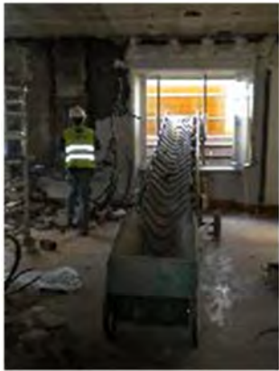
Cinta transportadora colocada en hueco de fachada
