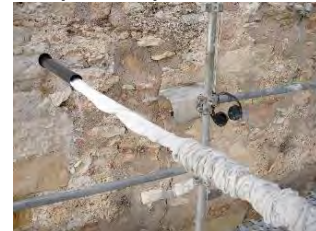
Montaje del anclaje
