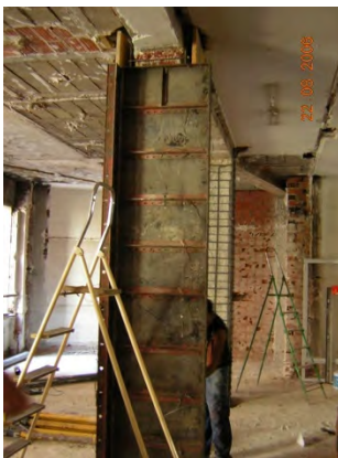
Encofrado vertical
