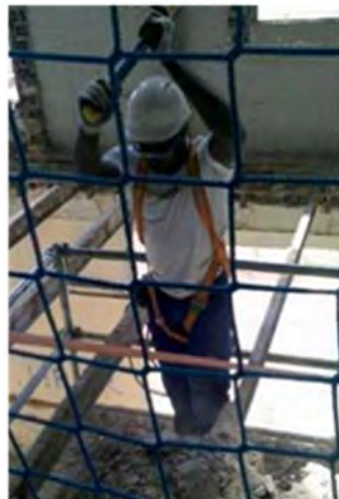
Demolición manual desde andamio
