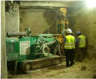
Micropilotaje exterior e interior provisional de sustentación y ejecución de losa de transición mediante conectores y hormigón armado.
