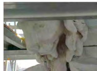
Sellado de fisuras con mortero entonado fluido
