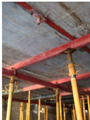
Encofrado horizontal
