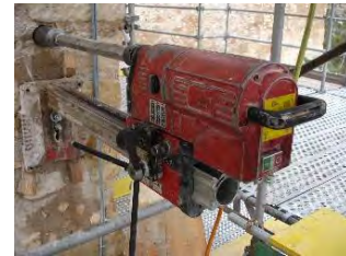
Perforación con equipos, última generación que reducen vibraciones
