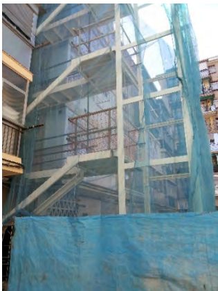
Estructura modular: Montaje
