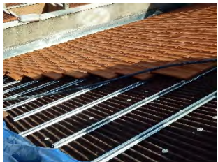
Chapa ondulada, rastreles y cubrición
