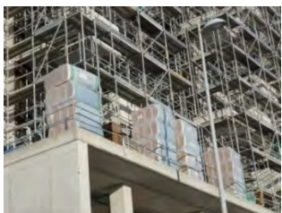
Acopio de lana de roca
