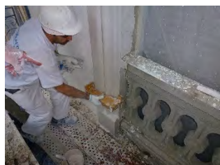
Molduras de escayola in situ
