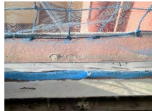
Fijación inferior de mosquitera en ventana
