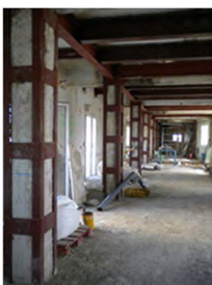
Refuerzo de forjado mediante viguetas de apeo bajo vigas
