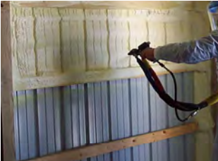
Poliuretano proyectada en paramento
