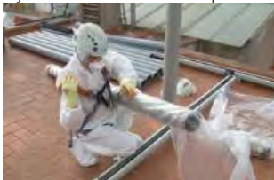
Retirada de conductos de fibrocemento
