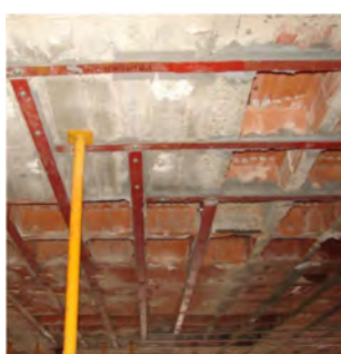
Refuerzo de viga mediante chapa pegada
