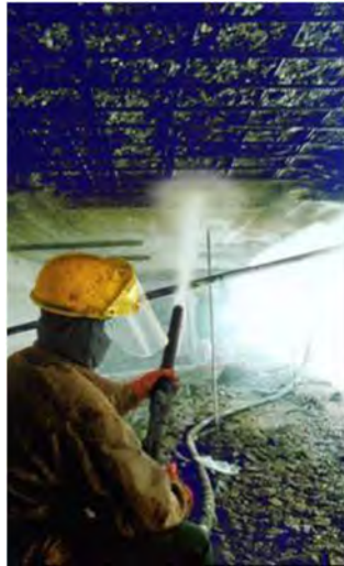
Extendido manual del mortero de reparación
