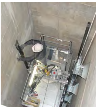
Plataforma móvil: provisionales o incorporadas en la base de la cabina
