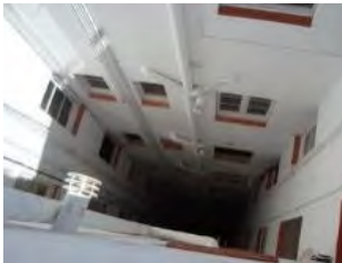
Bajantes de fibrocemento en patio
