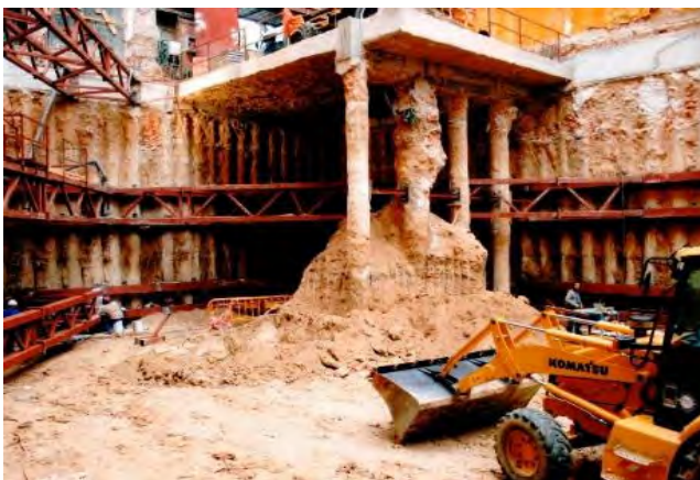
Excavación mediante plataforma de trabajo
