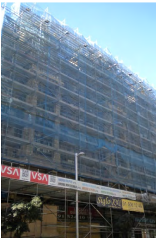
Andamio prefabricado de fachada
