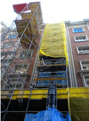
Trompa de vertido en andamio
