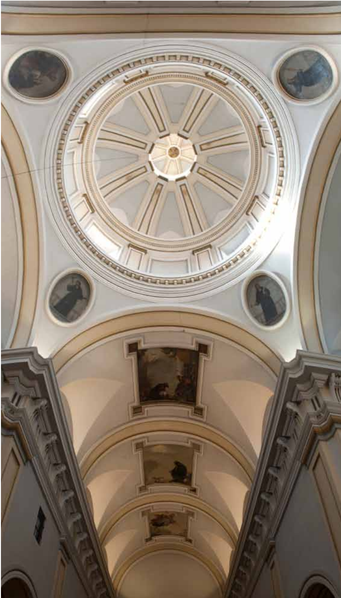
43. Convento de Agustinas Recoletas (Colmenar de Oreja). Vista general cúpula y nave. Foto JCML
