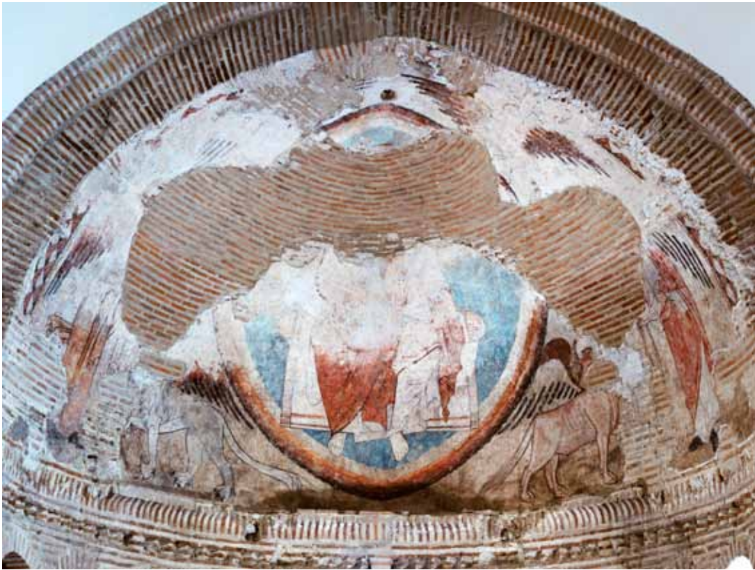
4. Los restos pictóricos y su lógico material subyacente como es el ladrillo, son fácilmente procesados como desprendimiento parcial. Si en vez de ladrillo fuera una capa de enlucido de algún color, sería difícil interpretar su función y en qué momento temporal lo encuadramos. Foto GFG
