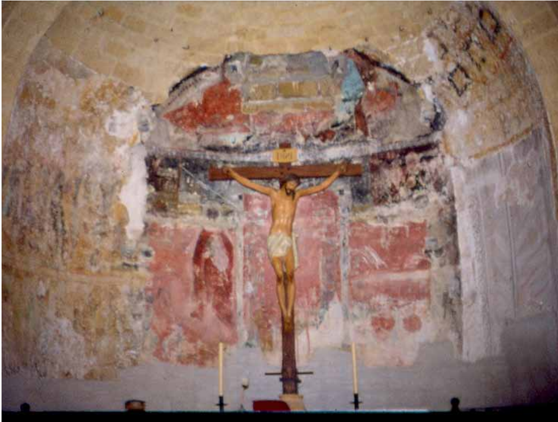
7. La coexistencia de distintas capas pictóricas, morteros subyacentes y lagunas hacen a veces imposible la menor interpretación de esos restos. Necesitamos aclarar niveles y eliminar las lagunas para devolver su valor histórico estético. Foto GFG
