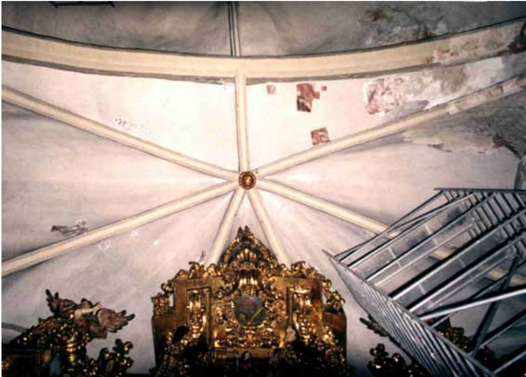
2. Zona de las bóvedas donde se realizaron las primeras catas. Foto Ágora S.L.
