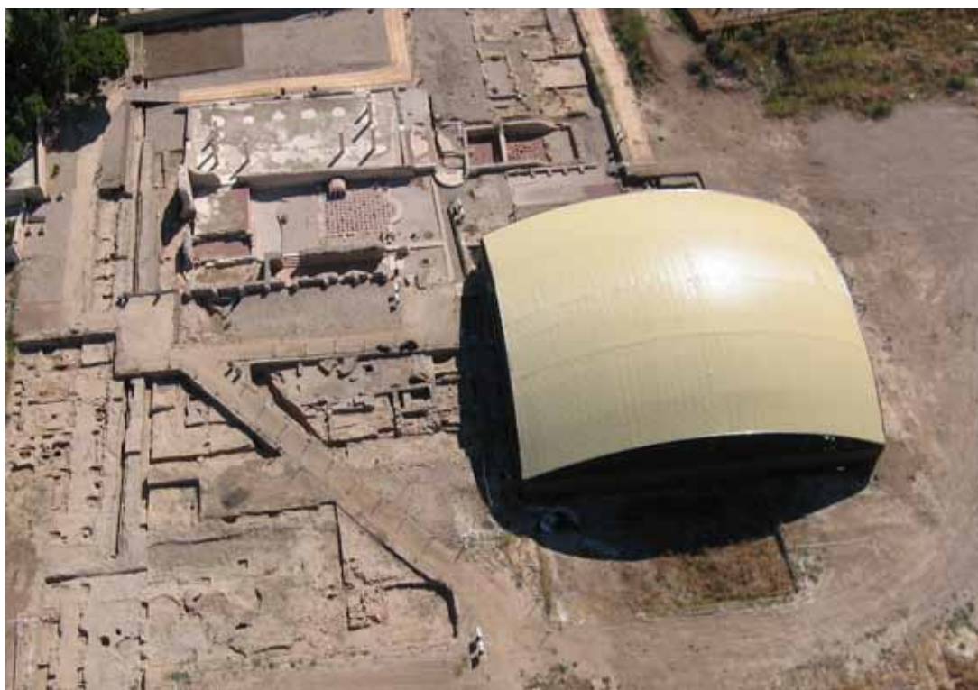
1. Vista de la cubierta colocada sobre la casa de los Grifos en el yacimiento de Complutum. Foto Ayuntamiento de Alcalá de Henares
