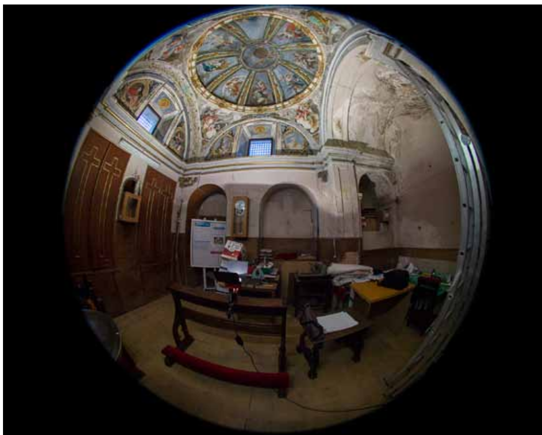
1. Estado de conservación de la capilla antes de la intervención. Foto JJL
