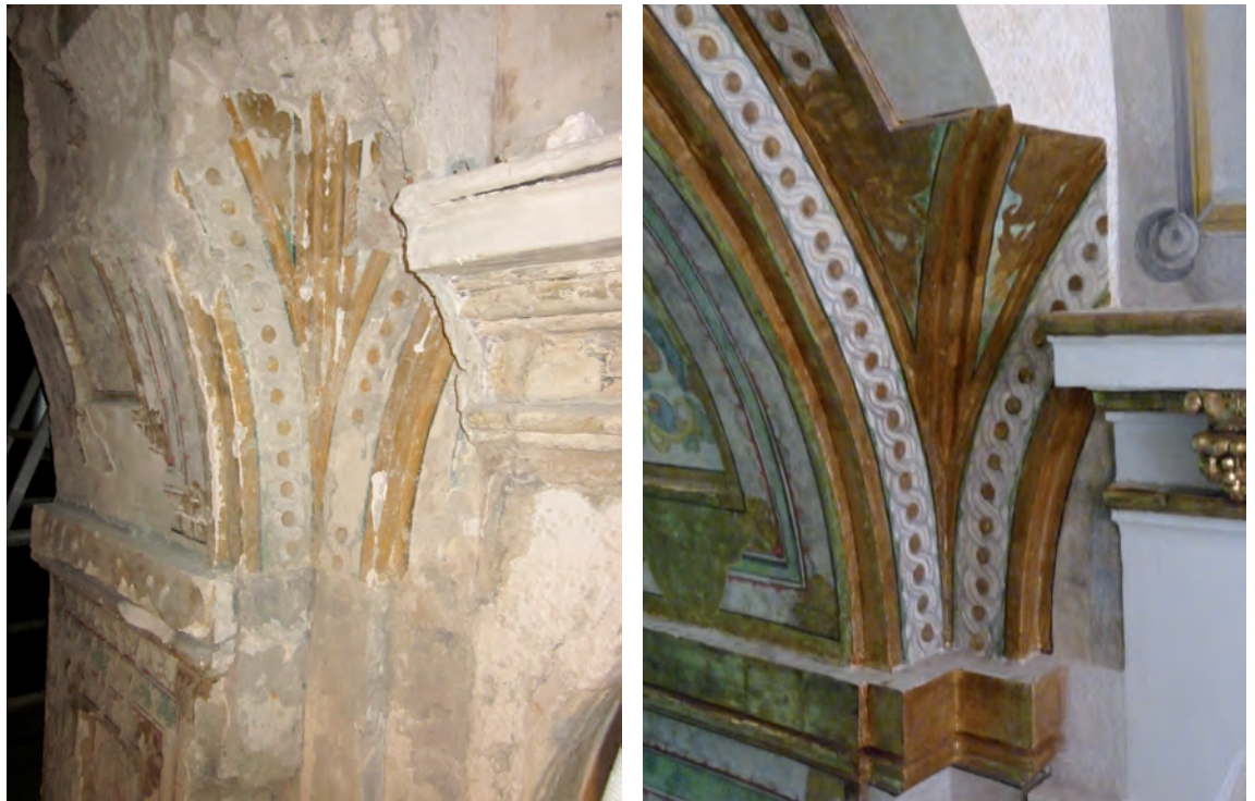
Arco del primer camarín antes y después de la intervención.
