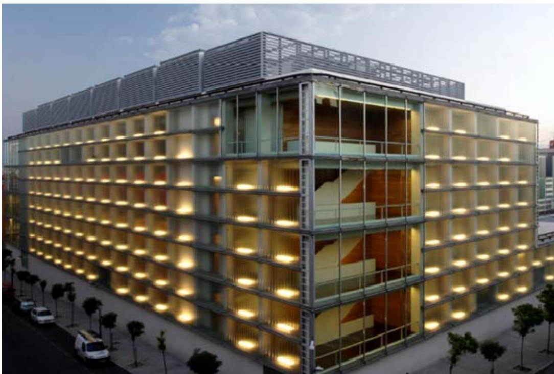
El edificio de depósitos en el Complejo ‘El Águila’ es uno de los cuatro que conforman el Archivo Regional de la Comunidad de Madrid (C/ Ramírez de Prado, 3).
