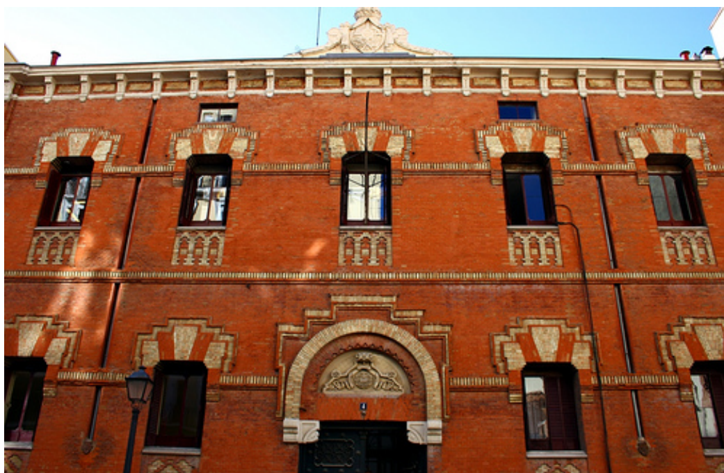
Edificio de Alberto Bosch, 4.
