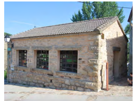
Arriba foto del interior del lavadero en el estado actual. Abajo vista exterior de lavadero, fachada norte.
