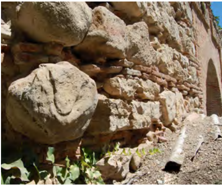
Caída de ladrillos que deja varios bolos de piedra de gran tamaño sin apoyo, generando un riesgo importante tanto para la estabilidad del monumento, como para el uso del espacio público adyacente.
