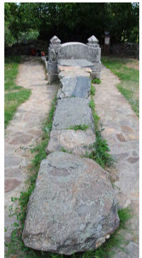
Vista del canal de acometida cubierto.
