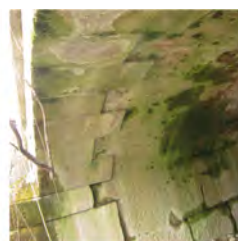
4. Las bóvedas se encuentran ligeramente rehundidas con respecto a las dovelas de 50 cm de ancho que determinan el paramento vertical de los alzados y que se introducen hacia el interior intercalando su ancho entre piezas
