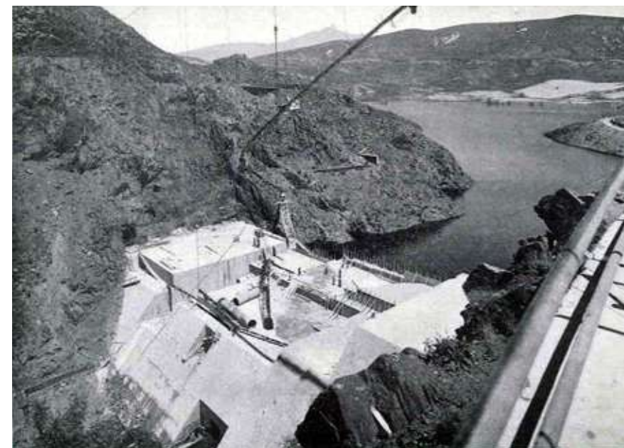
Figura 4.53. Vista fronto-lateral de la presa El Vado, ca primavera 1946
