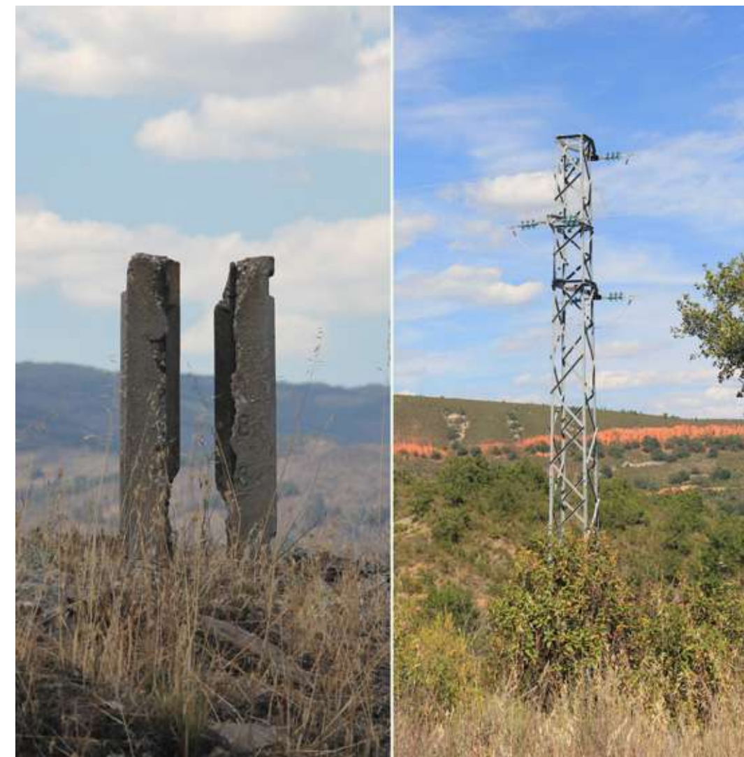
Figura 5.29. Anclaje de hormigón para poste de madera, en el antiguo tendido de alta tensión y Figura 5.30. Soporte metálico de la línea actual.
