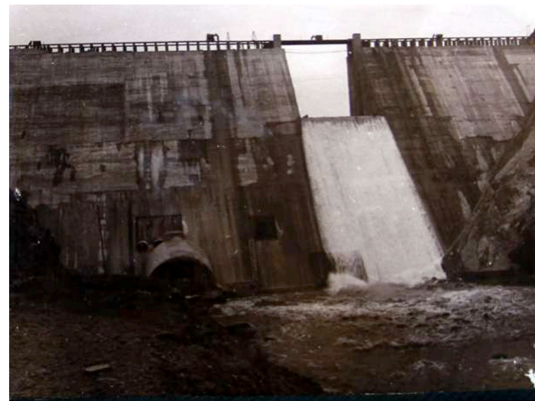
Fuente: CHT Archivo técnico de la presa de Alcorlo. Álbum nº 1 de las obras de El Vado pág. 48, imagen 100.
