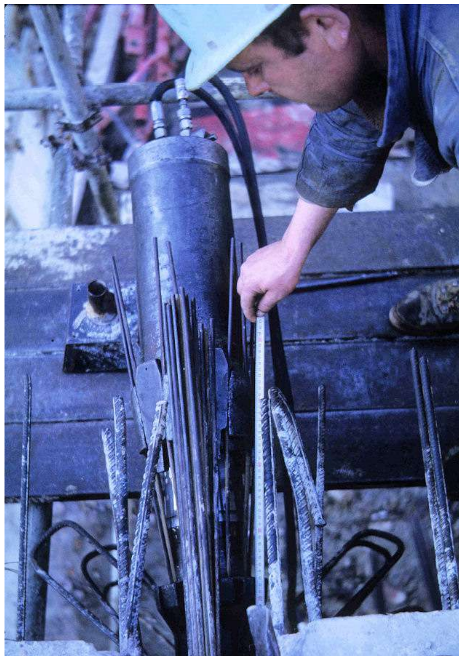
Figuras 4.163. El Vado, pretensado en el anclaje los cajeros del aliviadero frontal. Ca. 1972
