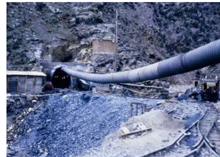
Figura 6.21. Pozo de los Ramos. Trasvase Sorbe-Jarama. Boca nº 1, entrada al túnel principal
