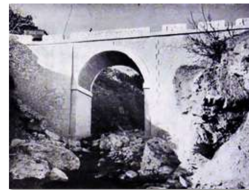
Figura 5.21. Puente sobre el arroyo de Tortuero
