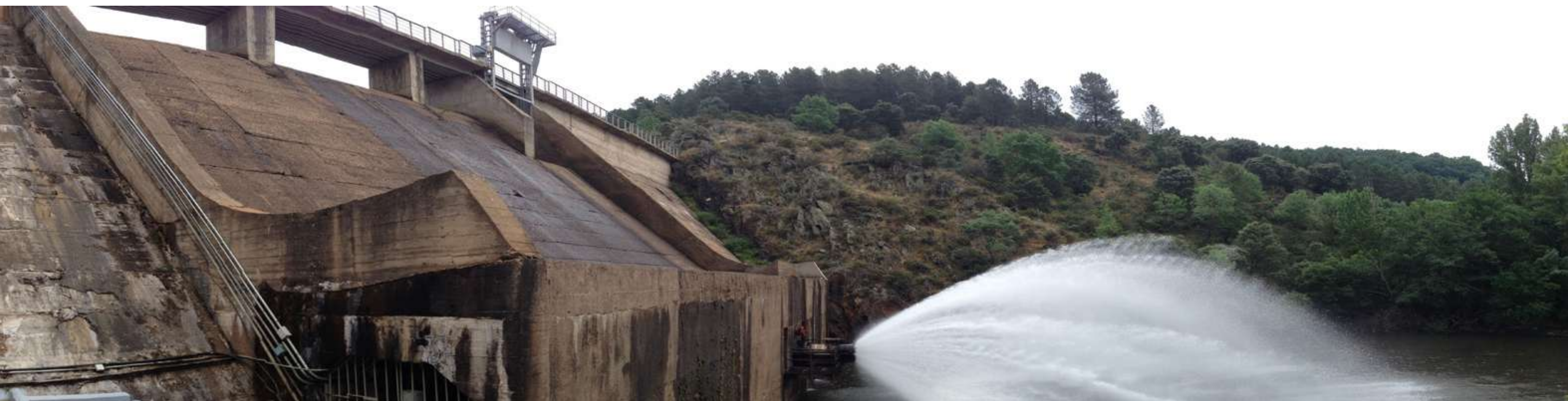
Figura 6.17. Panorámica frontal desde el estribo derecho del azud del Pozo de los Ramos, con el desagüe de fondo abierto
