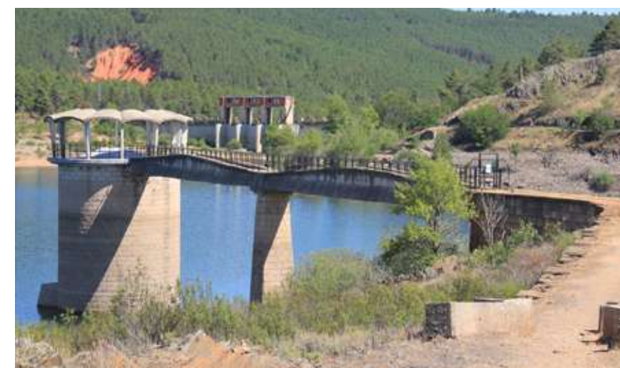
Figuras 5.40. Exterior de la torre de toma con su pasarela
