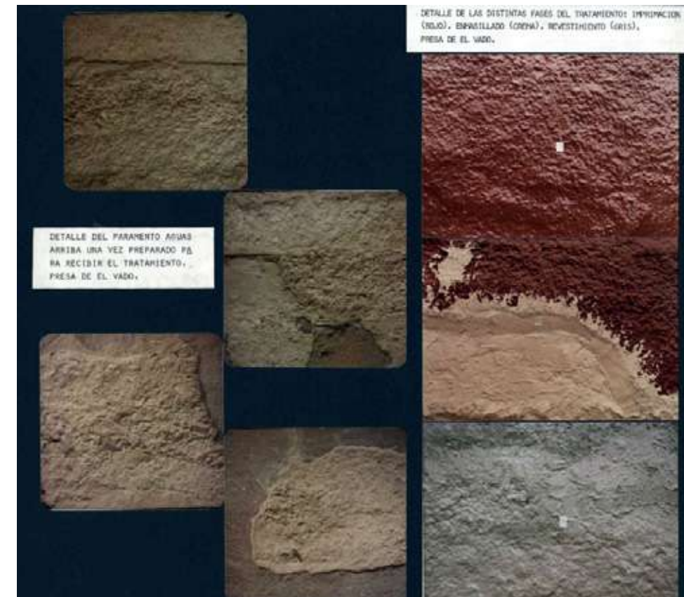
Figura 4.177. Trabajos de experimentación en el paramento de aguas arriba de El Vado. 1979. Zona de análisis del paramento y tratamiento aplicado
