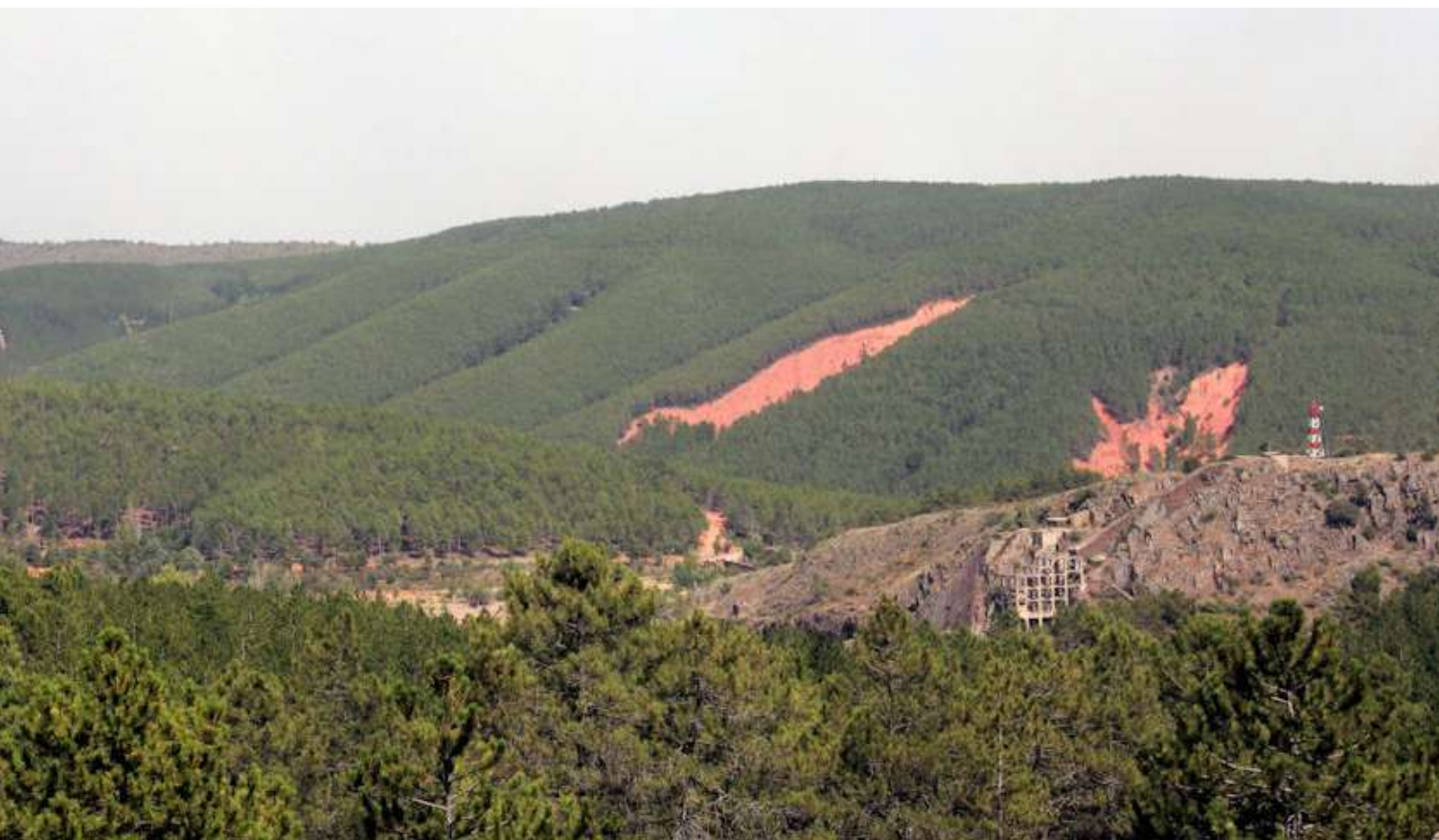
Figura 4.42. Vista general con la posición de los dos terminales, desde la derecha del embalse de El Vado
