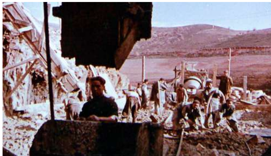
Figura 5.4. Hormigonado de los cimientos de la torre de toma
