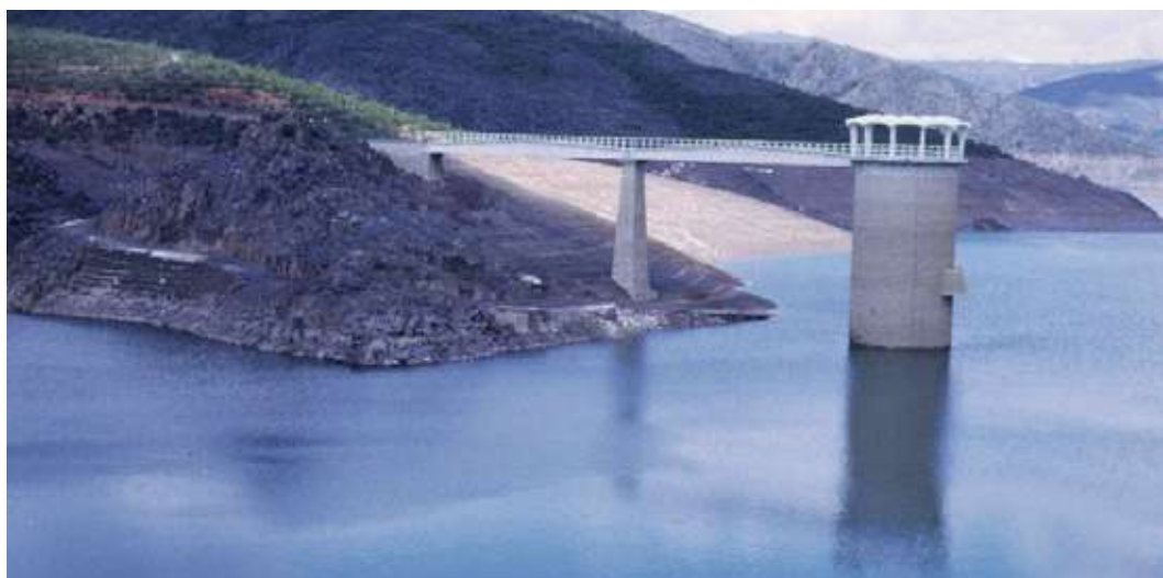
Figura 4.137. Torre de toma del canal del Jarama en El Vado. Diapositiva sin fecha, hacia 1971-72
