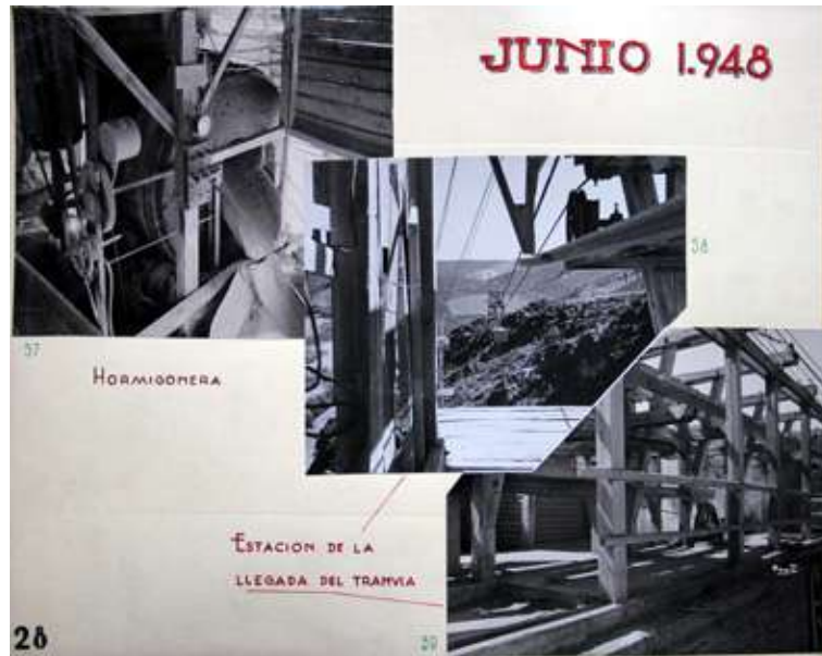
Figuras 4.43. y 4.44. Teleférico (tranvía aéreo) de la presa de El Vado, junio de 1948 y febrero de 1949
