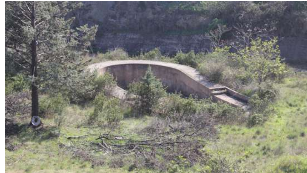
Figura 4.79. Alberca para alimentar un modelo a escala del aliviadero (1951)
