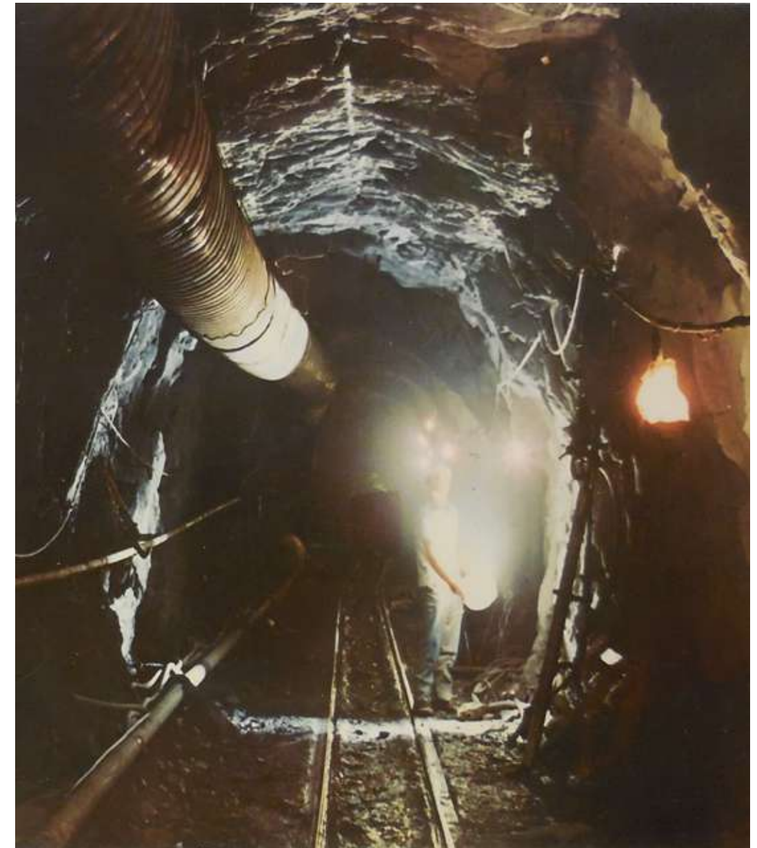
Figura 6.23. Trasvase Sorbe-Jarama. Interior del túnel, con las conducciones y vías necesarias para la perforación. Agromán 1973
