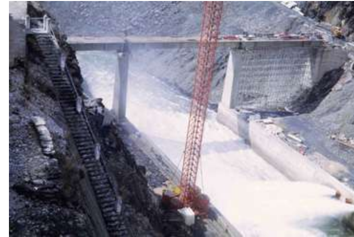
Figura 4.156. El Vado, vista del canal de encauzamiento del desagüe del aliviadero frontal, desde el estribo izquierdo de la presa, a la altura de la coronación. En la parte inferior derecha de la imagen, los desagües intermedios vertiendo agua. En el centro de la imagen, el puente-acueducto para el trasvase del Sorbe, en construcción. Ca. 1972
