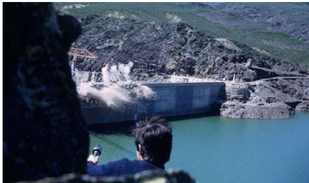
Figuras 4.160 a 4.162. El Vado, aliviadero frontal voladura para apertura del vano. Ca. 1972
