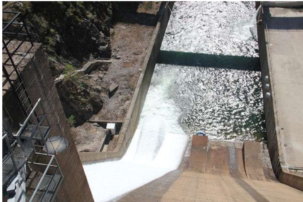
Figura 4.171. El Vado. Vertido por el vano izquierdo del aliviadero. En el diente central del cuenco, la salida del desagüe de fondo. En el cajero derecho del encauzamiento, las tres salidas de los correspondientes desagües intermedios
