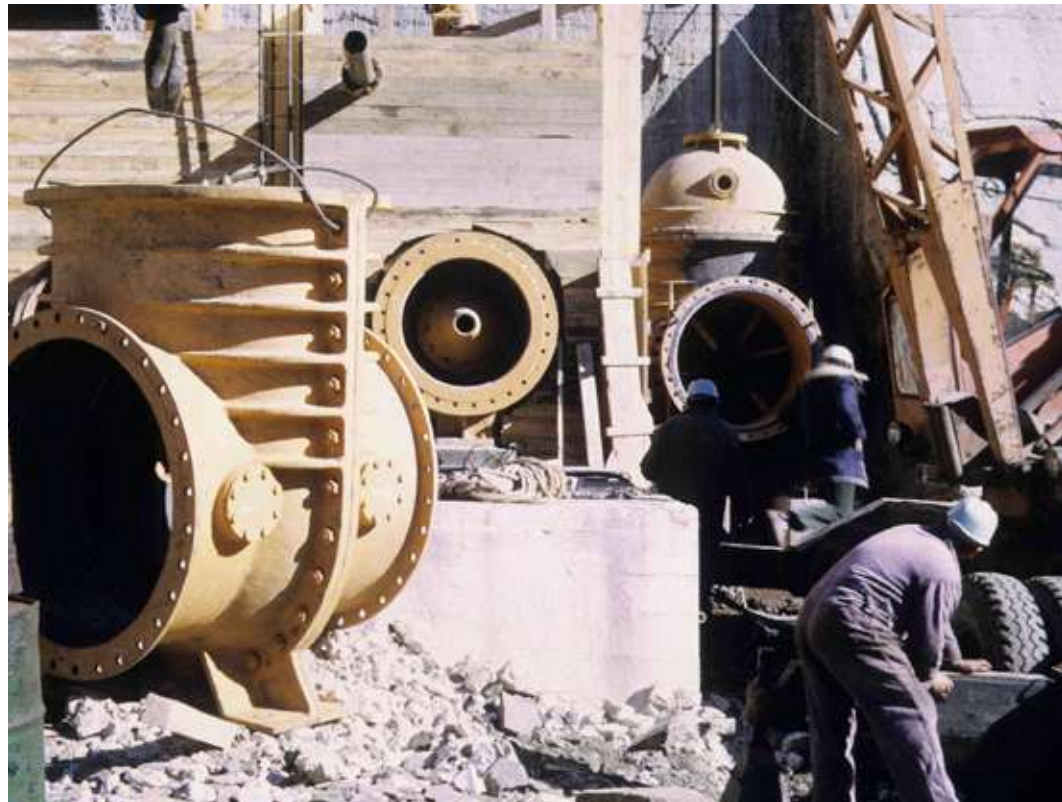
Figura 4.158. El Vado, Desagües intermedios. Sustitución de válvulas. Ca. 1971-72
