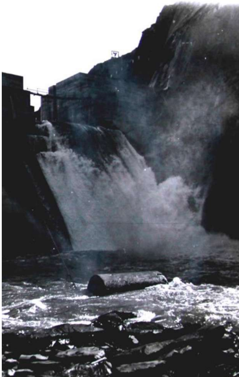
Figura 4.56. Crecida de marzo de 1947, vertiendo en la ladera izquierda
