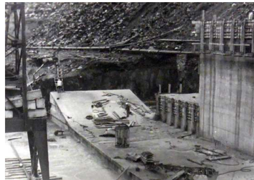
Figura 4.141. Obras en el cuenco amortiguador situado al pie de la presa de El Vado, mirando desde la margen izquierda a la derecha, hacia agua abajo. Obsérvese la rampa para el lanzamiento del agua hacia la continuidad del cauce. 15/10/1966
