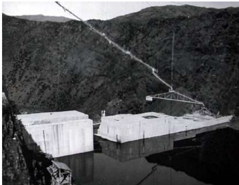
Figuras 4.64 y 4.65. Pantano de El Vado, vertido de hormigón mediante canaletas móviles. Marzo y abril de 1947
