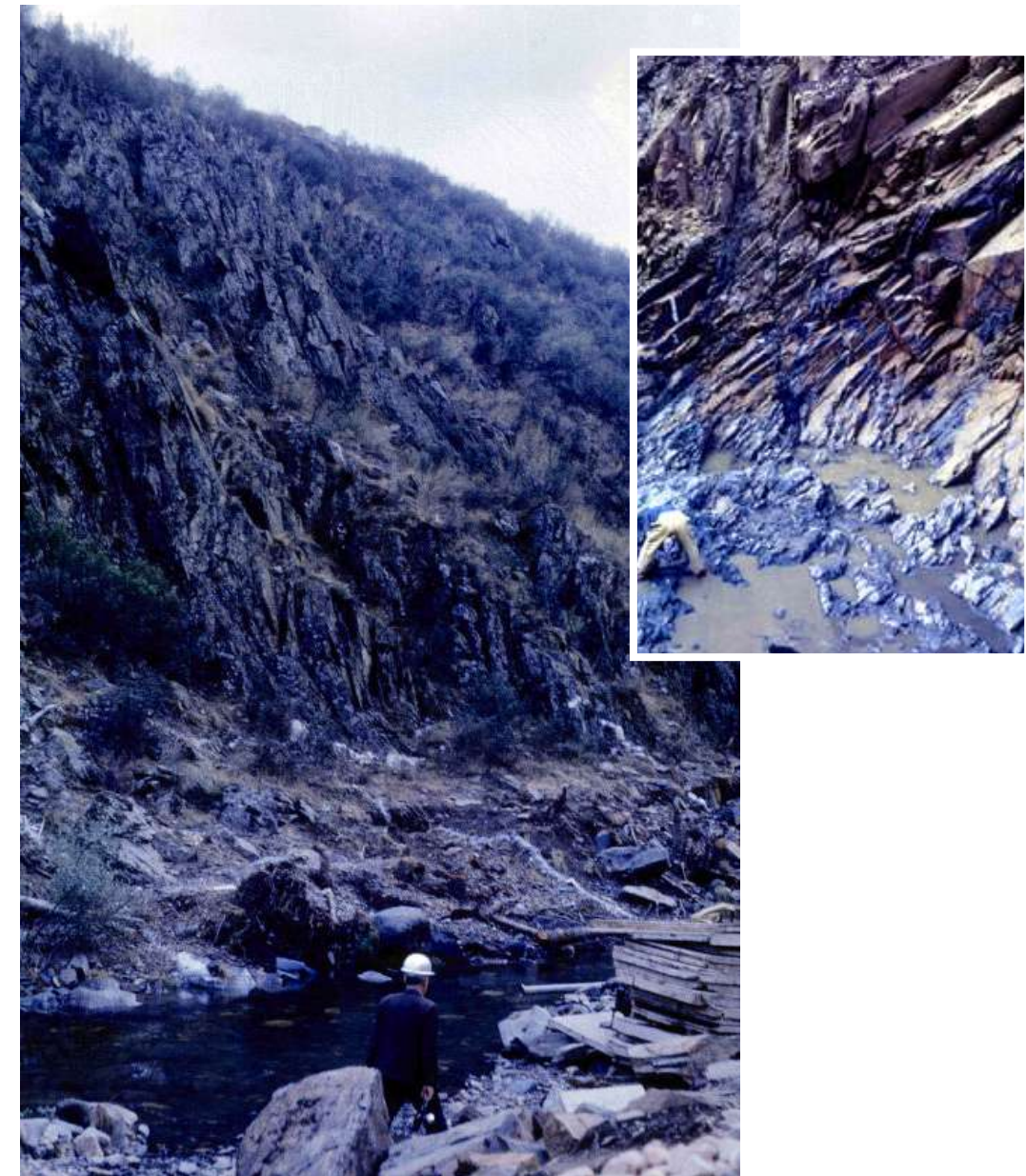
Figuras 6.10 y 6.11. Trazado de la excavación de cimientos en el azud del Pozo de los Ramos e inicio de los trabajos de roza sobre la roca de pizarra. Ca. 1967
