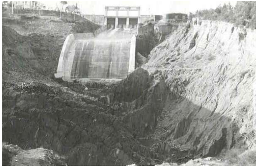
Figura 4.145. El aliviadero lateral en junio de 1969. Perspectiva desde el extremo del canal, con el colchón amortiguador y la erosión producida en ambas márgenes por los vertidos
