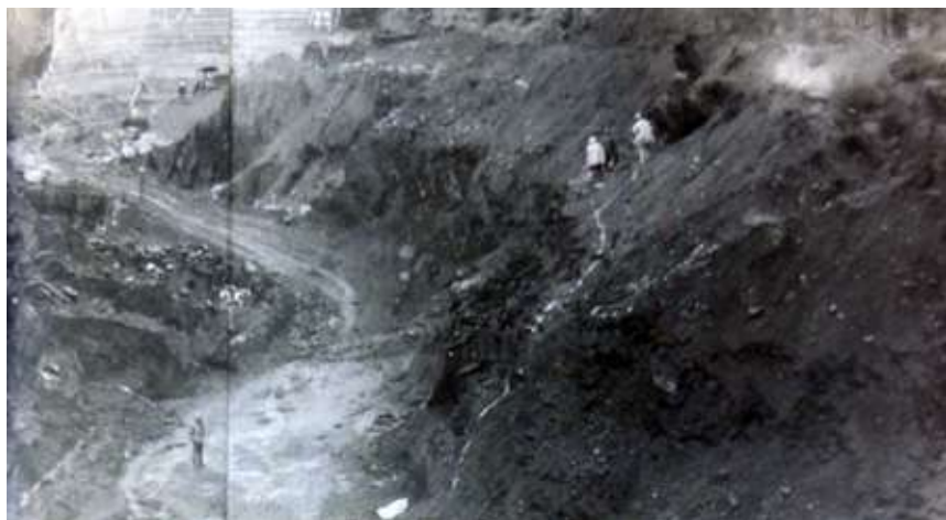
Figura 4.146. Barranco agua abajo del aliviadero del Collado, con el terreno marcado con jalones para situar el segundo azud de retención de los vertidos. 15/10/1966
