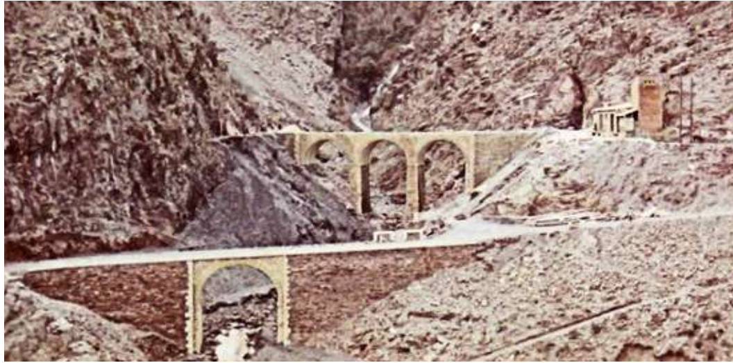
Figuras 5.22. Puente y acueducto sobre el barranco del Corcovado durante su construcción
