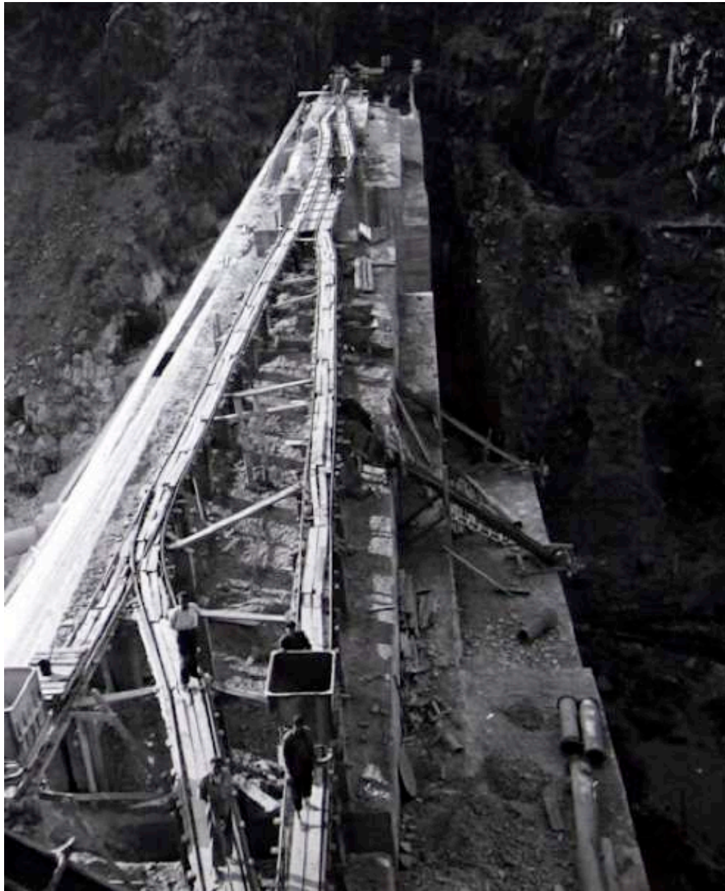
Fuente: CHT, Archivo técnico de la presa de Alcorlo, Álbum nº 1 de las obras de El Vado, pág. 32, imagen 72.
