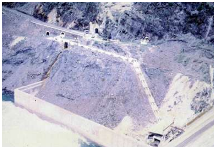
Figura 4.136. Conexión de los tubos de desagües intermedio de El Vado con el canal del Jarama. Diapositiva sin fecha, hacia 1971-72
