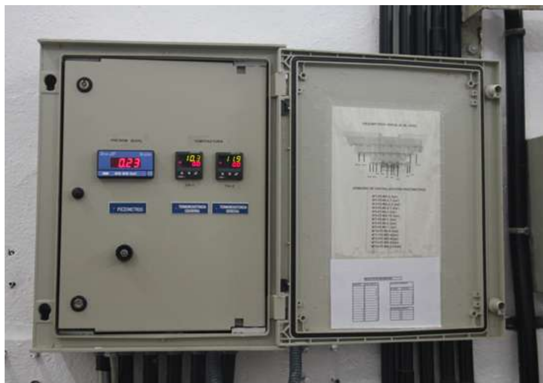
Figura 4.186. Control centralizado de piezómetros, presa de El Vado
