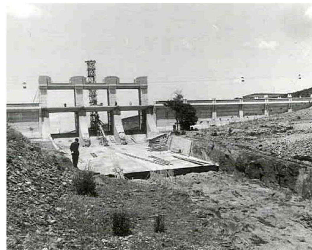
Figura 4.76. Aliviadero del Collado, pantano de El Vado, en construcción. Primavera de 1952
