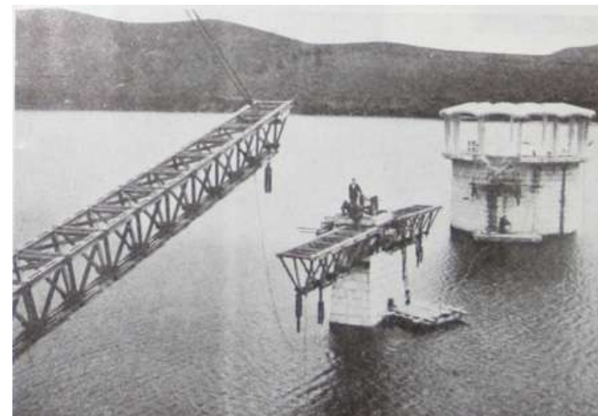
Figura 5.39. Colocación de cimbra para pasarela
