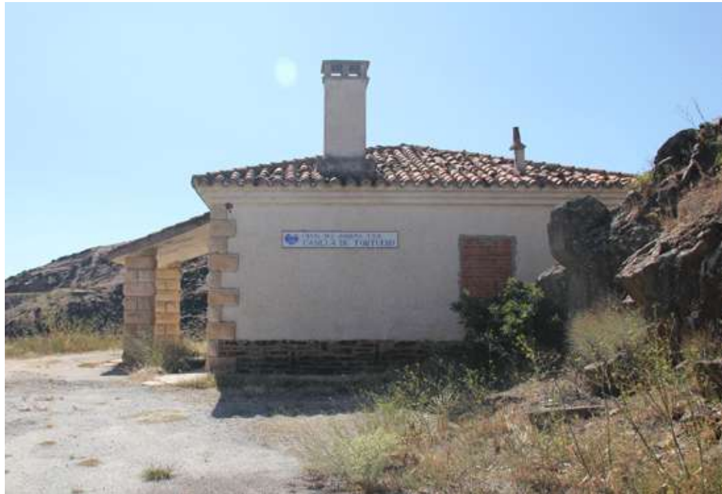
Figura 5.64. Casilla de vigilancia del canal del Jarama en Tortuero
