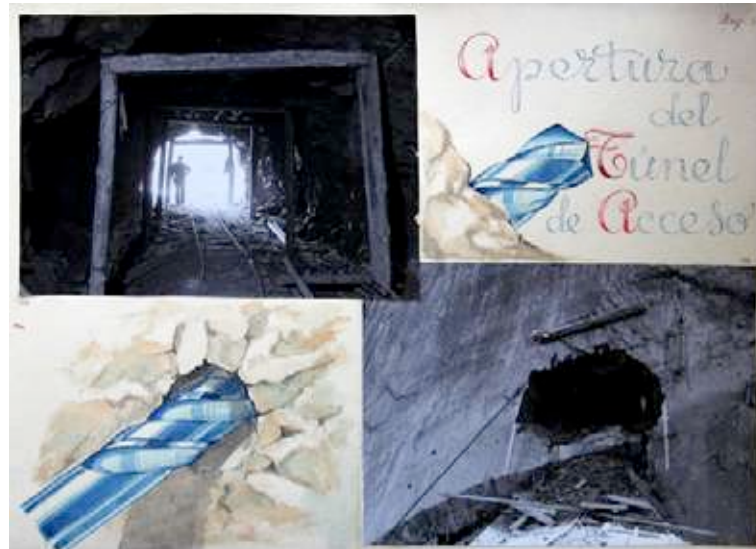
Figura 4.86. Pantano de El Vado, perforación del túnel de acceso
