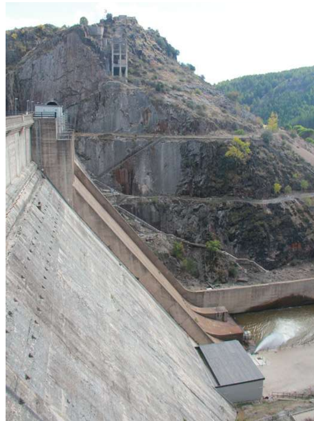
Vista de la presa de El Vado desde el estribo derecho: Al fondo los restos de la planta de hormigonado. F. Fernández Izquierdo. 2015
