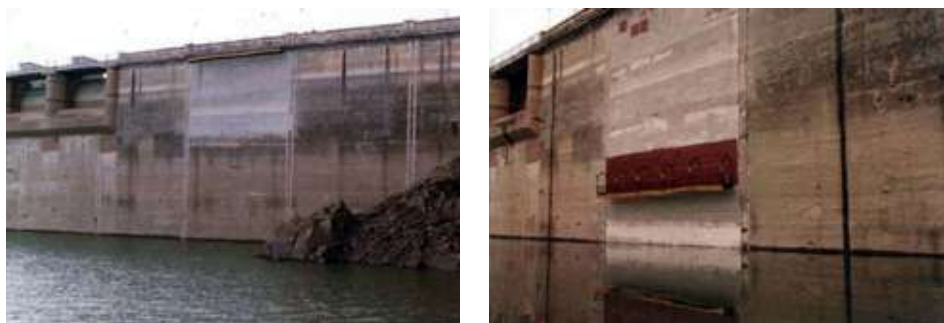
Figuras. 4.175 y 4.176. Trabajos de experimentación en el paramento de aguas arriba de El Vado. 1979. Zona de análisis del paramento y tratamiento aplicados
