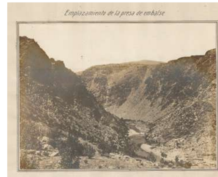
Figura 4.6. Fotografía del emplazamiento, vista tomada desde aguas arriba. Pantano de El Vado: Proyecto. 1910. Anejo 17
