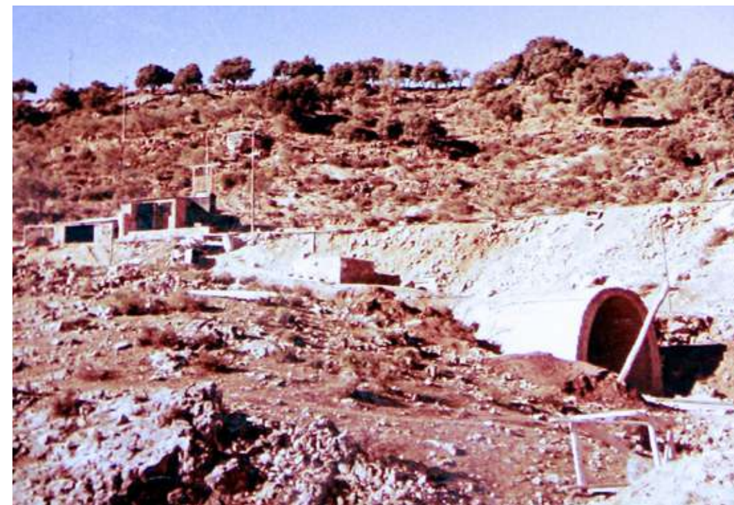
Figura 5.5. Boca de entrada al túnel nº 9
