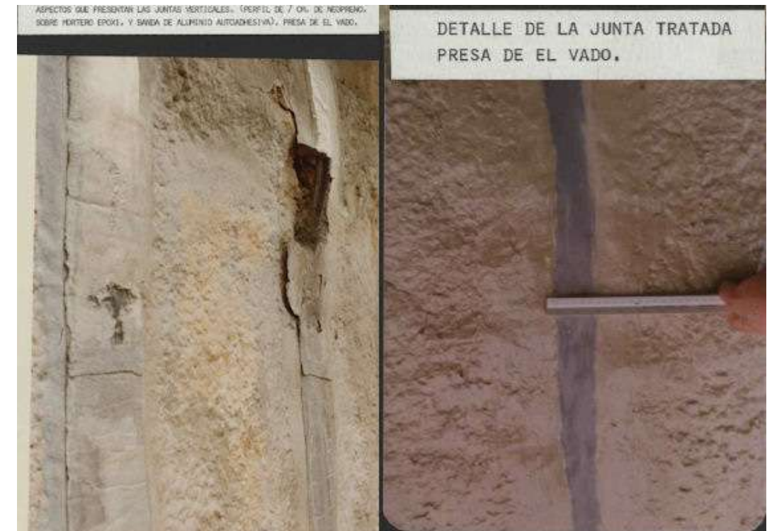
Figura 4.178. Trabajos de experimentación en el paramento de aguas arriba de El Vado. 1979. Tratamiento en las juntas
