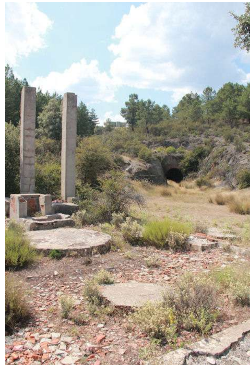
Figuras 4.36. Cantera de Tamajón. Asientos de la maquinaria en la zona de carga del ferrocarril
