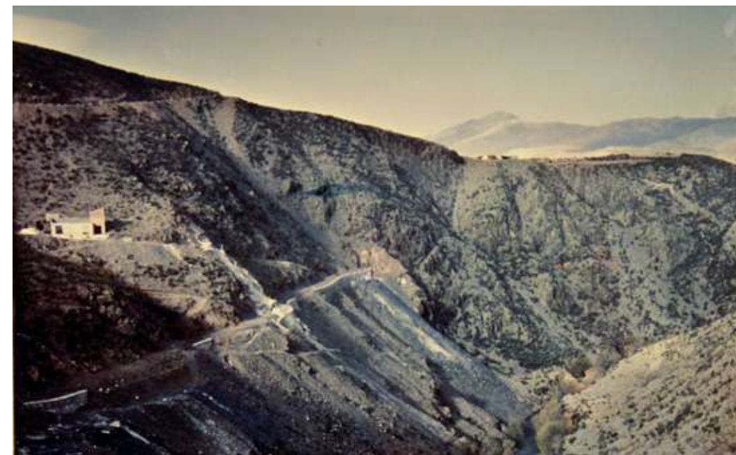
Figura 5.46 Canal del Jarama, excavación a cielo abierto en el Espanto
