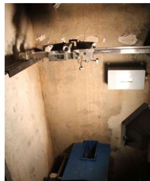
Figura 4.182. Pozo de uno de los péndulos de la presa de El Vado
