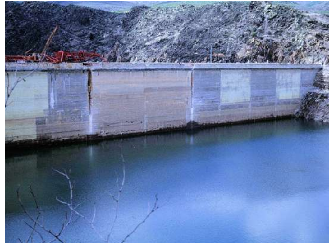
Figuras 4.159. El Vado, cortes para apertura del vano en el aliviadero frontal. Ca. 1972
