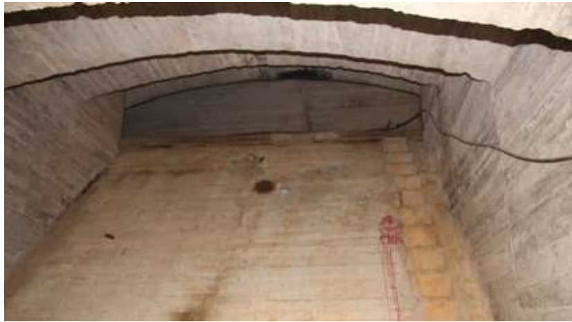
Figura 6.33. Rebosadero del canal del Sorbe
