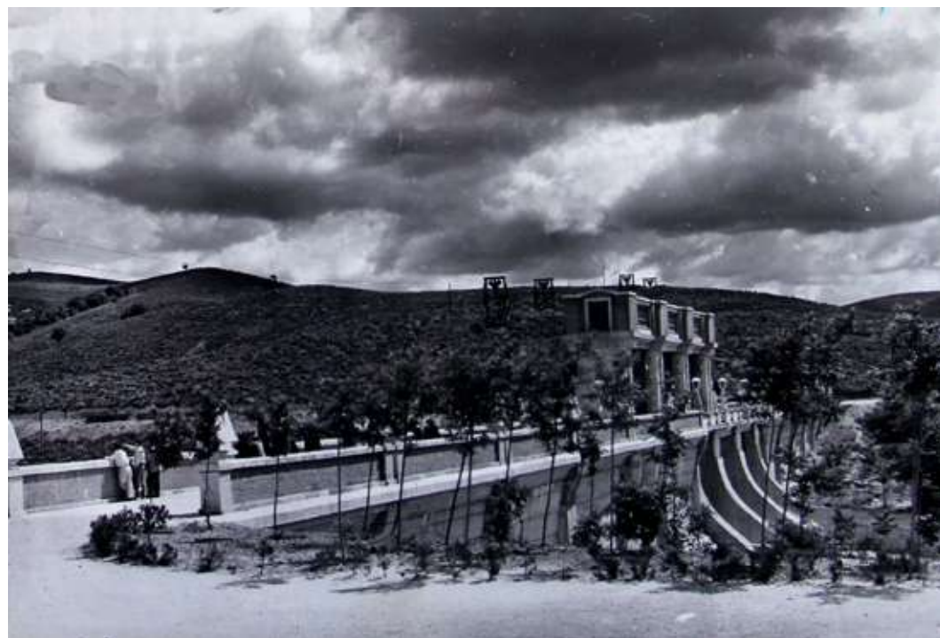
Figura 4.83. Aliviadero del Collado, pantano de El Vado, terminado. Junio de 1954
