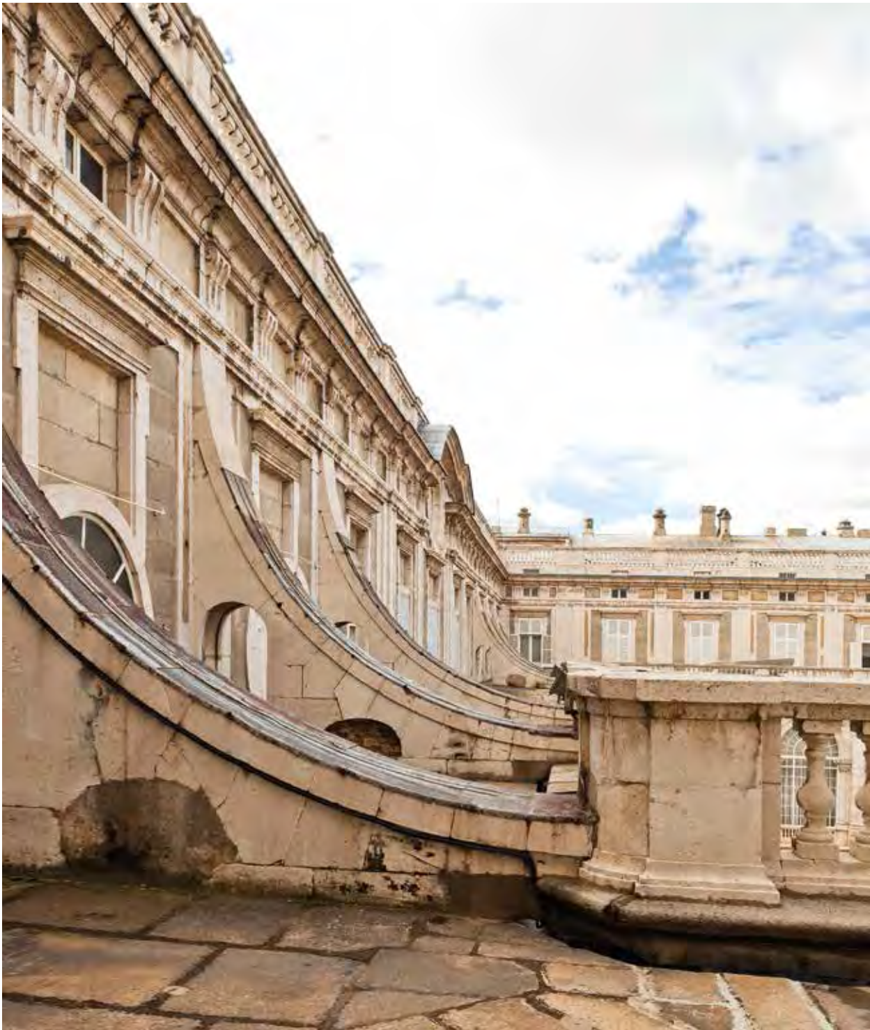
[il. 101] Contrafuertes de las bóvedas centrales (detalle). Madrid, Palacio Real.
