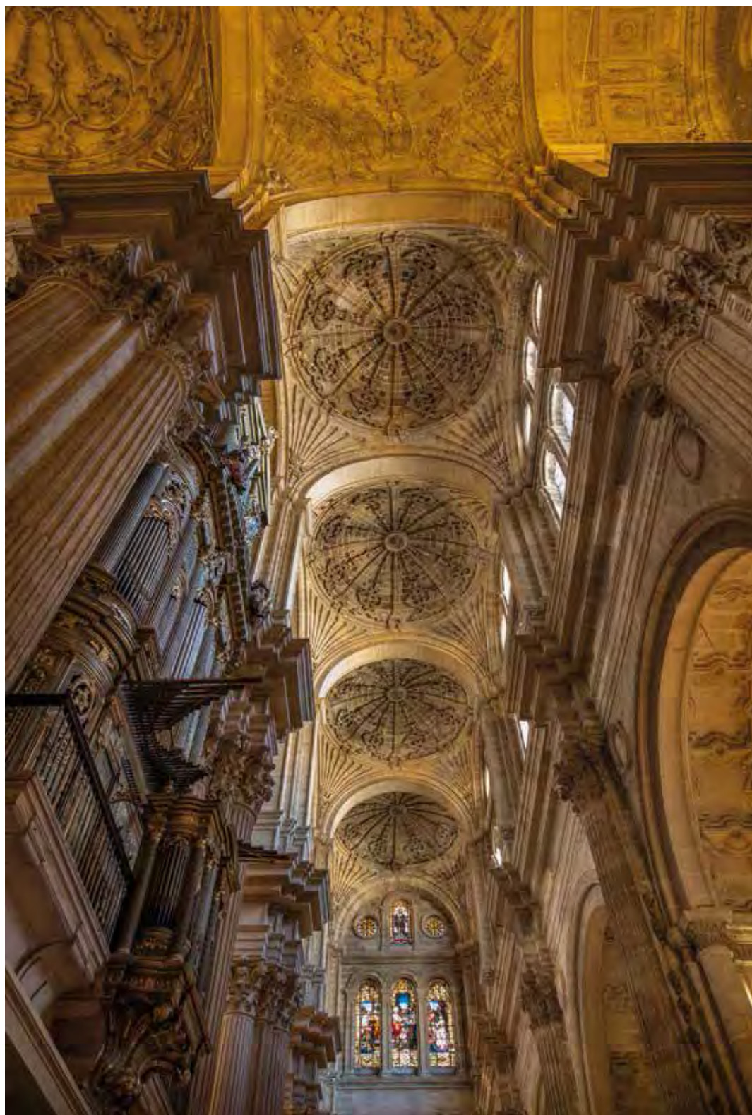
[il. 40] Andrés de Vandelvira, Bóvedas vaídas de la nave lateral de la epístola , (detalle), h. 1550. Málaga, Catedral de la Encarnación. Madrid, Instituto del Patrimonio Cultural de España. Ministerio de Educación, Cultura y Deporte.
