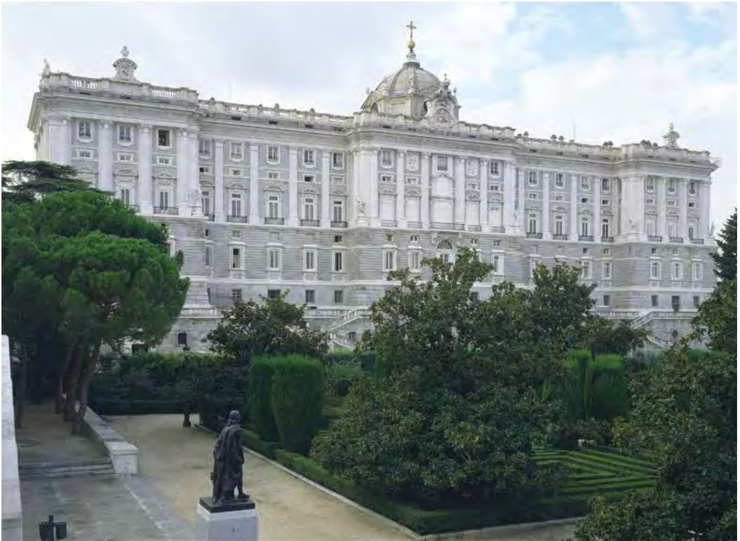
[il. 102] Fachada norte, vista general. Madrid, Palacio Real.
