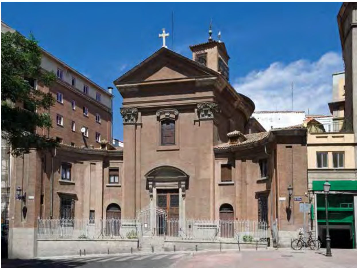
[il. 108] Ventura Rodríguez, Iglesia de San Marcos , Madrid. Comunidad de Madrid. Dirección General de Patrimonio Cultural.
