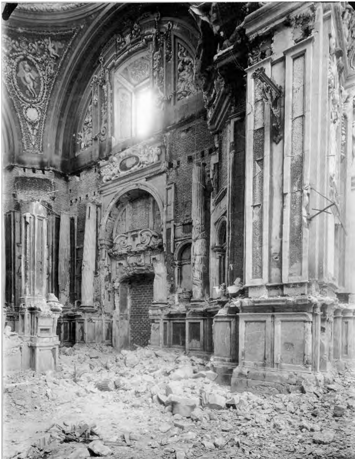
[il. 89] Vicente Moreno, Estado en que se encuentra la parte derecha del presbiterio de la capilla de San Isidro después del incendio sufrido el día 19 de julio de 1936 , imagen tomada el 6 de agosto de 1937. Madrid, Instituto del Patrimonio Cultural de España. Ministerio de Educación, Cultura y Deporte.
