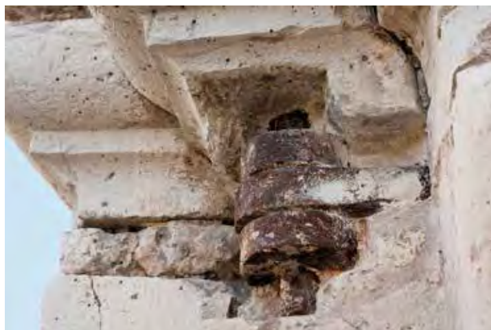
[il. 51] Restos del zuncho de hierro colocado por Ventura Rodríguez en la base del arranque de la torre noroeste de la Catedral de Valladolid.
