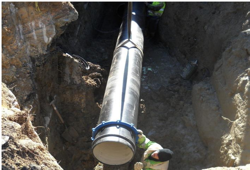
FIGURA 121. INSTALACIÓN DE TUBERÍA DE FUNDICIÓN DÚCTIL
