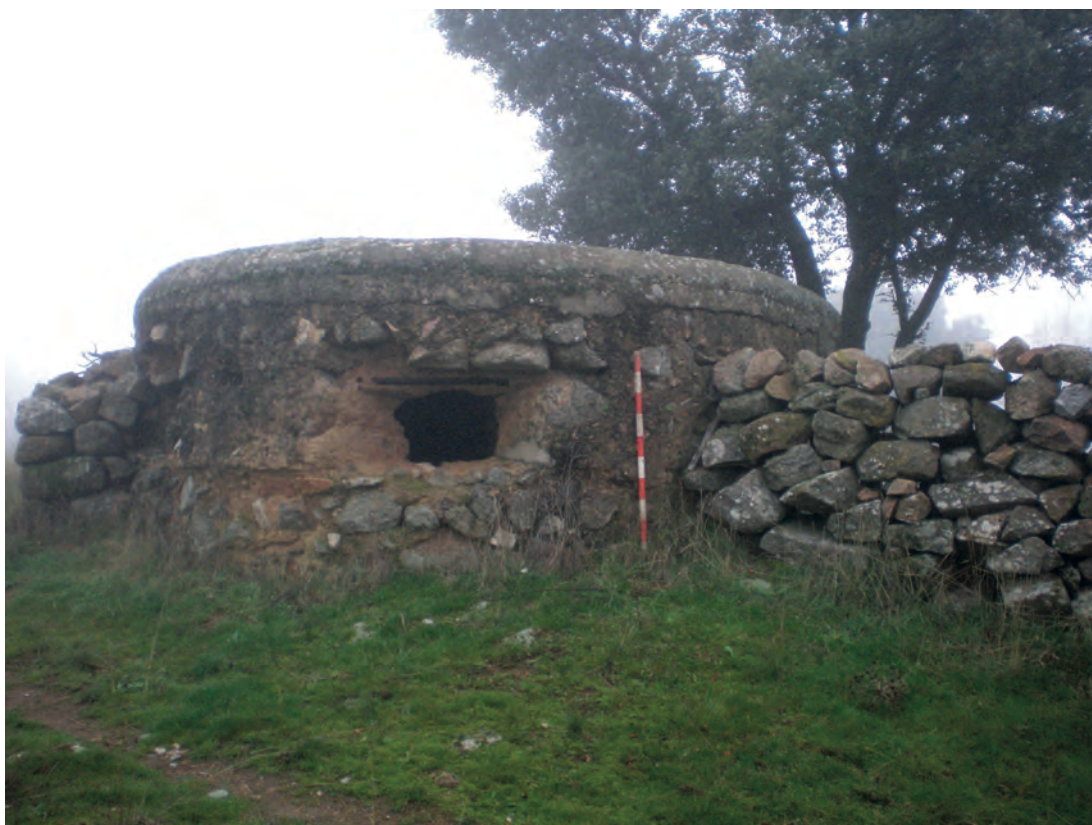
Fig. 8 Fortín de mampostería en Fresnedillas de la Oliva.
