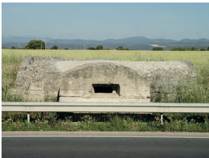
Fig. 49 Fortín cruciforme de hormigón armado situado junto a la Carretera de Brunete a Villanueva de la Cañada (Madrid). Dirección General de Patrimonio Cultural.
