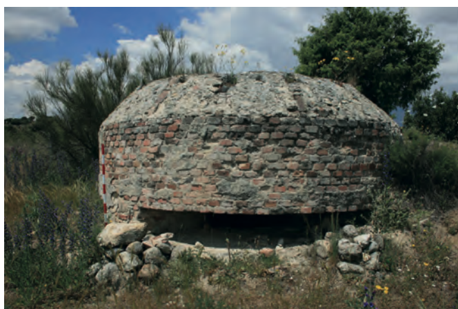
Fig. 54 El muro exterior de ladrillo de este Nido de Ametralladora en Valdemorillo no cumple una función estructural ni de blindaje; es el encofrado de la masa de hormigón armado que lo conforma (Pablo Schnell Quiertant).
