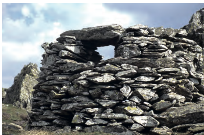
Fig. 35 Construcción militar de roca local (neiss) situada en el entorno del Puerto de la Hiruela (Madrid). Dirección General de Patrimonio Cultural.
