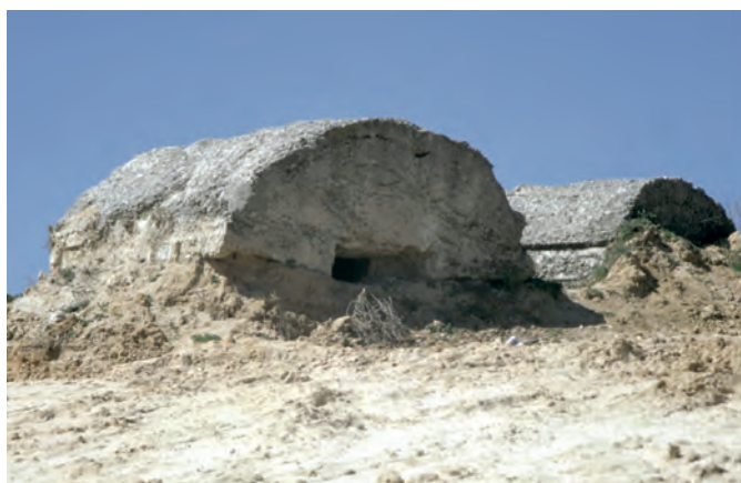
Fig. 6 Casamatas tipo CGIS en el entorno de la Carretera de La Coruña. Colonia Camarines (Madrid). Dirección General de Patrimonio Cultural
