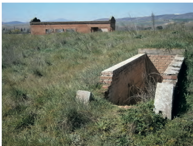
Fig. 5 Estructuras del aeródromo republicano de Talamanca de Jarama. Dirección General de Patrimonio Cultural.
