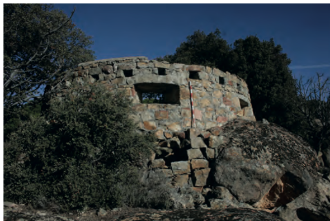
Fig. 47 Alternancia de aspilleras para fusil y tronera para ametralladora en un fortín de El Escorial (Pablo Schnell Quiertant).
