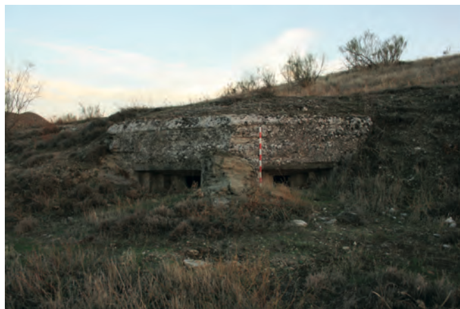
Fig. 48 Troneras con derrame escalonado (Aranjuez) (Pablo Schnell Quiertant).
