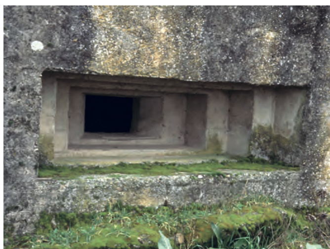
Fig. 61 Detalle de tronera con derrame de nido de ametralladora del término municipal de Ciempozuelos (Madrid). Dirección General de Patrimonio Cultural.
