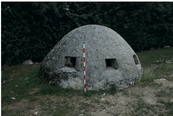
Fig. 20 Puesto de escuadra hemisférico con el que se estaba experimentando al acabar la guerra en el frente nacional (Brunete) (Pablo Schnell Quiertant).
