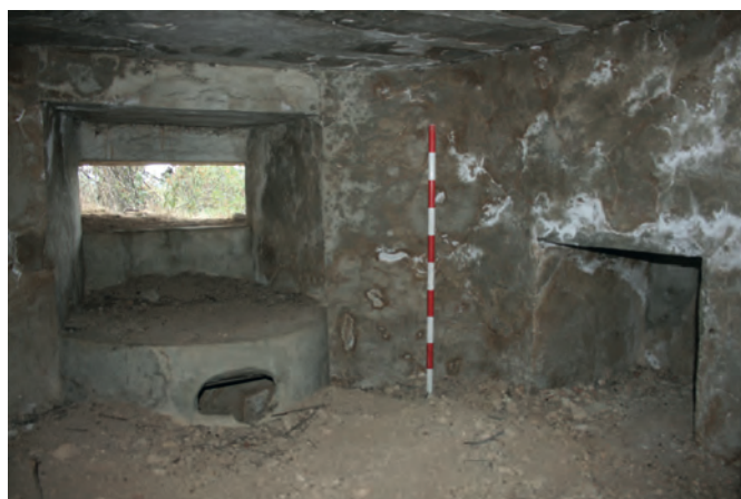
Fig. 22 Interior de un Nido de Ametralladora en el que se aprecia el banco para el arma y los armarios para munición y repuestos (Pablo Schnell Quiertant).
