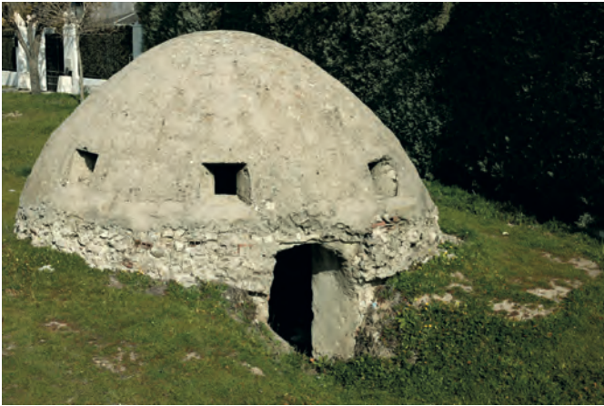
Fig. 52 Puesto de escuadra de hormigón. Término de Brunete (Madrid). Dirección General de Patrimonio Cultural.
