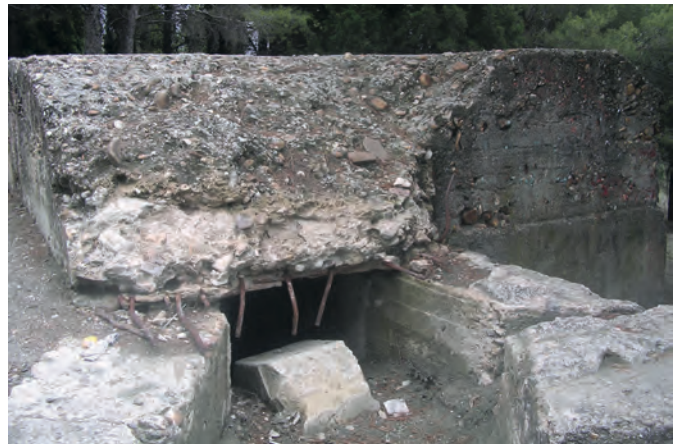
Fig. 52 Corte en el techo blindado de una obra en Getafe que deja ver la composición del hormigón (Pablo Schnell Quiertant).
