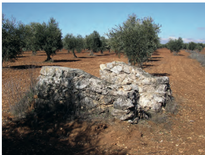
Fig. 55 Asentamiento para cañón antitanque de mampostería con argamasa de cemento en Morata de Tajuña (Pablo Schnell Quiertant).
