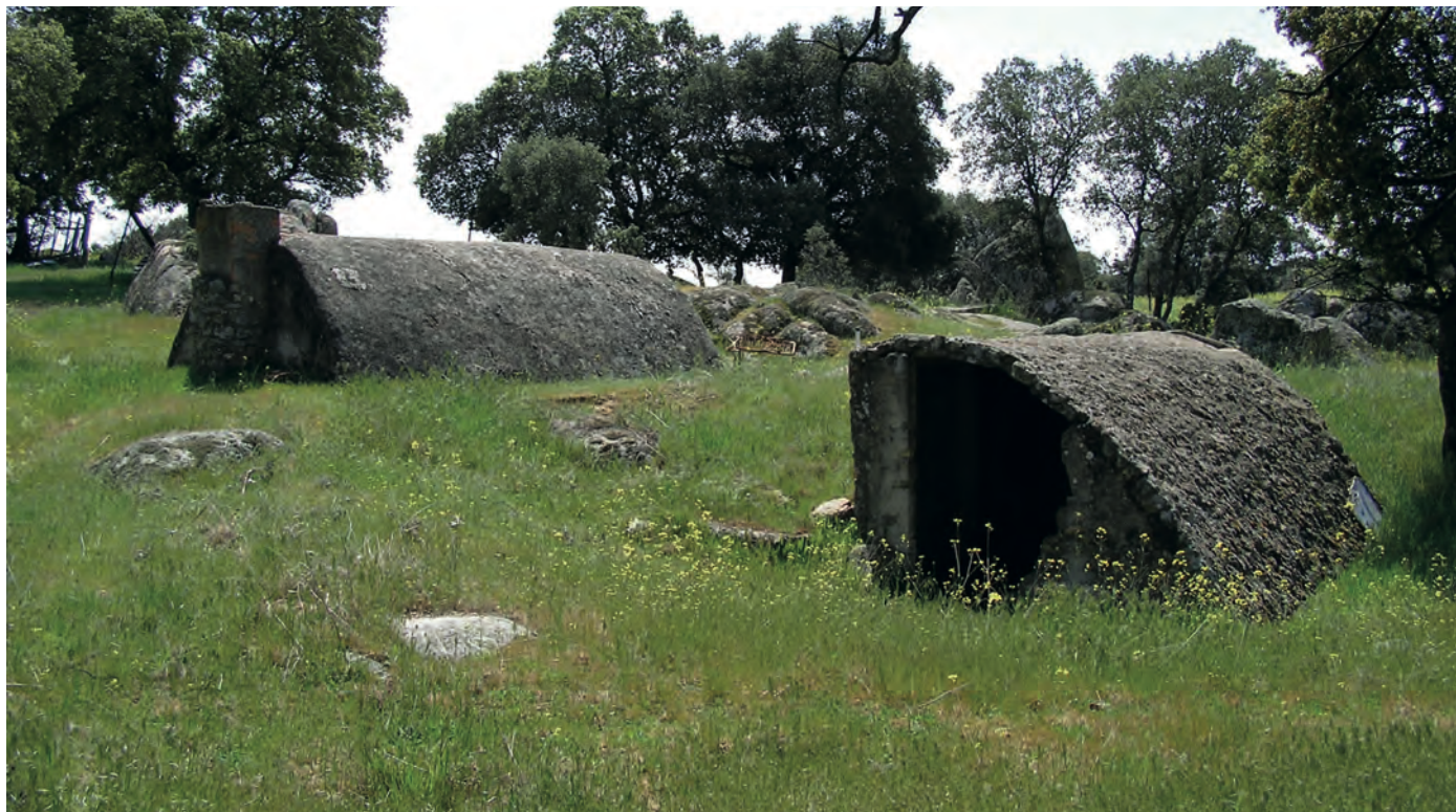
Fig. 36 Dos viviendas catenarias, una con la curva completa y chimenea francesa exenta y otra con el 60% de la curva (Navalagamella) (Pablo Schnell Quiertant).
