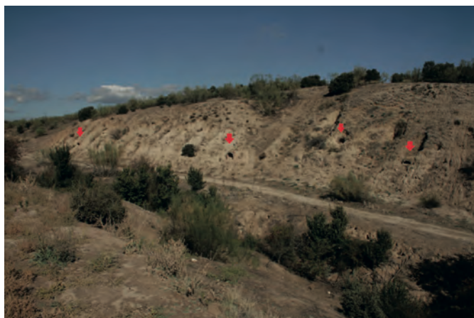
Fig. 32 Batería de refugios en caverna (Majadahonda) situados a contrapendiente (Pablo Schnell Quiertant).
