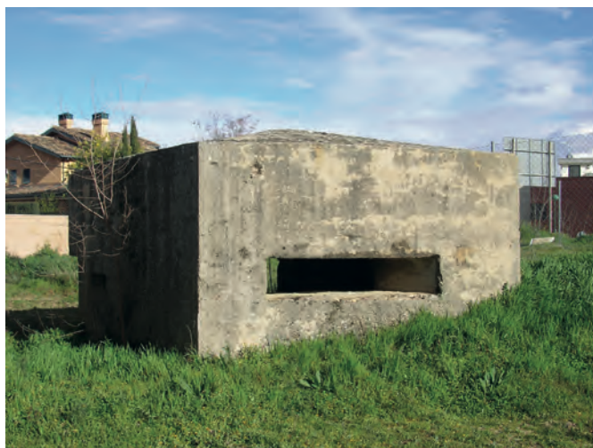
Fig. 53 Nido de Ametralladora encofrado de hormigón (Pozuelo) (Pablo Schnell Quiertant).
