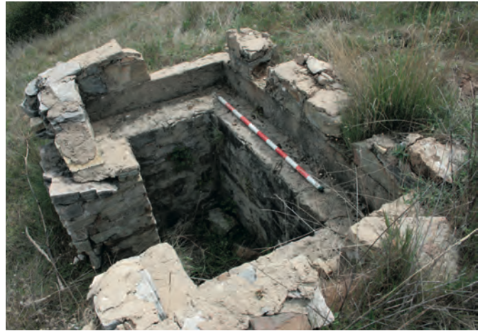
Fig. 17 Puesto de tirador en "T" construido con mampostería y argamasa de cemento (Valdemaqueda) (Pablo Schnell Quiertant).
