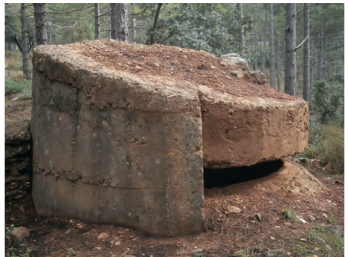
Fig. 55 Nido de ametralladora de hormigón armado del Frente del Agua. Paredes de Buitrago (Madrid). Dirección General de Patrimonio Cultural.
