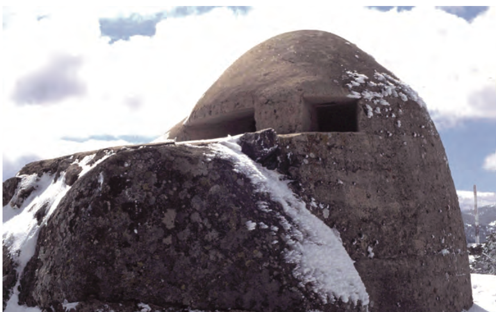
Fig. 14 Observatorio blindado situado en el Cerro de La Sevillana. Término de Guadarrama (Madrid). Dirección General de Patrimonio Cultural.
