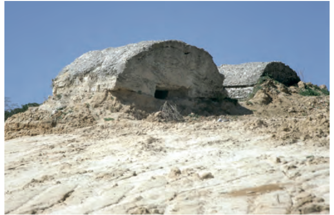
Fig. 53 Casamatas tipo CGIS de la Colonia Camarines. Aravaca (Madrid). Dirección General de Patrimonio Cultural.
