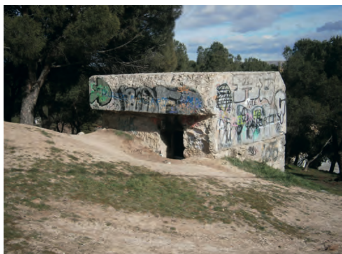
Fig. 60 Vista del acceso del nido de ametralladora de la Colonia Las Nogueras. Distrito municipal de Canillejas (Madrid). Dirección General de Patrimonio Cultural.
