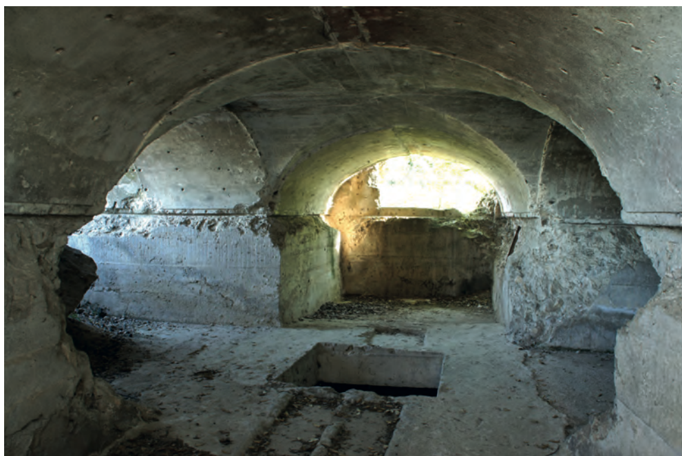
Fig. 13 Vista del interior de un fortín cruciforme de Brunete (Madrid). Dirección General de Patrimonio Cultural.
