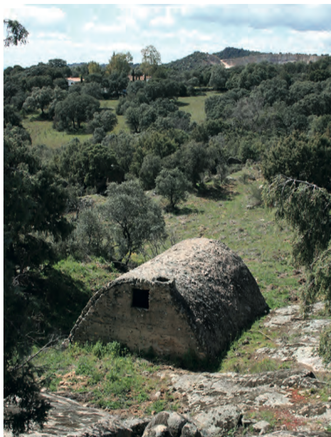
Fig. 37 Vivienda catenaria con chimenea francesa (Navalagamella) (Pablo Schnell Quiertant).
