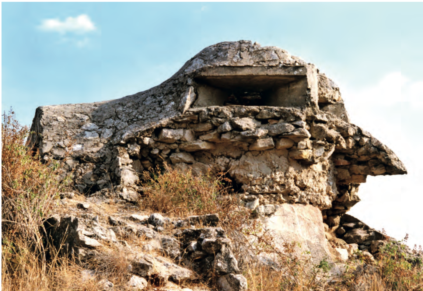
Fig. 71 Nido de ametralladora en el término de Fresnedillas de la Oliva (Madrid). Dirección General de Patrimonio Cultural.
