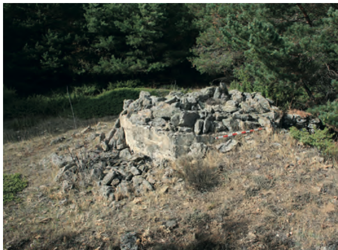
Fig. 45 Techo camuflado con piedras en un Nido de Ametralladora en Brajos (Pablo Schnell Quiertant).
