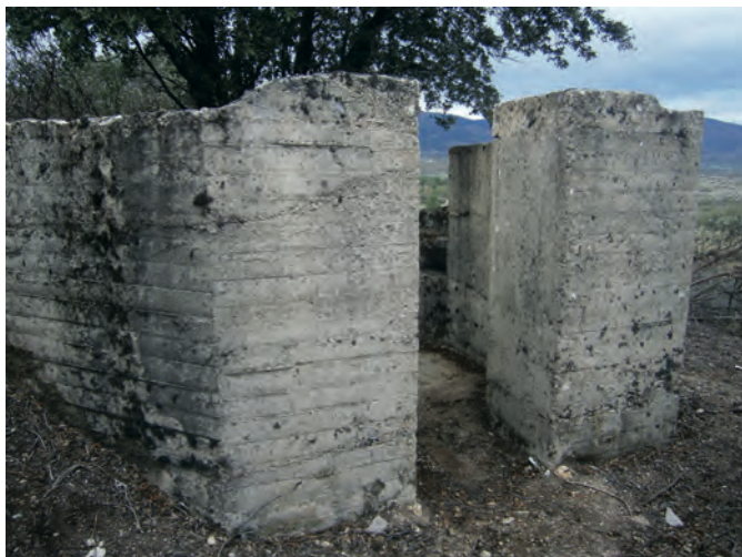
Fig. 87 Estructura de hormigón. Término de Guadarrama. Dirección General de Patrimonio Cultural.
