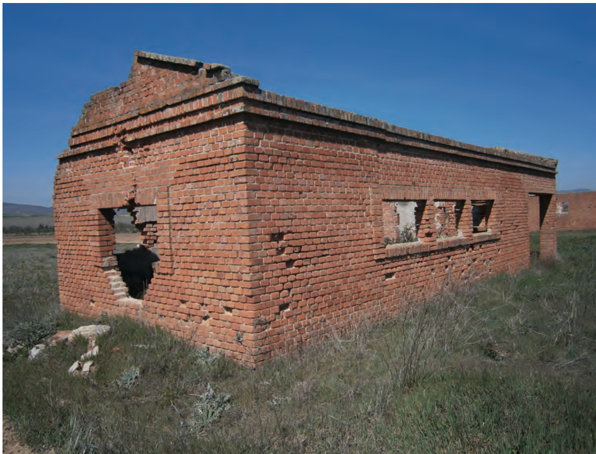
Fig. 69 Edificación del aeródromo republicano de Talamanca de Jarama. Madrid. Dirección General de Patrimonio Cultural.
