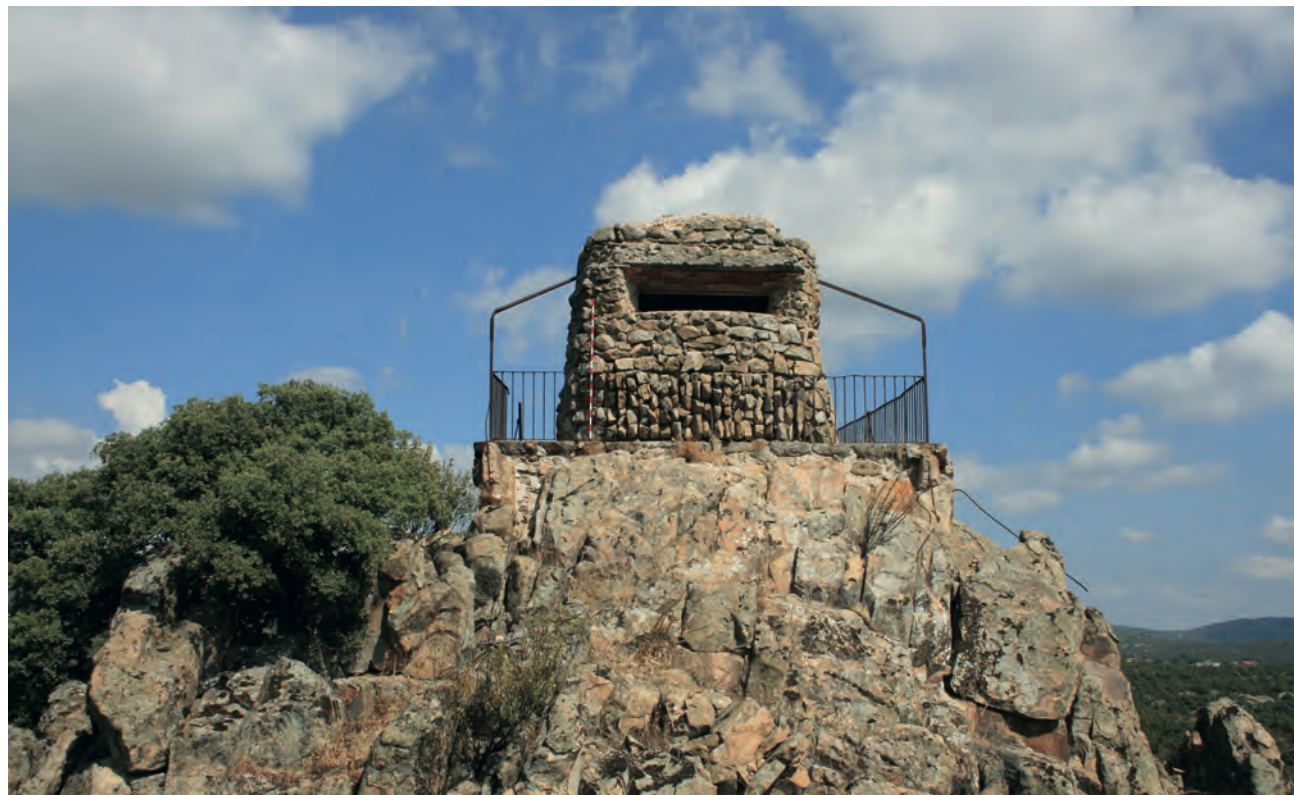
Fig. 40 Observatorio de Cantos Negros (Torrelodones). Su amplio vano no es una tronera para ametralladora, sino una visera de observación (Pablo Schnell Quiertant).
