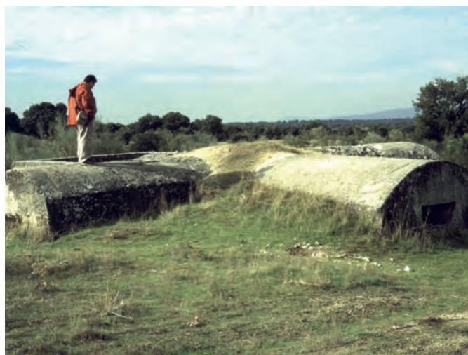
Fig. 50 Fortín cruciforme de hormigón armado del término de Quijorna (Madrid). Dirección General de Patrimonio Cultural.
