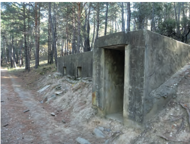
Fig. 56 Fachada del Puesto de Mando de El Pinar. Frente del Agua. Paredes de Buitrago (Madrid). Dirección General de Patrimonio Cultural.
