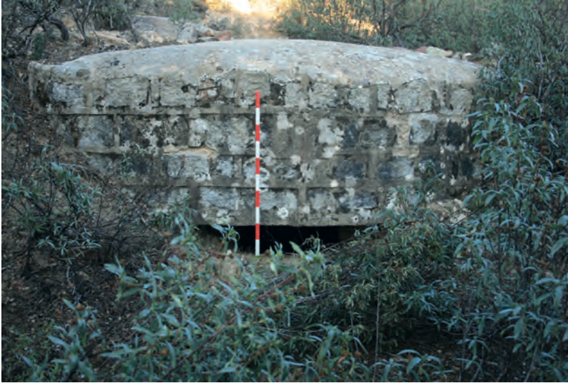
Fig. 56 Nido de Ametralladora con encofrado perdido de sillares. Se le ha dado un acabado muy cuidado con el llagueado de las juntas y la estrella roja esgrafiada, colocada boca abajo (Pablo Schnell Quiertant).
