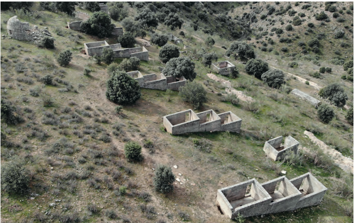
Fig. 35 Excepcionales barracones de hormigón encofrado en Navalagamella (Miguel Ángel Bru Castro).
