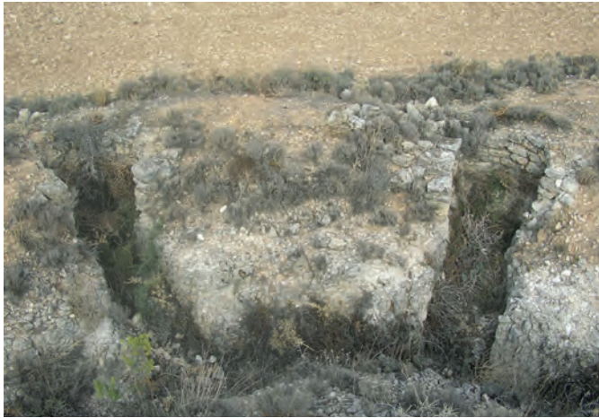
Fig. 16 Pozos de tirador adelantados a la trinchera y unidos por un corto ramal en Morata de Tajuña (Pablo Schnell Quiertant).
