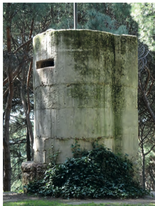
Fig. 10 Observatorio blindado ubicado en el Parque del Oeste (Madrid). Dirección General de Patrimonio Cultural.
