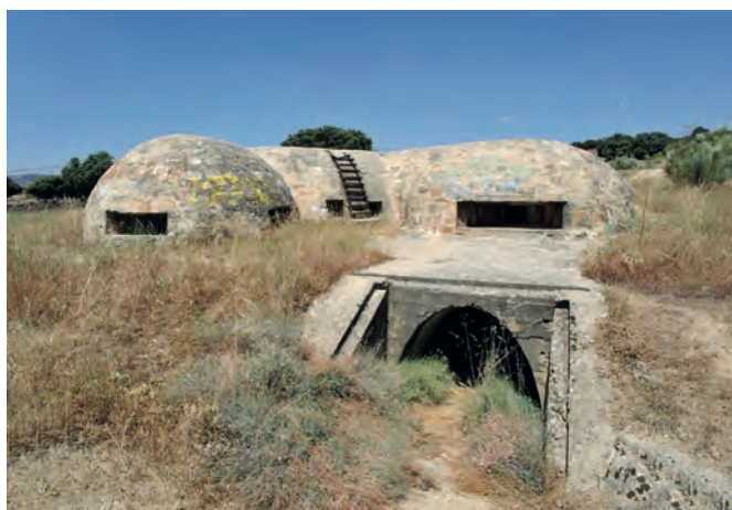
Fig. 9 Fortificación denominada Blockhaus 13. Colmenar de Arroyo (Madrid). Dirección General de Patrimonio Cultural
