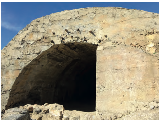
Fig. 96 Detalle de una estructura de la Posición Calvario. Navalagamella (Madrid). Dirección General de Patrimonio Cultural.
