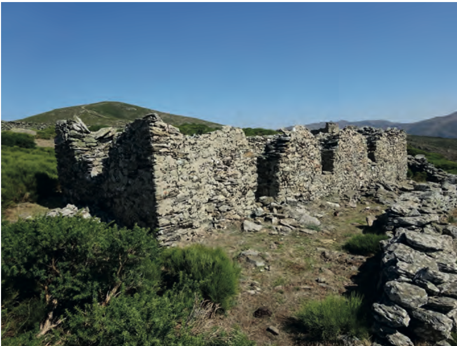
Fig. 22 Barracón construido con piedra local en la cuerda de las Cebolleras. Término de Somosierra. (Madrid). Dirección General de Patrimonio Cultural.
