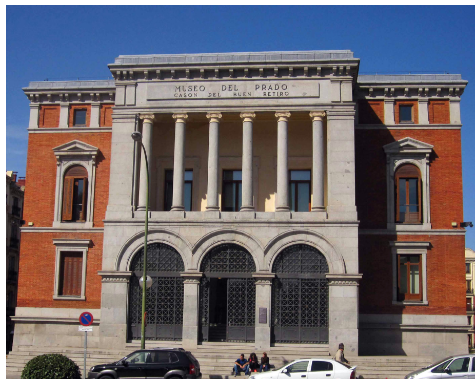
Fig 8. Fachada principal del Casón del Buen Retiro
