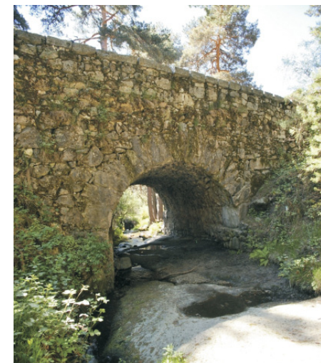
Fig. 14 Puente del Descalzo
